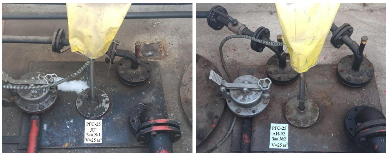
Рисунок 2 – Горловины резервуаров РГС-25 зав.№№1, 2
