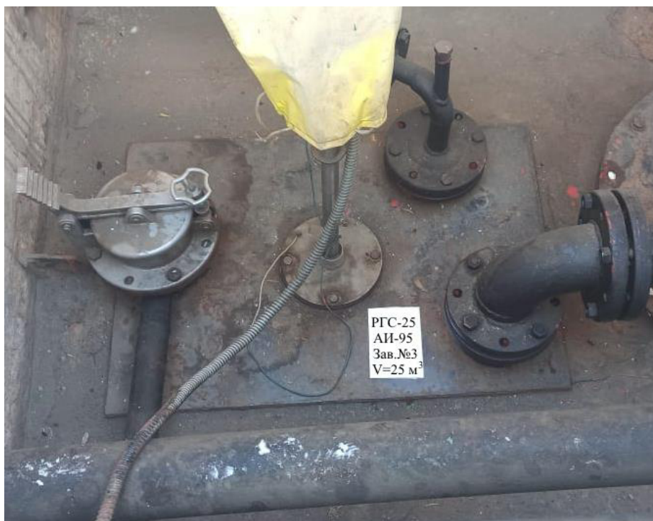
Рисунок 3 – Горловина резервуара РГС-25 зав.№3
