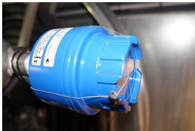
Рисунок 6 – Пломбирование датчика температуры
