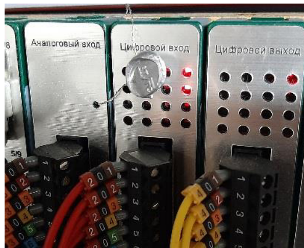
Рисунок 4 – Пломбирование платы аналогового входа контроллера
