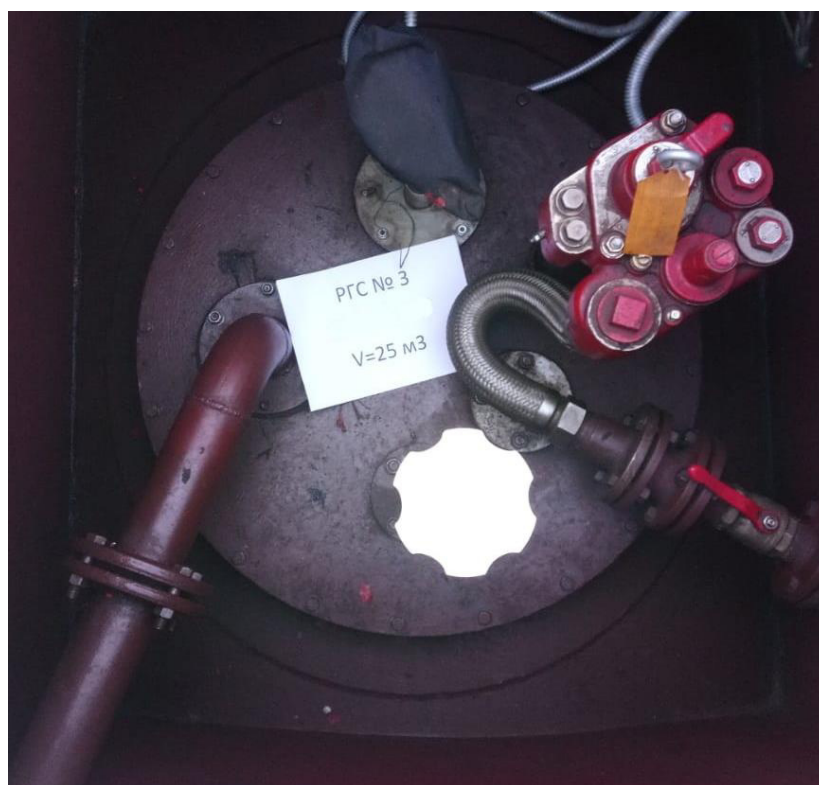
Рисунок 4 – Горловина резервуара РГС-25 зав.№ 3
