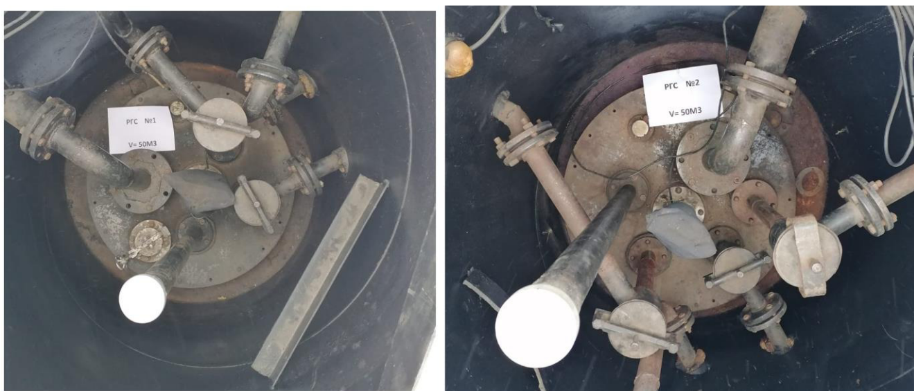
Рисунок 4 – Горловины резервуаров РГС-50 зав.№№1, 2
