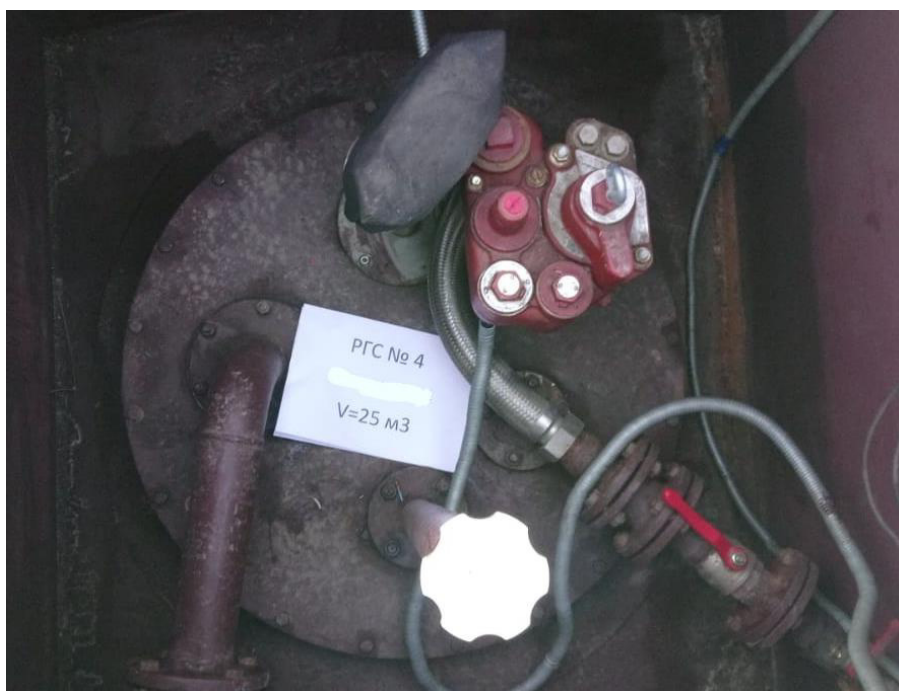
Рисунок 5 – Горловина резервуара РГС-25 зав.№ 4
