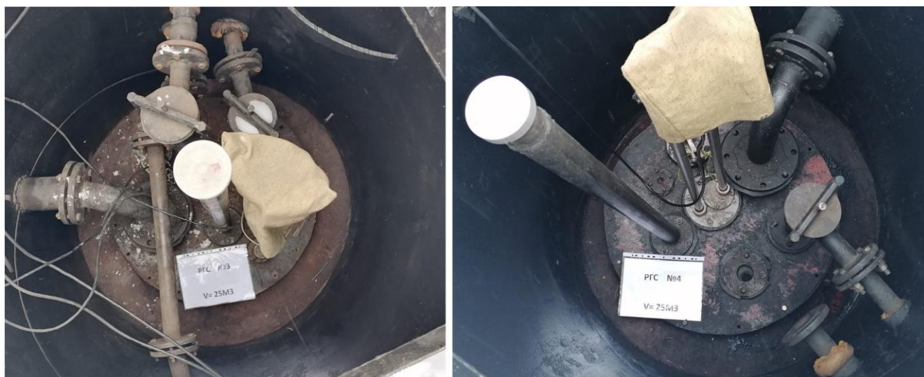
Рисунок 3 – Горловины резервуаров РГС-25 зав.№№3, 4
