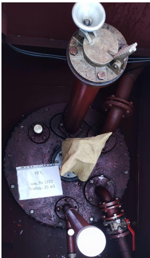
Рисунок 4 – Горловина резервуара РГС-25 зав.№ 1272
