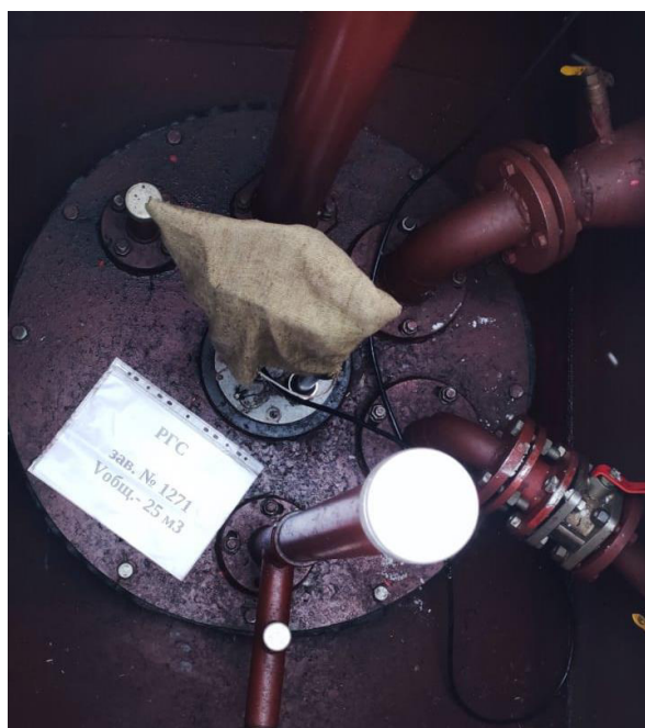
Рисунок 3 – Горловина резервуара РГС-25 зав.№ 1271
