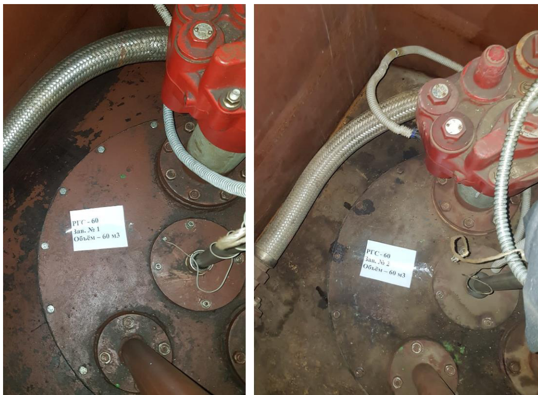
Рисунок 3 – Горловины резервуаров РГС-60 зав.№№1, 2
