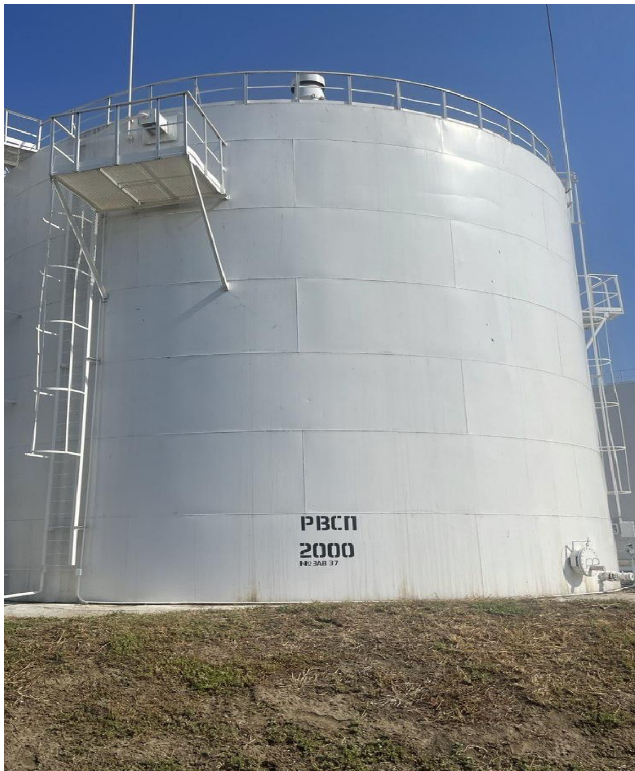
Рисунок 1 - Фотография общего вида резервуара РВСП - 2000 заводской номер 37
