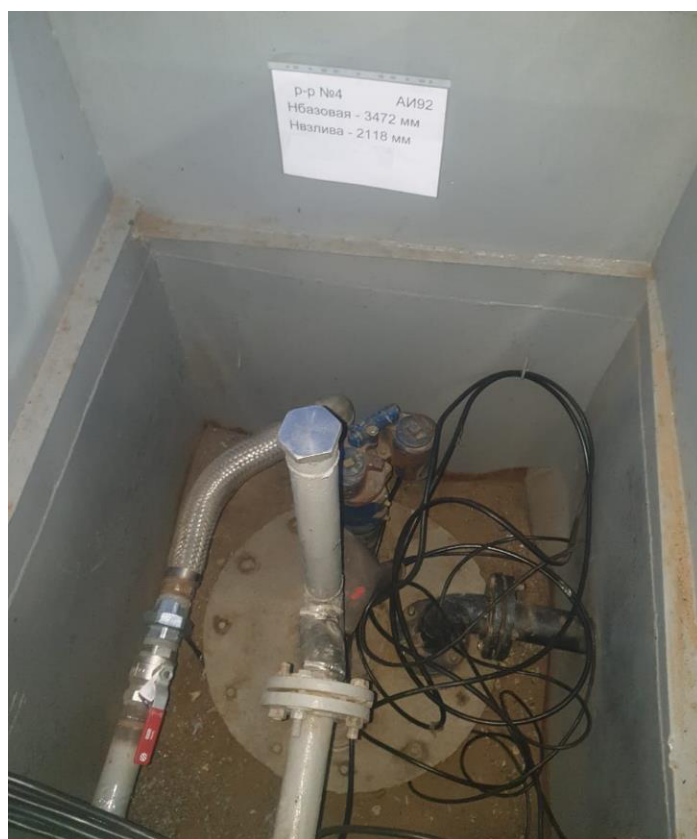
Рисунок 2 – Горловина резервуара РГС-20 №4
