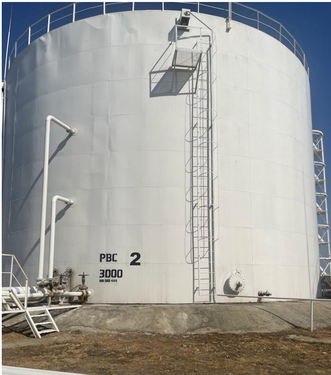
Рисунок 1 - Фотография общего вида резервуара РВС - 3000 заводской номер 444
