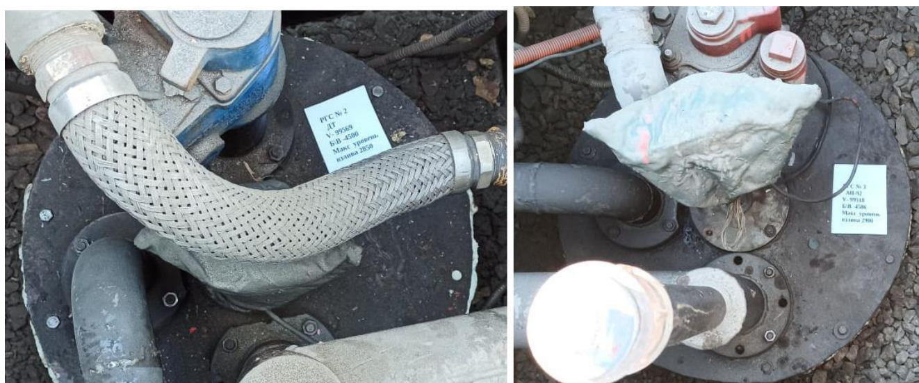
Рисунок 4 –Горловины резервуаров РГС-100 №№2, 3
