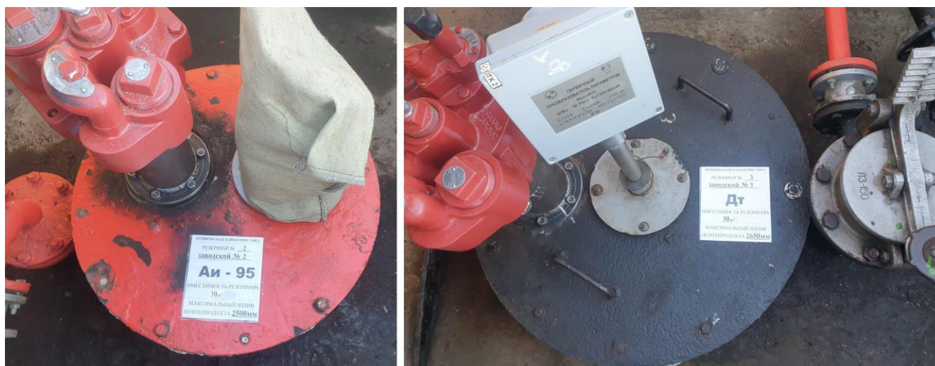
Рисунок 2 –Горловины резервуаров РГС-30 №№2, 3
