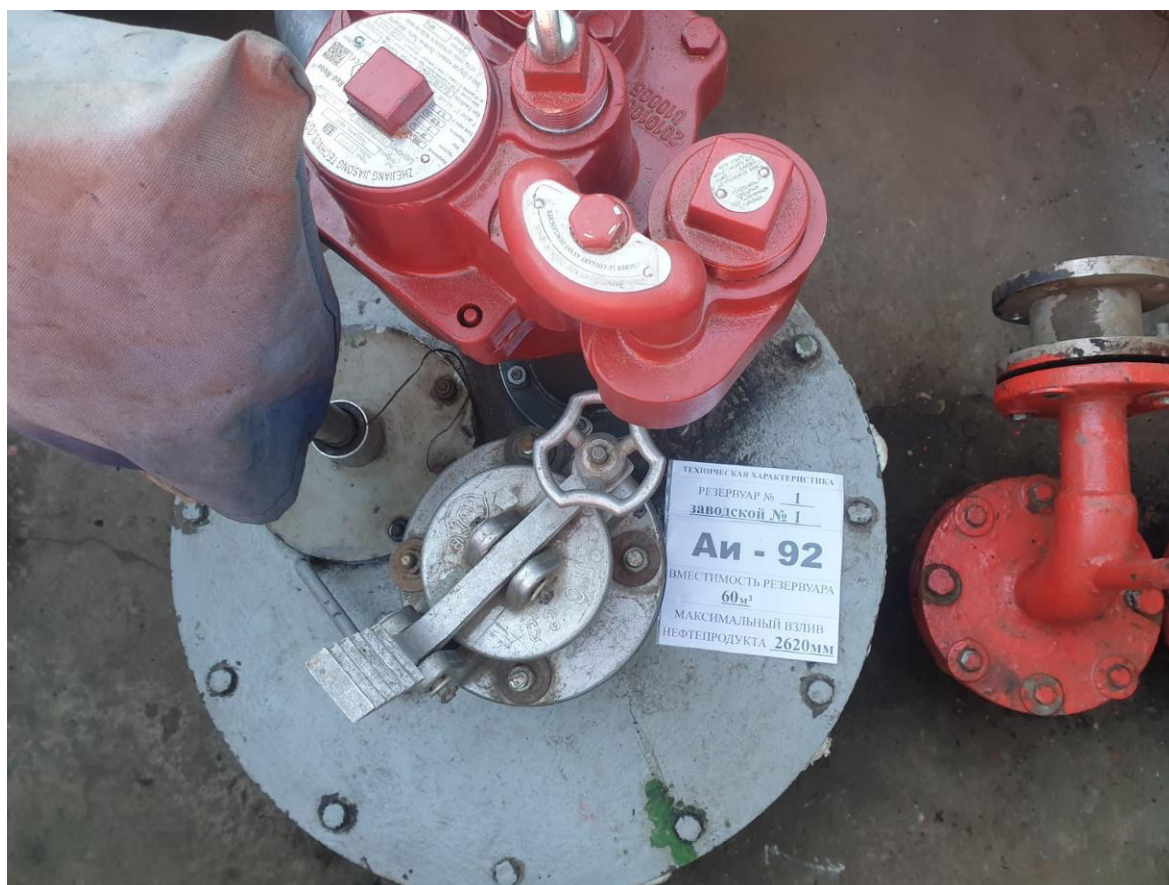
Рисунок 3 –Горловина резервуара РГС-60 №1
