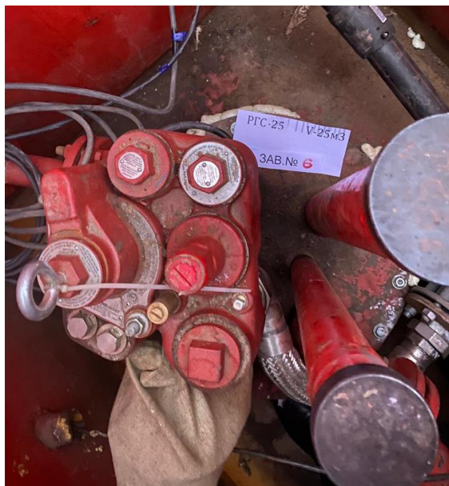
Рисунок 3 – Горловина резервуара РГС-25 зав.№ 6
