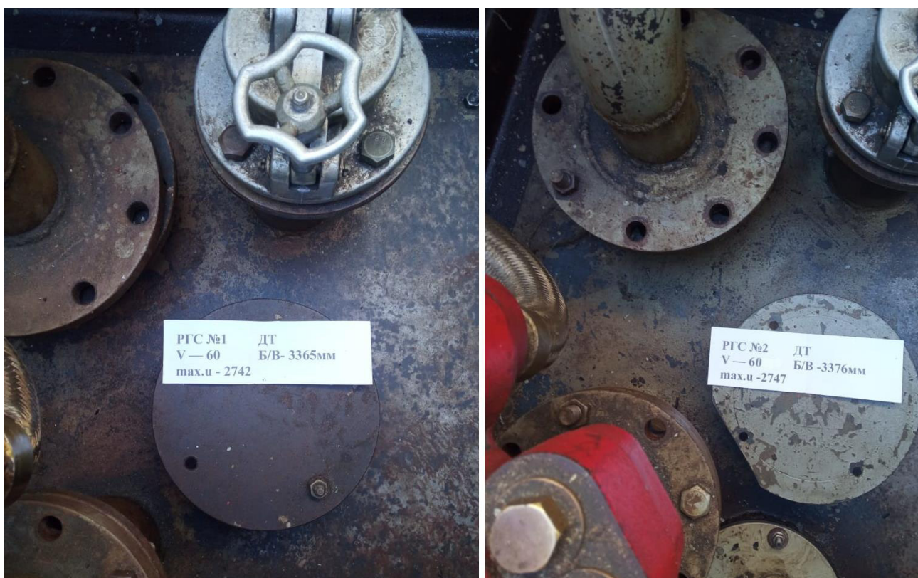
Рисунок 2 – Горловины резервуаров РГС-60 зав.№№1, 2
