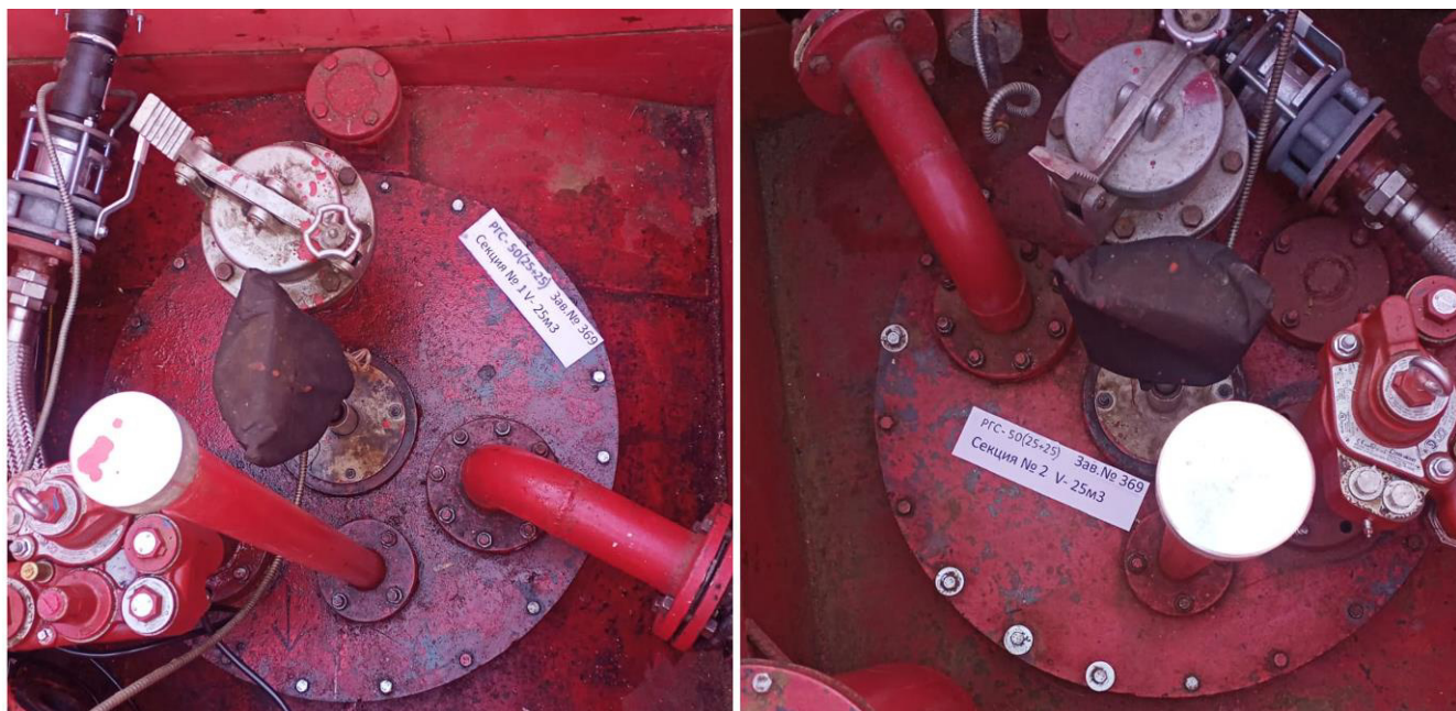
Рисунок 2 – Горловины резервуара РГС-50 (25+25) зав.№ 369
