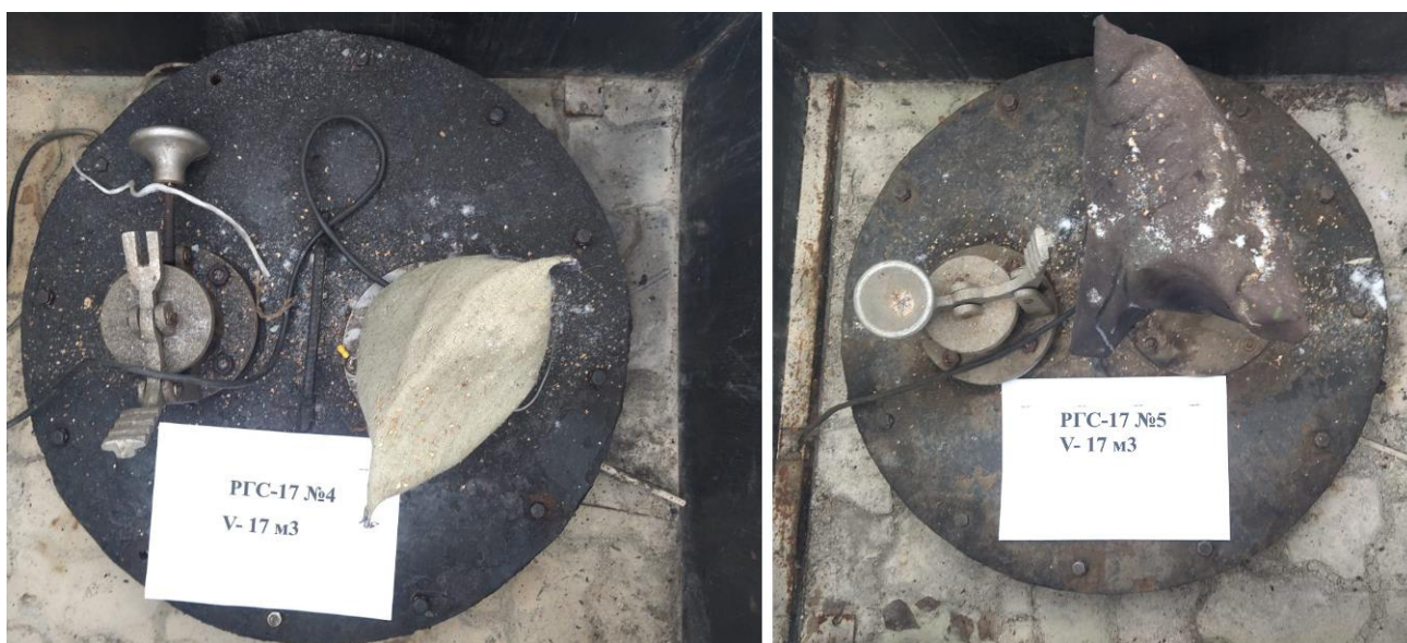
Рисунок 3 – Горловины резервуаров РГС-17 зав.№№ 4, 5
