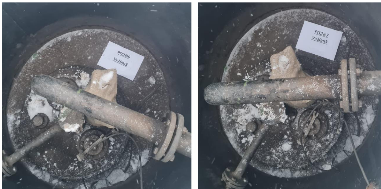
Рисунок 3 – Горловины резервуаров РГС-20 зав.№№6, 7
