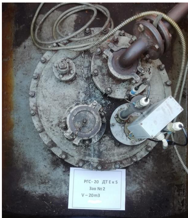
Рисунок 2 – Горловина резервуара РГС-20
