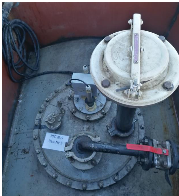
Рисунок 2 – Горловина резервуара РГС-20
