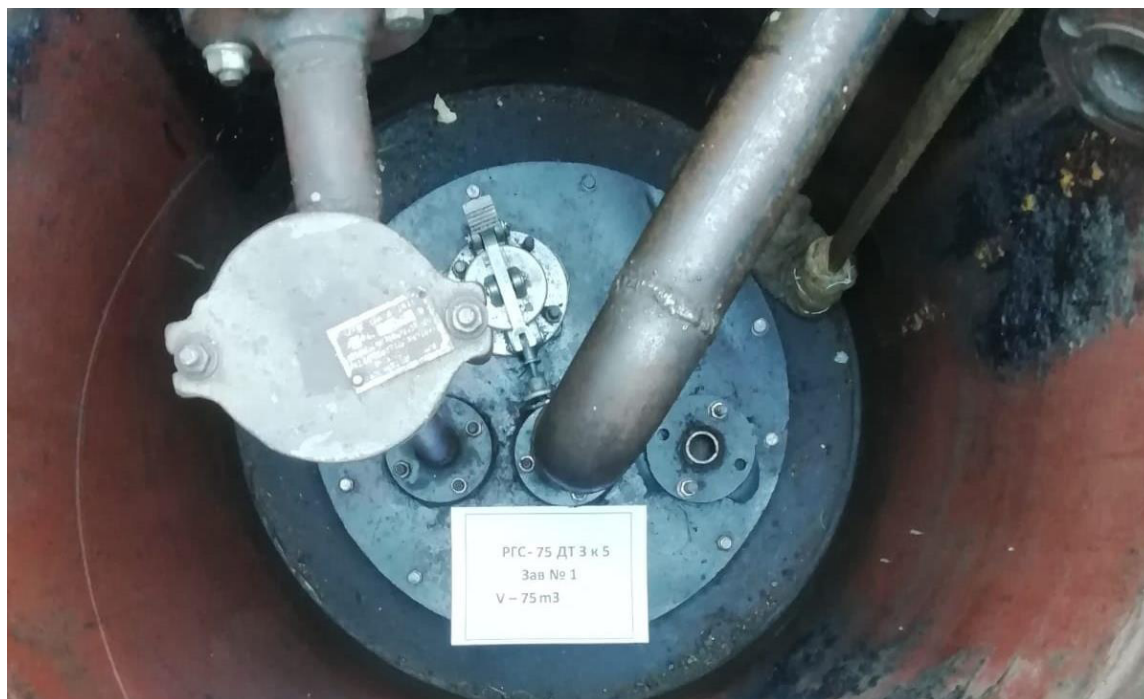
Рисунок 2 – Горловина резервуара РГС-75
