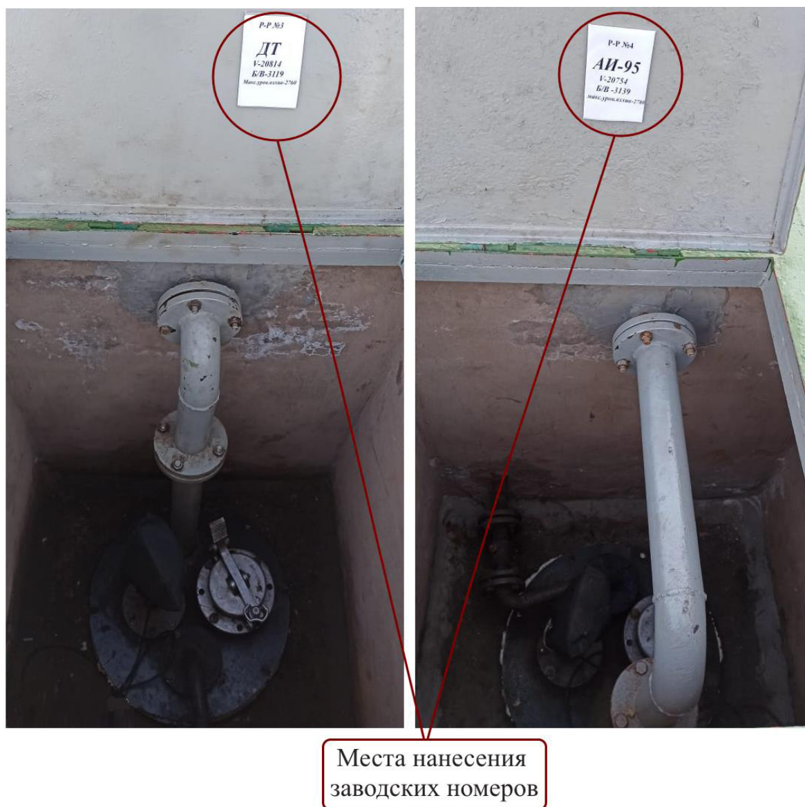
Рисунок 3 – Горловины резервуаров РГС-20 зав.№№ 3, 4 с указанием мест нанесения заводских номеров
