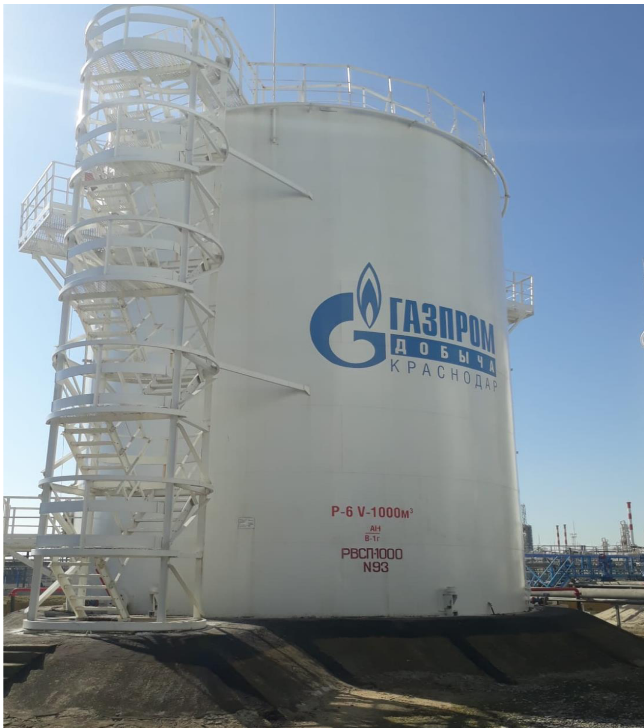
Рисунок 3 - Фотография общего вида резервуара РВСП-1000 заводской номер 93
