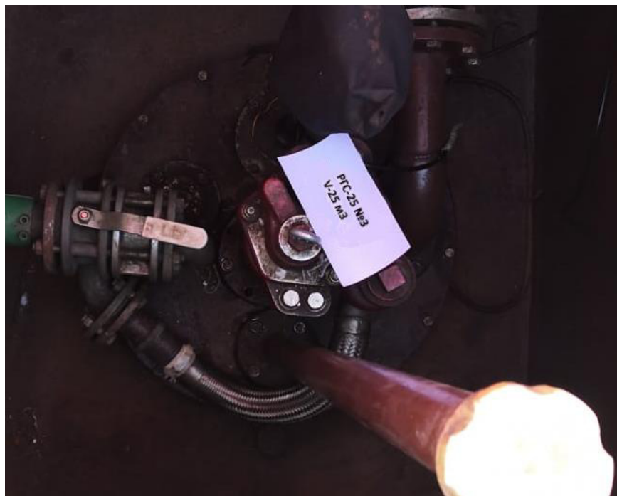
Рисунок 2 – Горловина резервуара РГС-25
