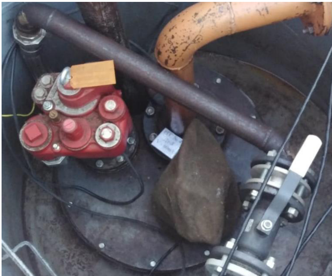
Рисунок 3 – Горловина резервуара РГС-60 зав.№ 4
