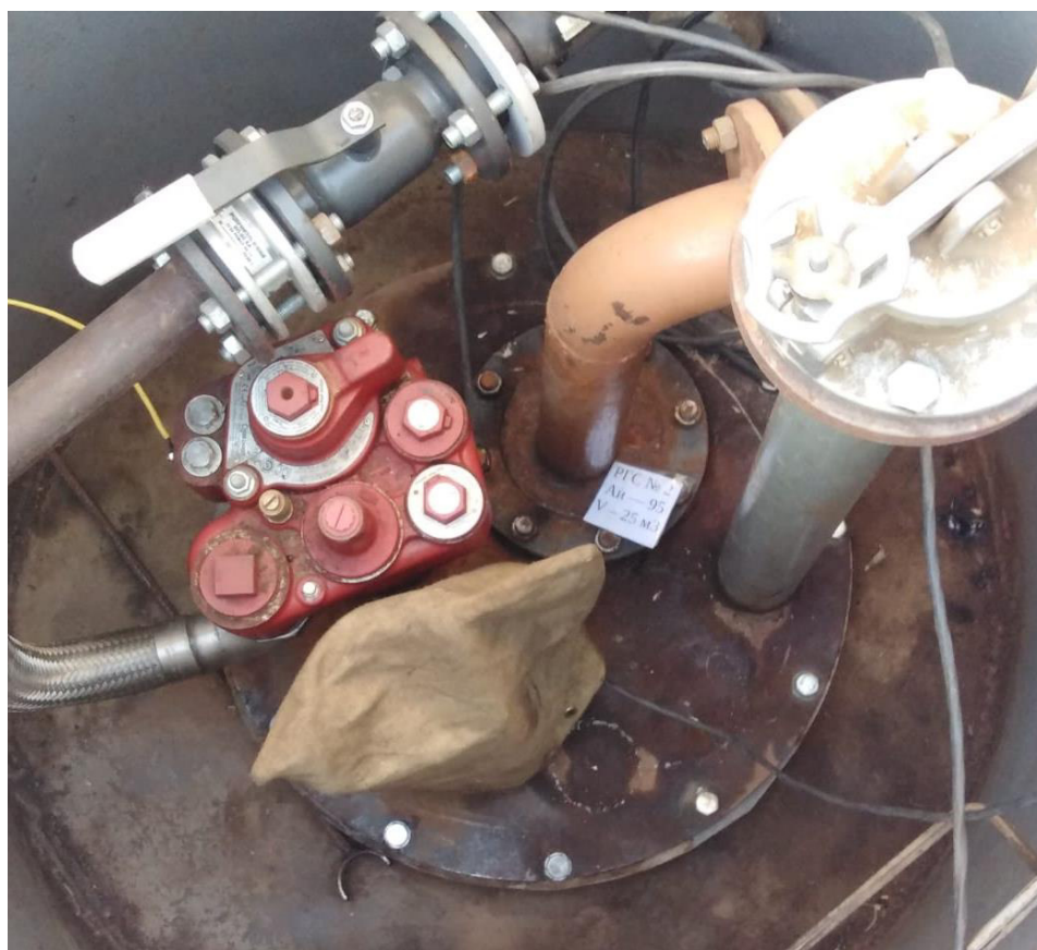
Рисунок 2 – Горловина резервуара РГС-25 зав.№ 2
