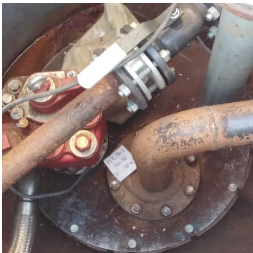
Рисунок 2 – Горловина резервуара РГС-60 зав.№ 1
