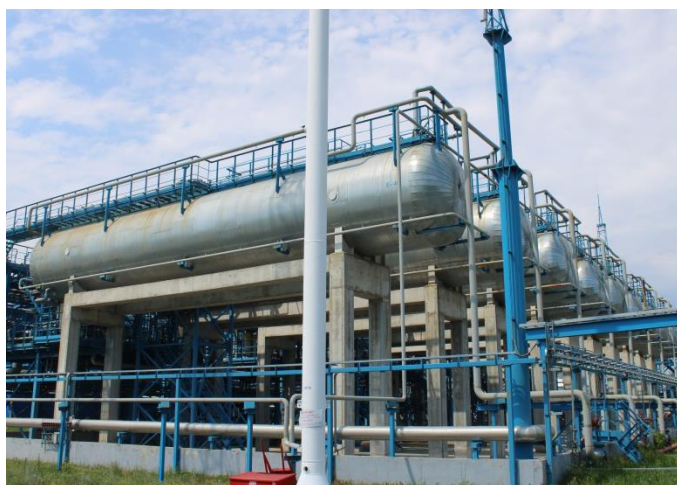
Рисунок 1 – Общий вид резервуаров
