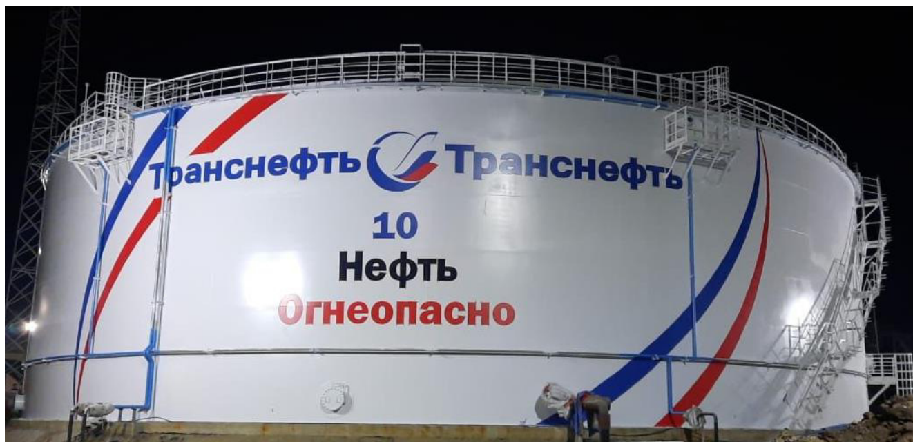
Рисунок 1 – Общий вид резервуара РВСП-20000 №10
