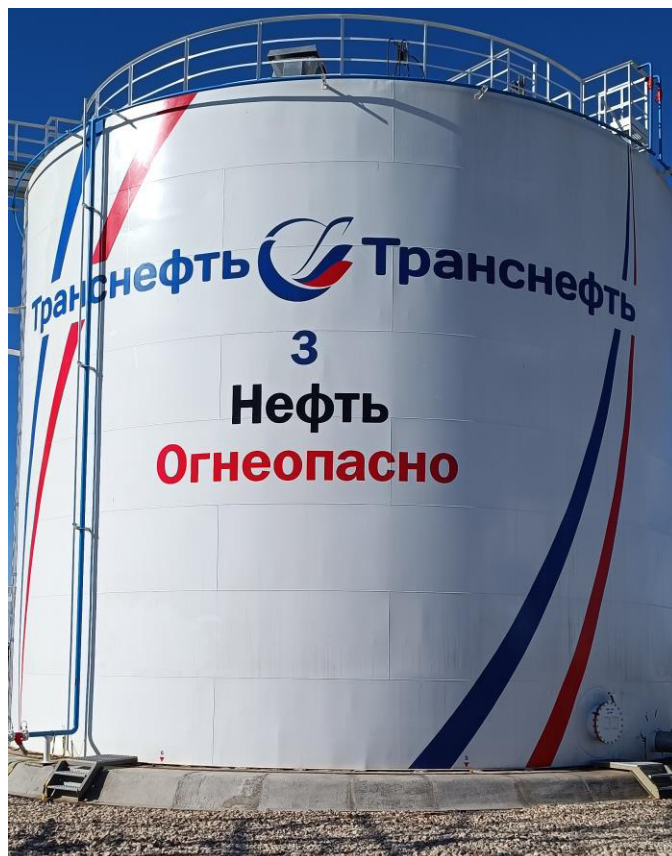
Рисунок 1 – Общий вид резервуара РВС-2000 зав.№ 3
