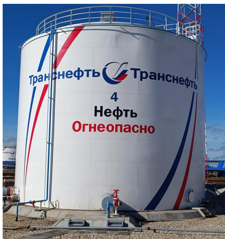
Рисунок 2 – Общий вид резервуара РВС-2000 зав.№ 4
