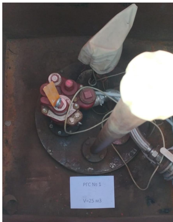
Рисунок 2 – Горловина резервуара РГС-25
