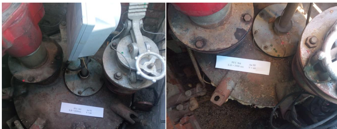
Рисунок 3 – Горловины резервуаров РГС-60 зав.№3, 4
