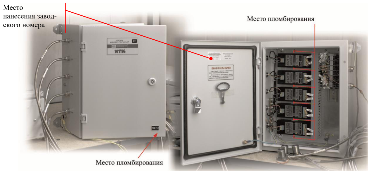
Рисунок 1 – Шкафы с измерительными преобразователями
