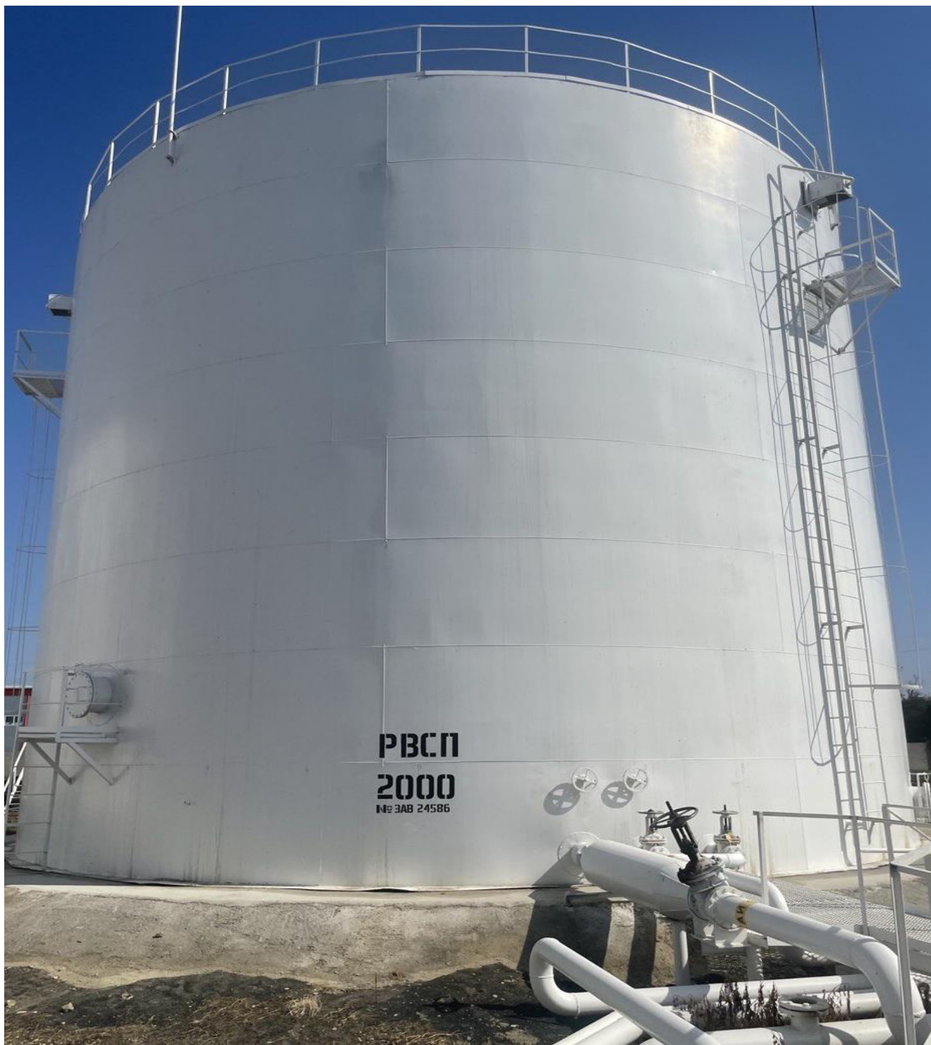
Рисунок 1 - Фотография общего вида резервуара РВСП-2000 заводской номер 24586
