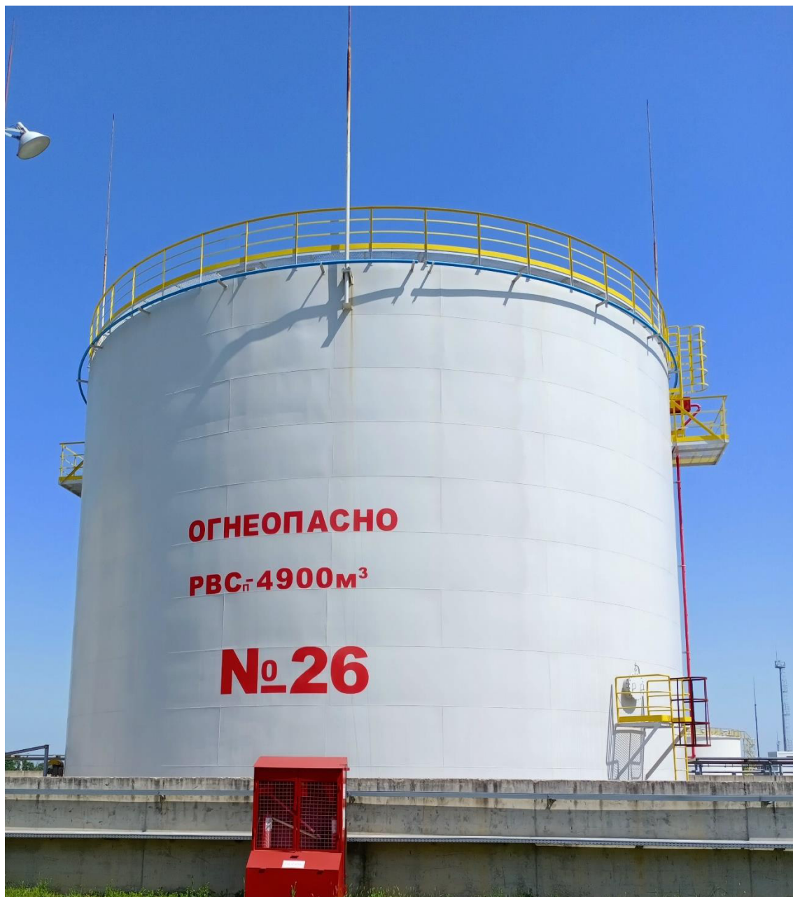
Рисунок 1 - Фотография общего вида резервуара РВСП-4900 заводской номер 26
