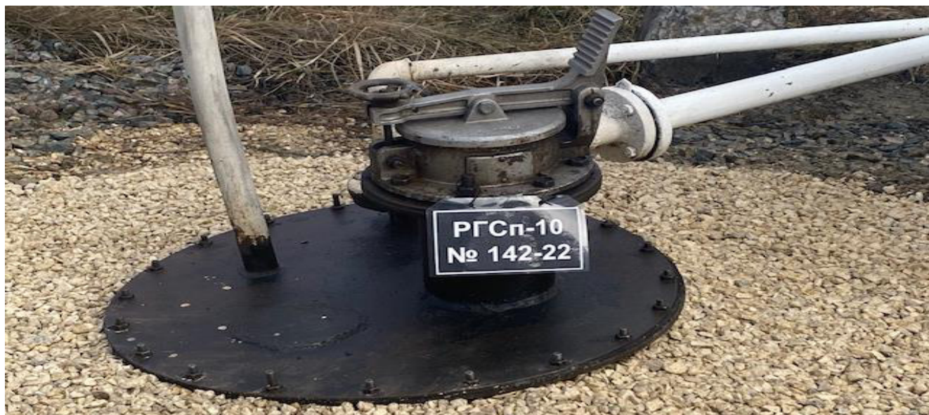
Рисунок 1 - Место нанесения заводского номера резервуара РГСп-10
