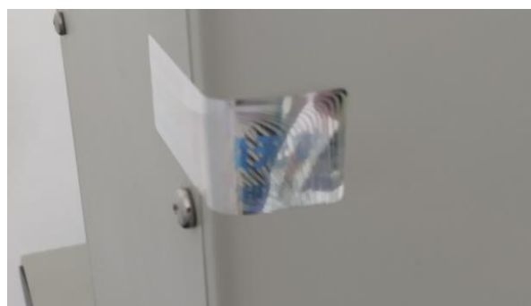
Рисунок 4– Пример нанесения пломбировочной наклейки
