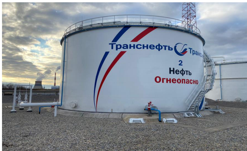
Рисунок 1 - Общий вид резервуара стального вертикального цилиндрического РВС-5000
