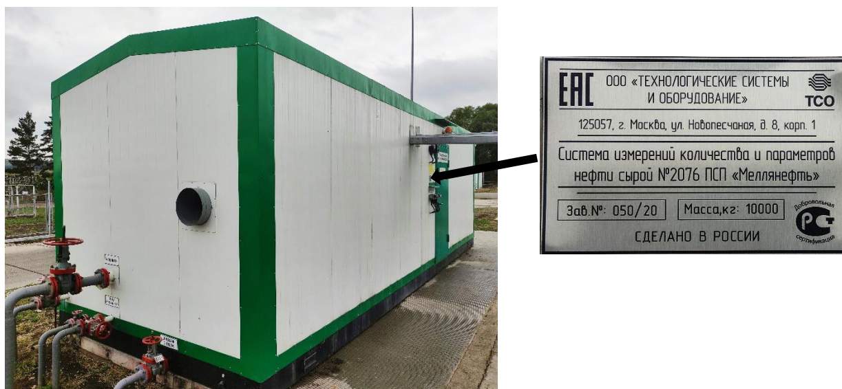
Рисунок - 1 Общий вид СИКНС и место нанесения заводского номера
