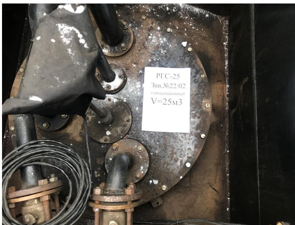
Рисунок 2 – Горловина резервуара РГС-25 зав. № 22/02
