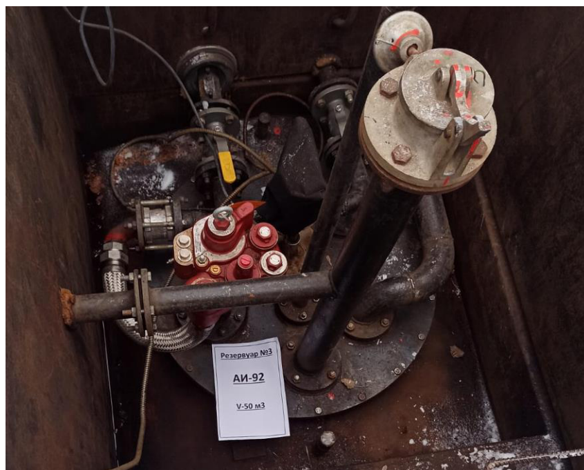
Рисунок 4 – Горловина резервуара РГС-50 зав.№ 3
