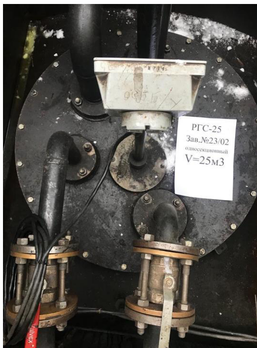
Рисунок 3 – Горловина резервуара РГС-25 зав.№ 23/02
