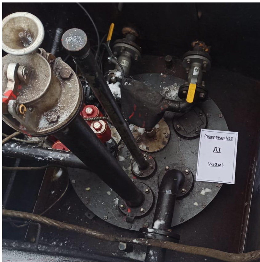
Рисунок 3 – Горловина резервуара РГС-50 зав.№ 2
