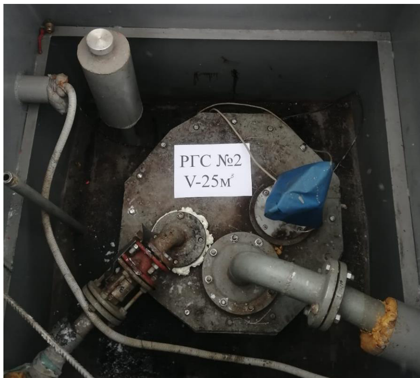
Рисунок 3 – Горловина резервуара РГС-25 зав.№ 2
