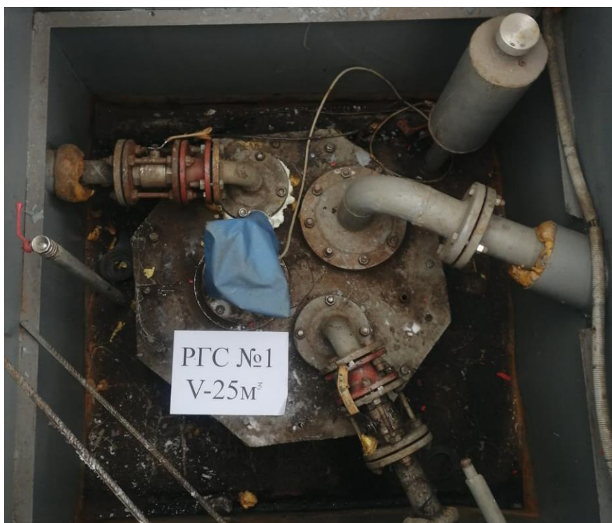
Рисунок 2 – Горловина резервуара РГС-25 зав.№ 1
