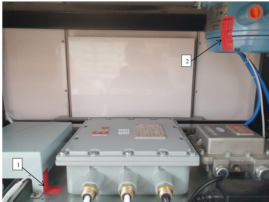
Рисунок 3 – Место пломбирования контроллера (1) и вычислителя (2) расходомера
