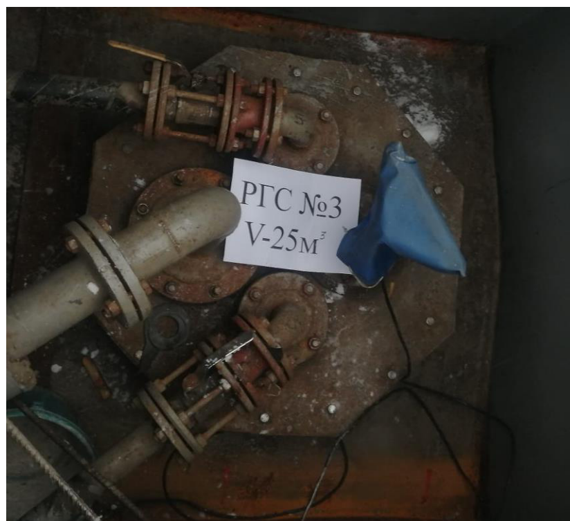
Рисунок 4 – Горловина резервуара РГС-25 зав.№ 3
