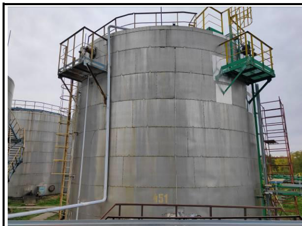
Рисунок 3 – Общий вид резервуара РВС-700 (№451) с замерным люком
