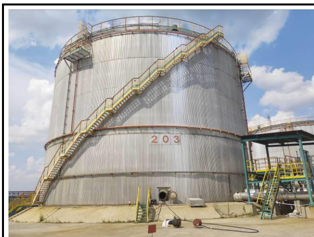
Рисунок 9 – Общий вид резервуара РВС-10000 (№203) с замерным люком
