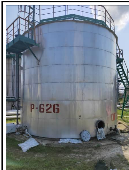
Рисунок 1 – Общий вид резервуара РВС-400 (№626) с замерным люком
