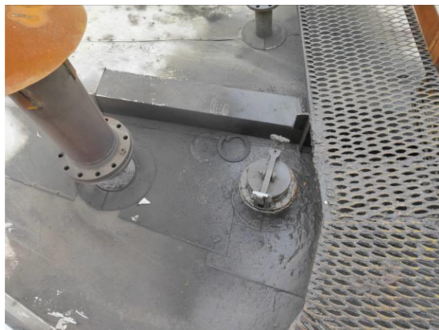
Рисунок 1 – Общий вид резервуара РВС-400 (№626) с замерным люком
