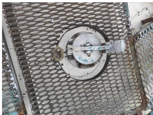
Рисунок 7 – Общий вид резервуара РВС-1000 (№433) с замерным люком
