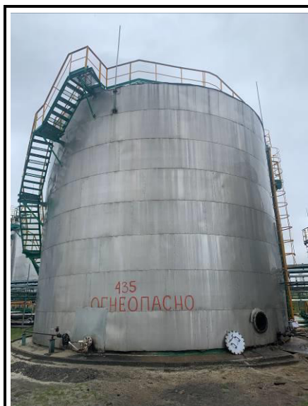
Рисунок 2 – Общий вид резервуара РВС-700 (№435) с замерным люком
