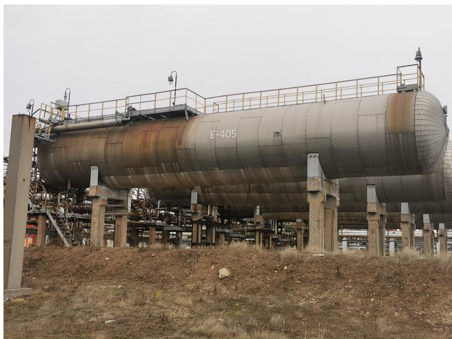
Рисунок 1 – Общий вид резервуара РГС-200
