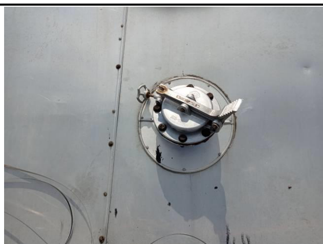
Рисунок 9 – Общий вид резервуара РВС-10000 (№203) с замерным люком
