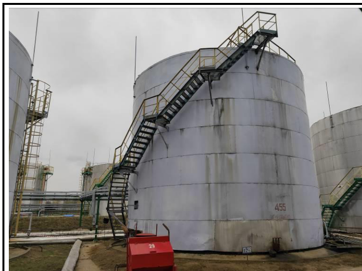
Рисунок 4 – Общий вид резервуара РВС-700 (№455) с замерным люком
