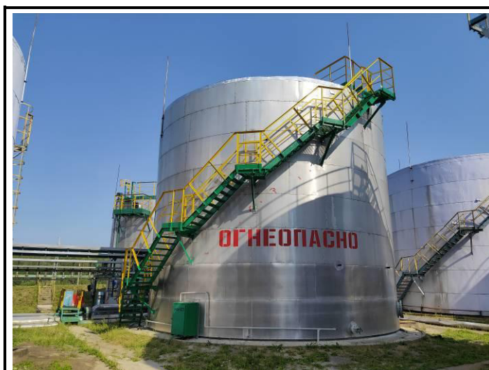
Рисунок 5 – Общий вид резервуара РВС-700 (№529) с замерным люком
