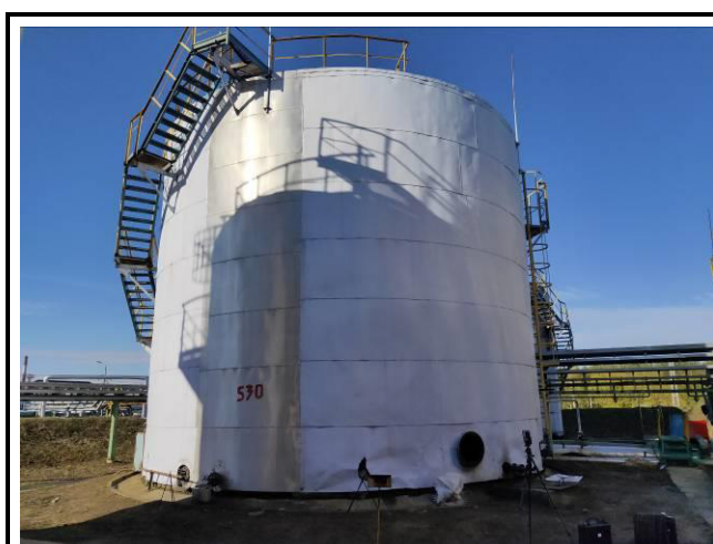
Рисунок 6 – Общий вид резервуара РВС-700 (№530) с замерным люком
