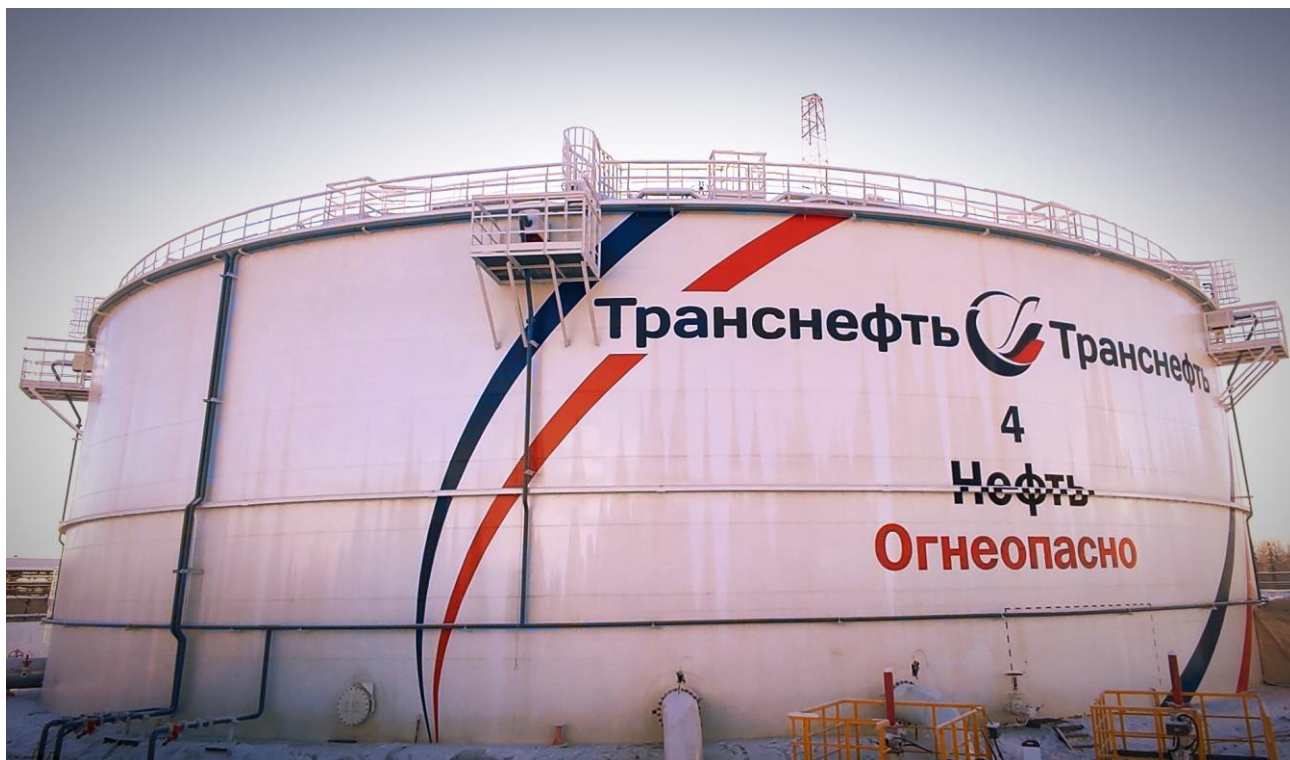
Рисунок 1 – Общий вид резервуара РВСП-20000 зав.№4
