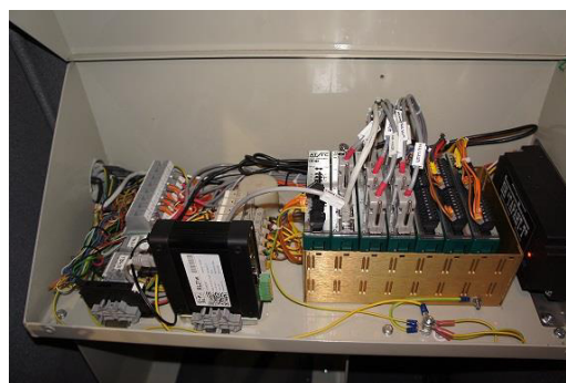
Рисунок 4 – БСК-01 без защитной крышки
