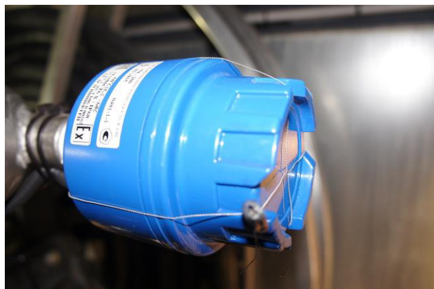
Рисунок 10 – Пломбирование датчика температуры
