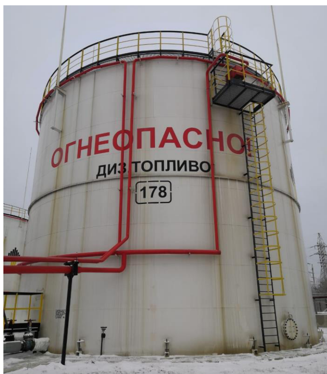
Рисунок 2 – Общий вид резервуара РВС-2000 № 178
