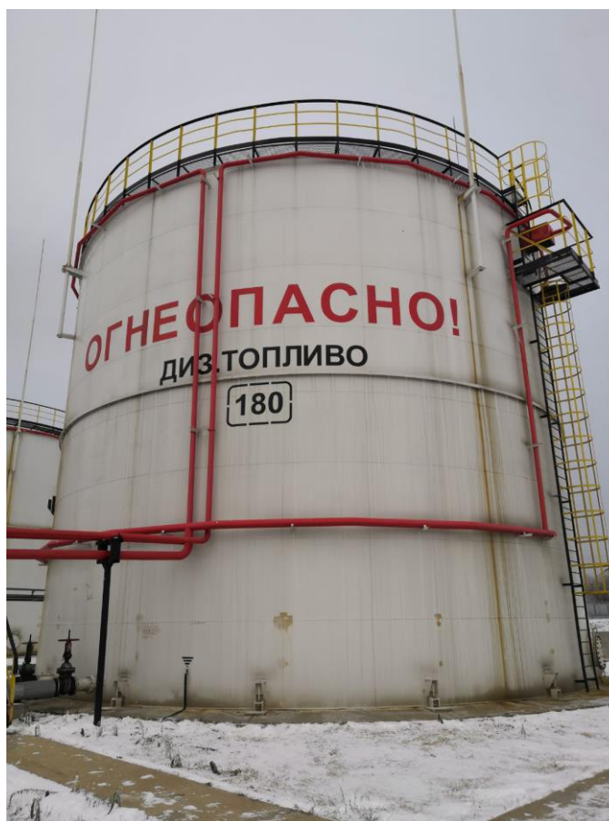
Рисунок 4 – Общий вид резервуара РВС-2000 № 180
