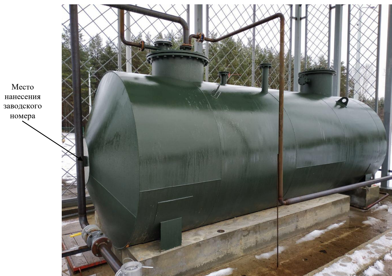
Рисунок 2 - Общий вид резервуара
