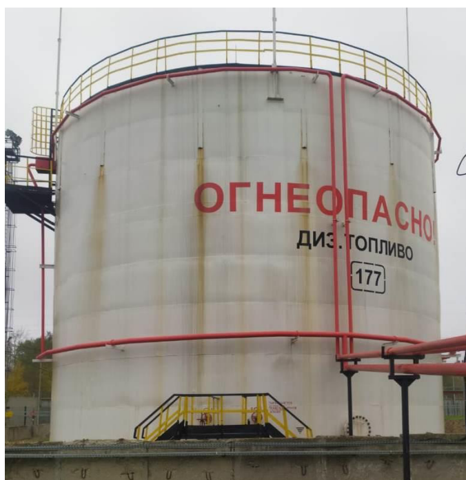
Рисунок 1 – Общий вид резервуара РВС-2000 № 177
