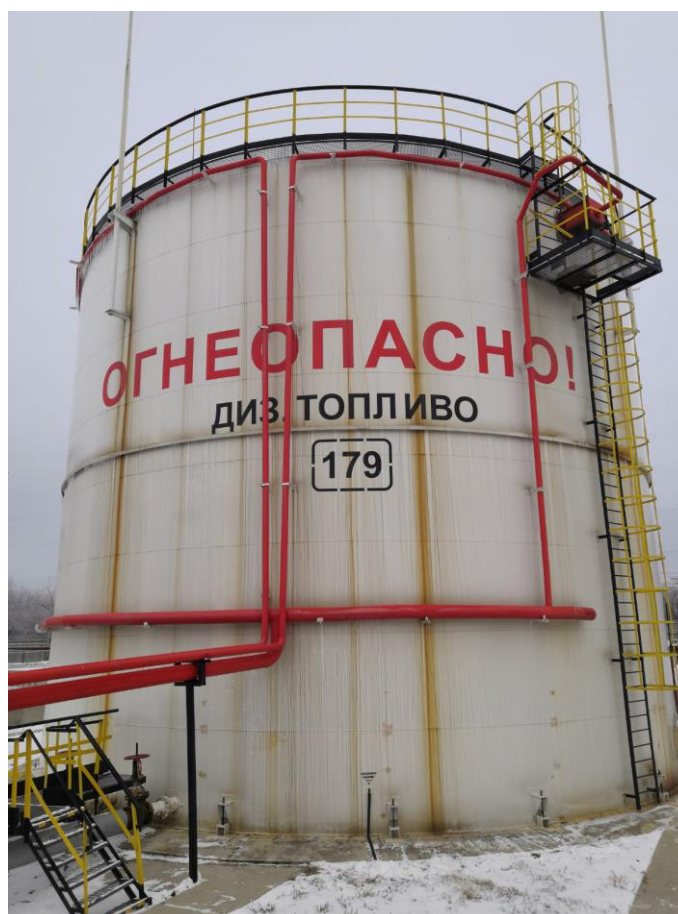
Рисунок 3 – Общий вид резервуара РВС-2000 № 179
