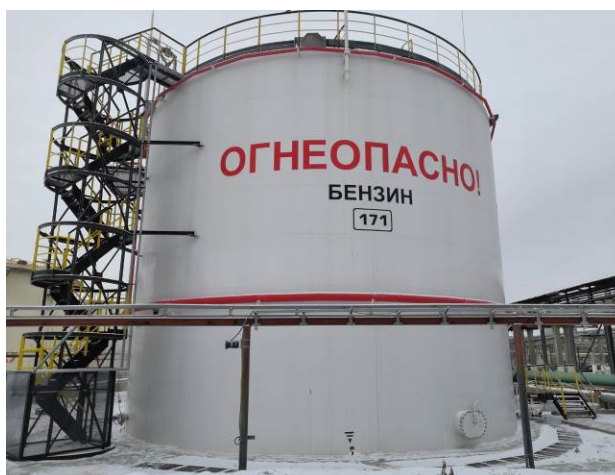
Рисунок 5 – Общий вид резервуаров РВСП-2000 № 171
