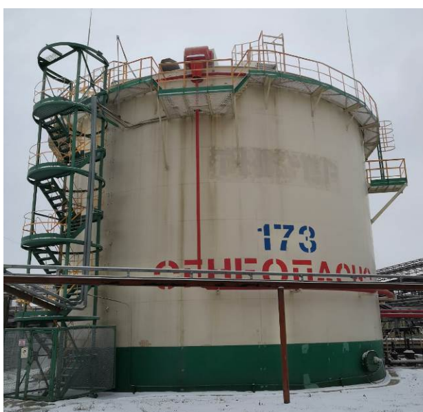
Рисунок 7 – Общий вид резервуаров РВСП-2000 № 173
