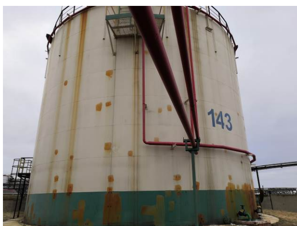
Рисунок 4 – Общий вид резервуаров РВСП-2000 № 143
