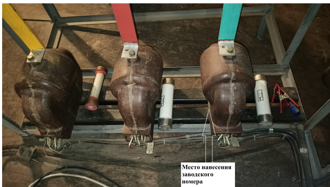
Рисунок 1 – Общий вид трансформаторов напряжения с указанием мест нанесения заводского номера
