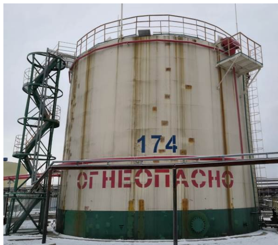
Рисунок 8 – Общий вид резервуаров РВСП-2000 № 174
