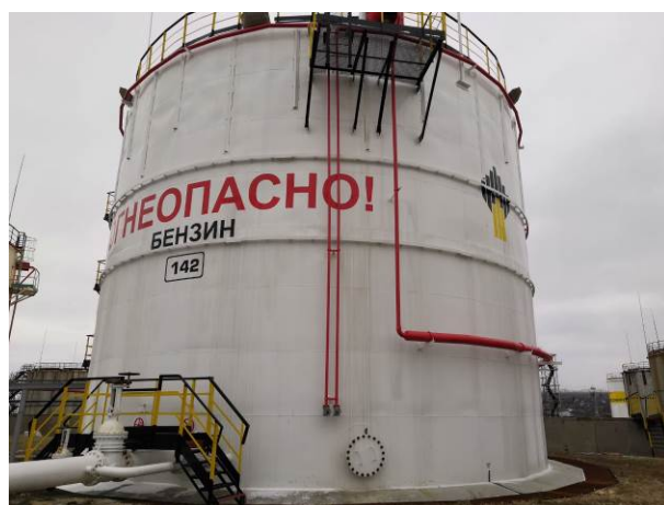
Рисунок 3 – Общий вид резервуаров РВСП-2000 № 142
