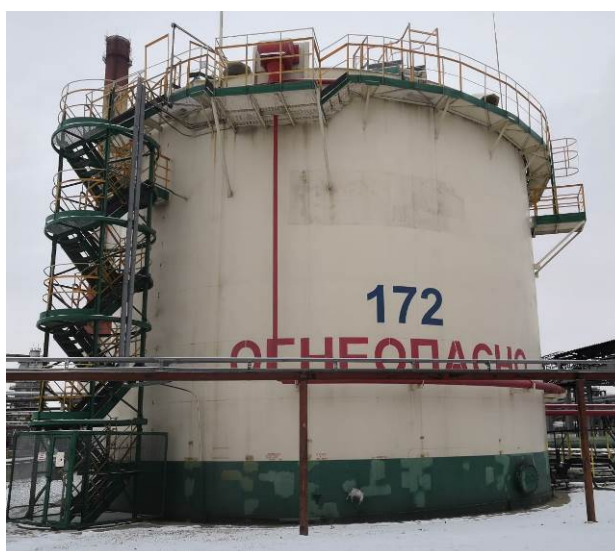
Рисунок 6 – Общий вид резервуаров РВСП-2000 № 172
