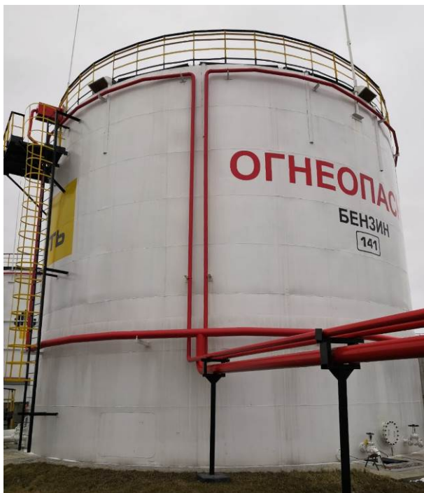
Рисунок 2 – Общий вид резервуаров РВСП-2000 № 141
