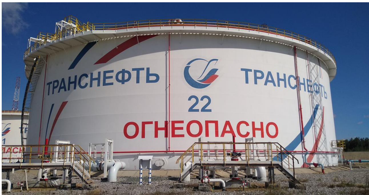
Рисунок 1 – Общий вид резервуара РВСПК-50000 №22
