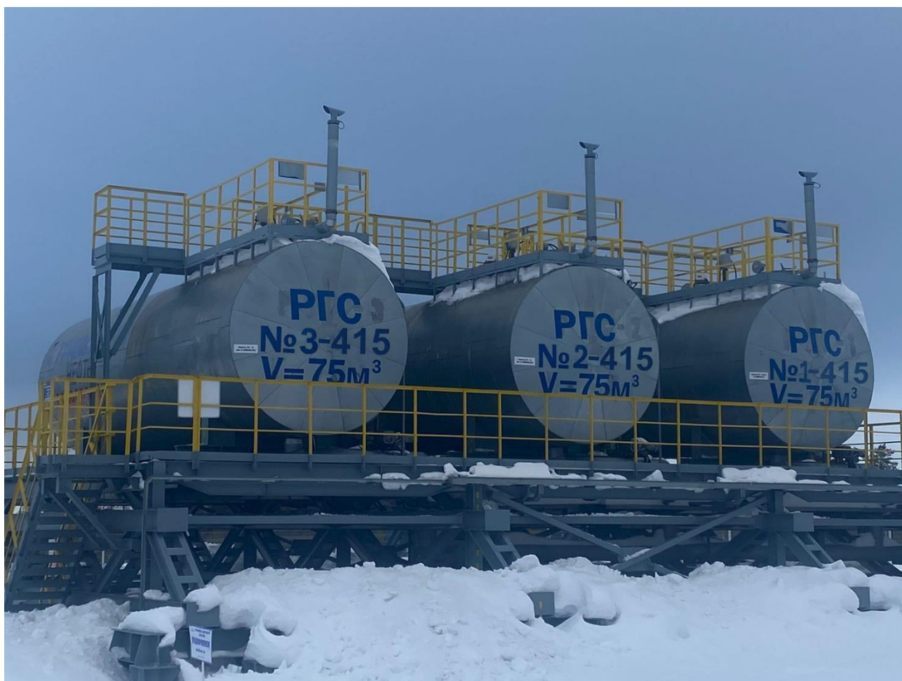
Рисунок 1 – Общий вид резервуаров РГС-75
