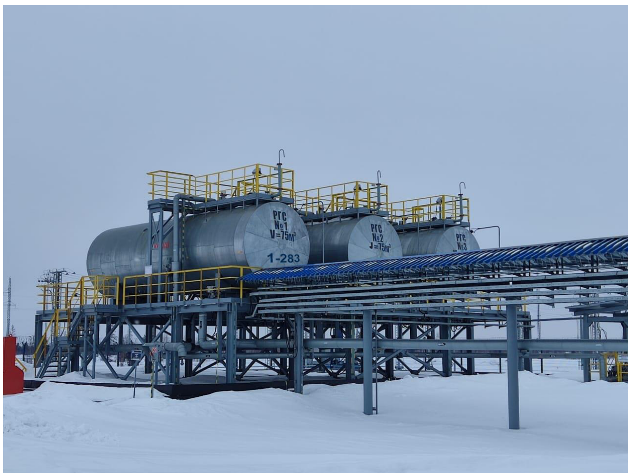
Рисунок 1 – Общий вид резервуаров РГС-75
