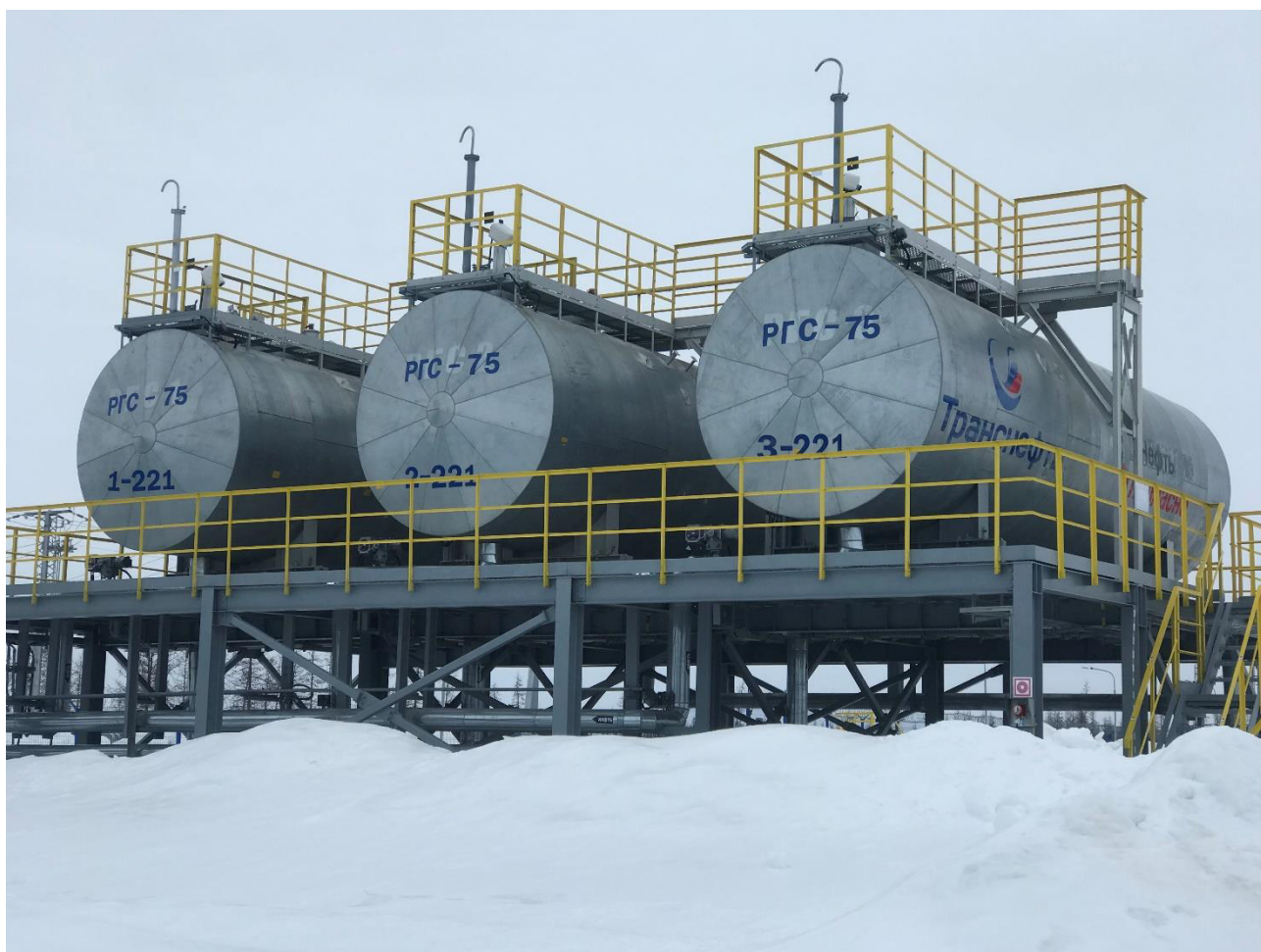
Рисунок 1 – Общий вид резервуаров РГС-75
