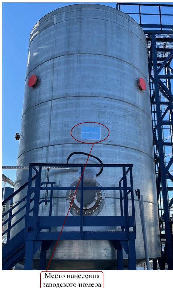
Рисунок 3 – Общий вид резервуара РВС-60 №18 с указанием места нанесения заводского номера
