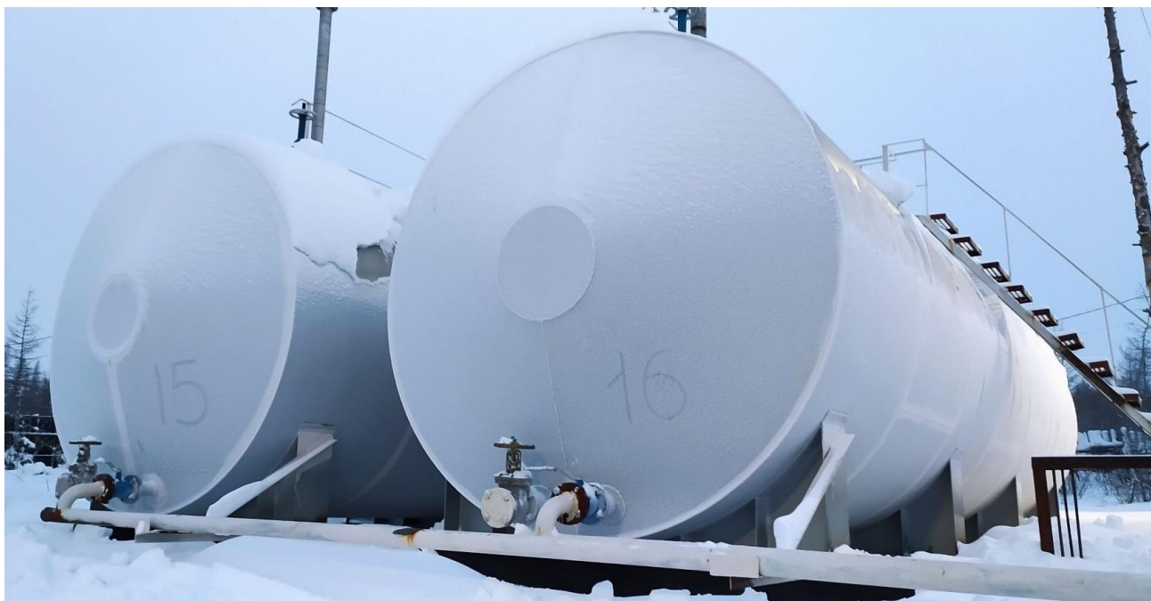
Рисунок 2 – Общий вид резервуаров РГС-60
