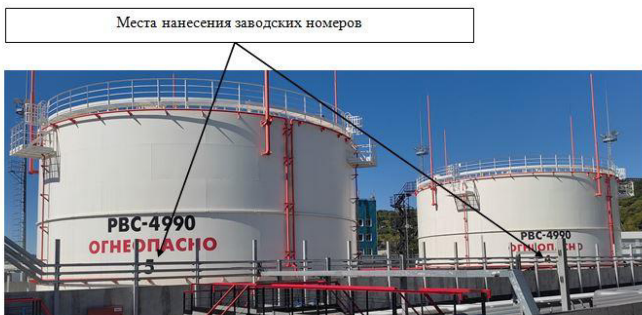
Рисунок 1 - Общий вид резервуаров PBC-4990 с указанием мест нанесения заводских номеров
