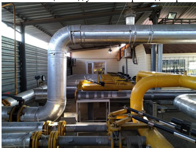
Рисунок 1 – Комплект эталонных критических сопел и запорно-регулирующей арматуры
