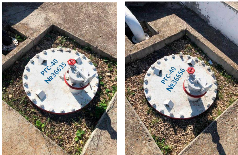
Рисунок 1 – Общий вид крышек резервуаров РГС-40
