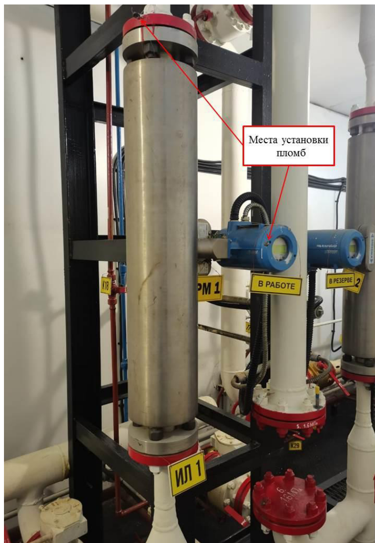
Рисунок 1 – Места установки пломб на РМ от несанкционированного доступа
