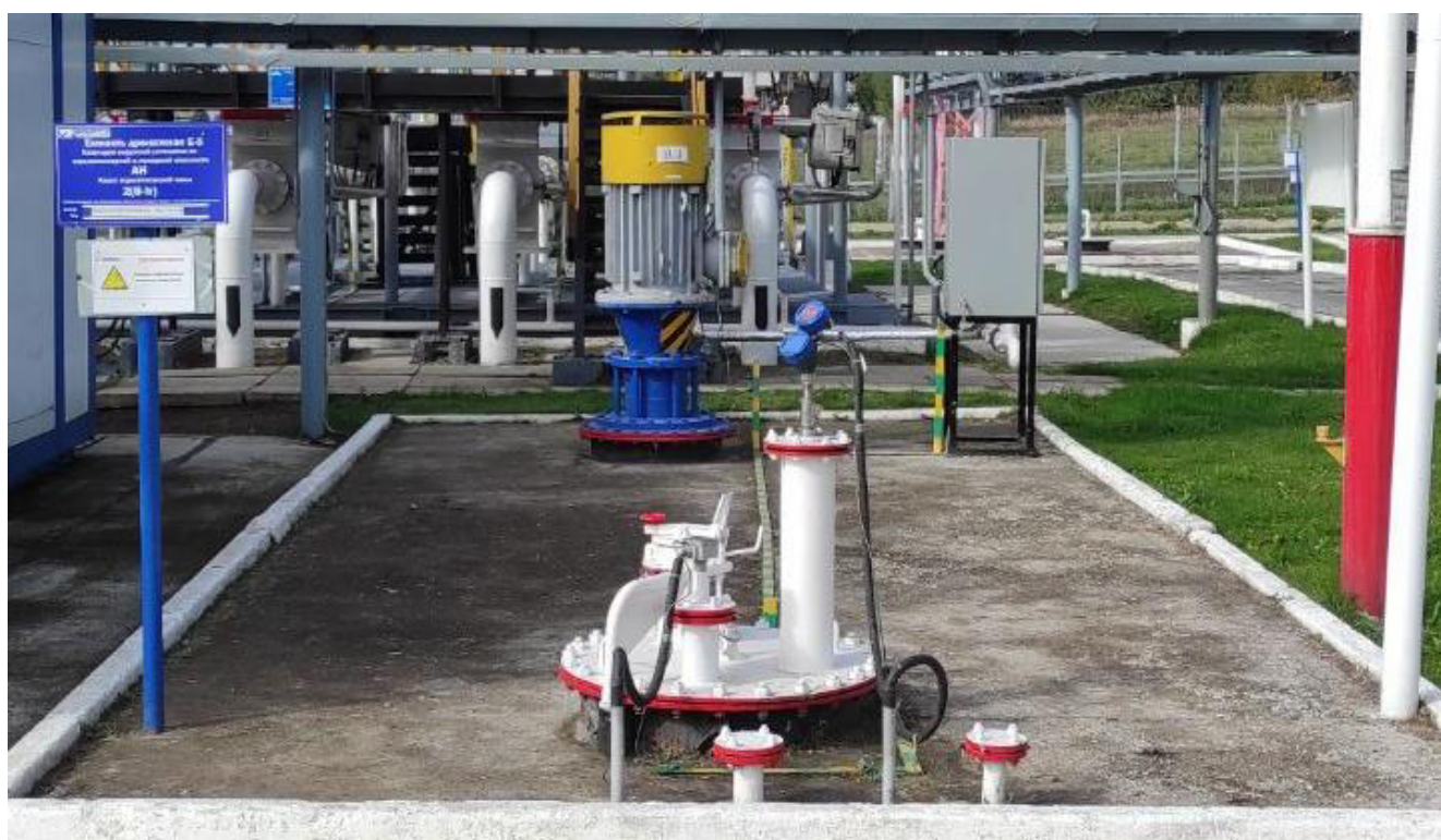
Рисунок 2 – Общий вид резервуара ЕП40-2400-1-2К
