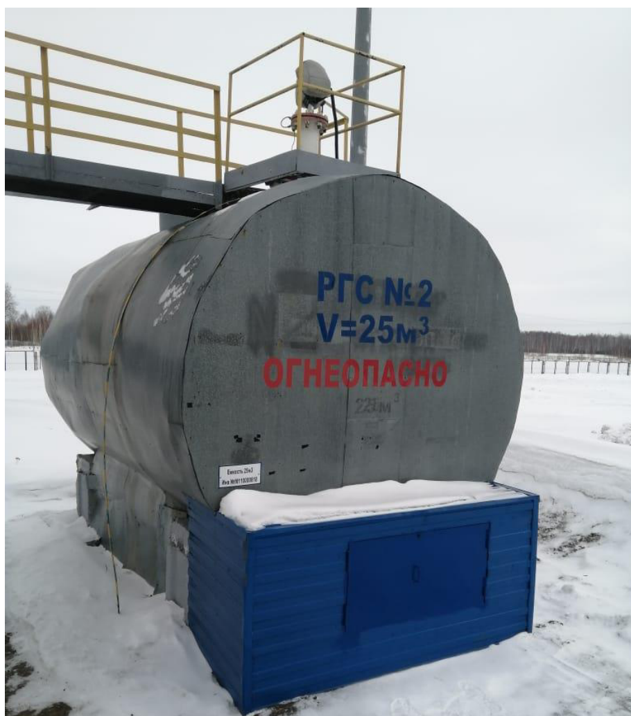
Рисунок 2 – Общий вид резервуара РГС-25
