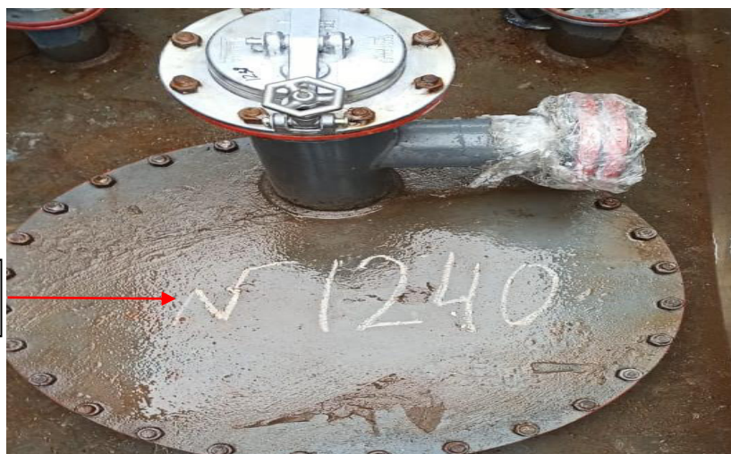
Рисунок 5 – Фотография горловины и заводского номера резервуара стального горизонтального цилиндрического РГС, модификации РГС-200 с зав. № 1240
