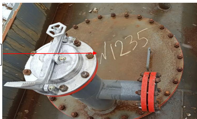
Рисунок 1 – Фотографии горловин и заводский номеров резервуаров стальных горизонтальных цилиндрических РГС, модификации РГС-25 с зав. №№ 1233, 1234, 1235
