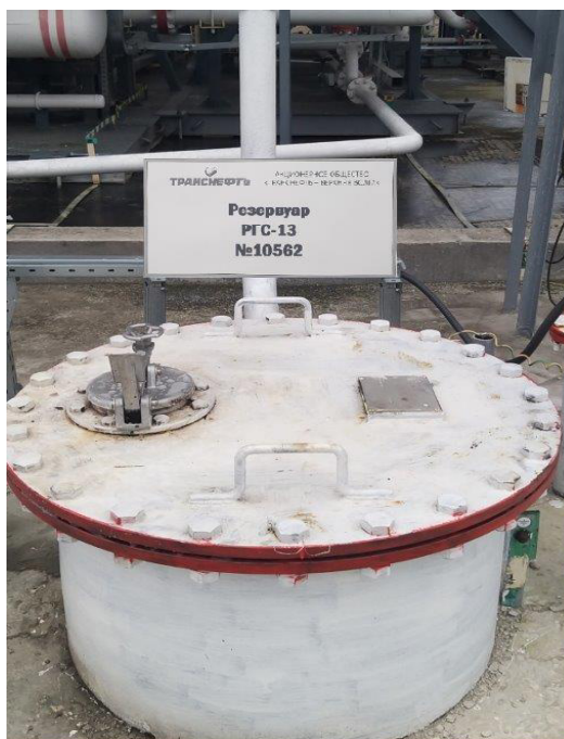
Рисунок 1 – Общий вид резервуара РГС-13
