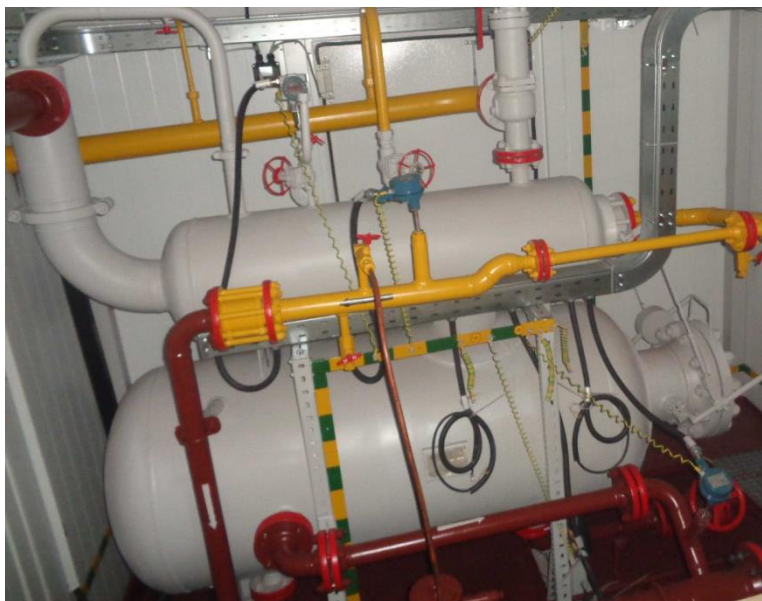
Рисунок 2 – Установка измерительная «МЕРА-ММ.ХХХ». Общий вид. Блок технологический.
