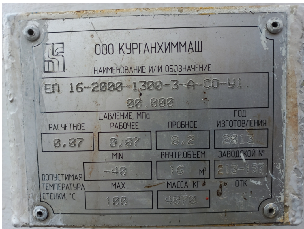
Рисунок 1 – Маркировочная табличка резервуара
