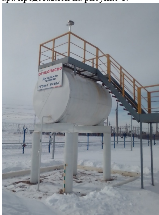
Рисунок 1 – Общий вид резервуара РГС-10
