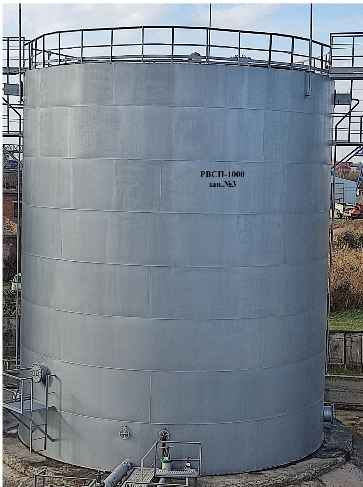
Рисунок 2 - Фотография общего вида резервуара РВСП-1000 заводской номер 3
