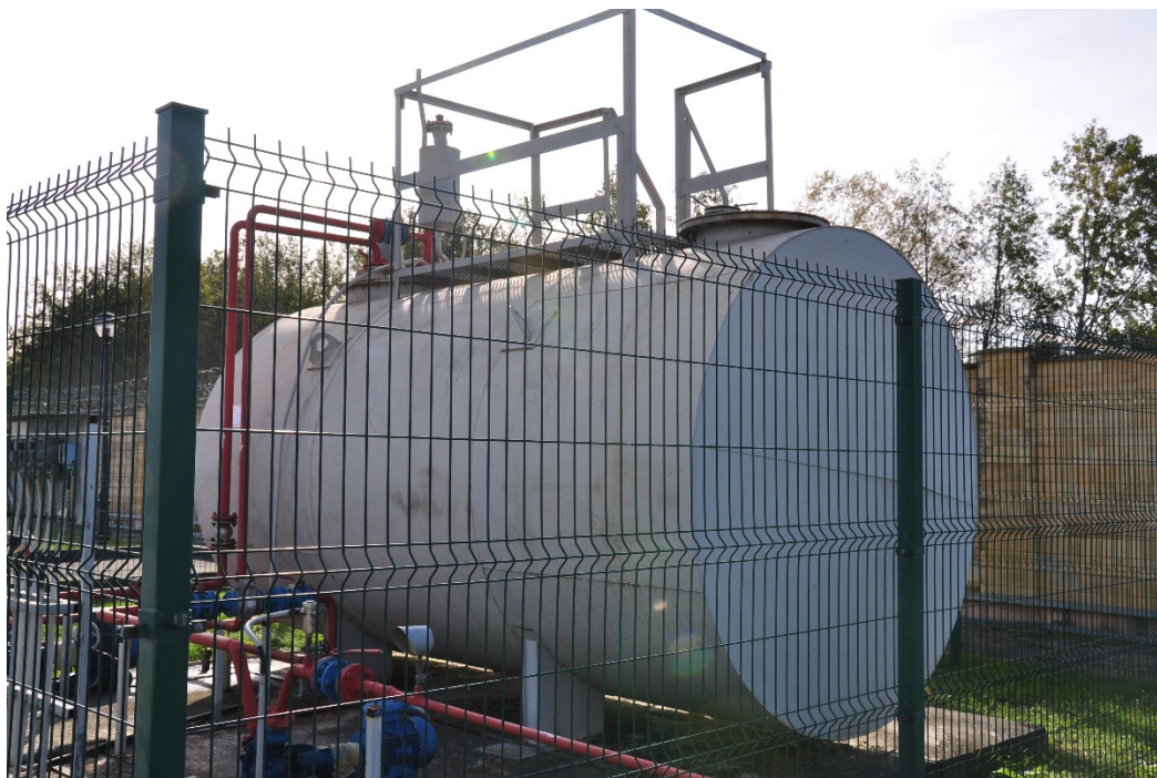
Рисунок 1 - Фотография общего вида резервуара РГС-20Г заводской номер 32
