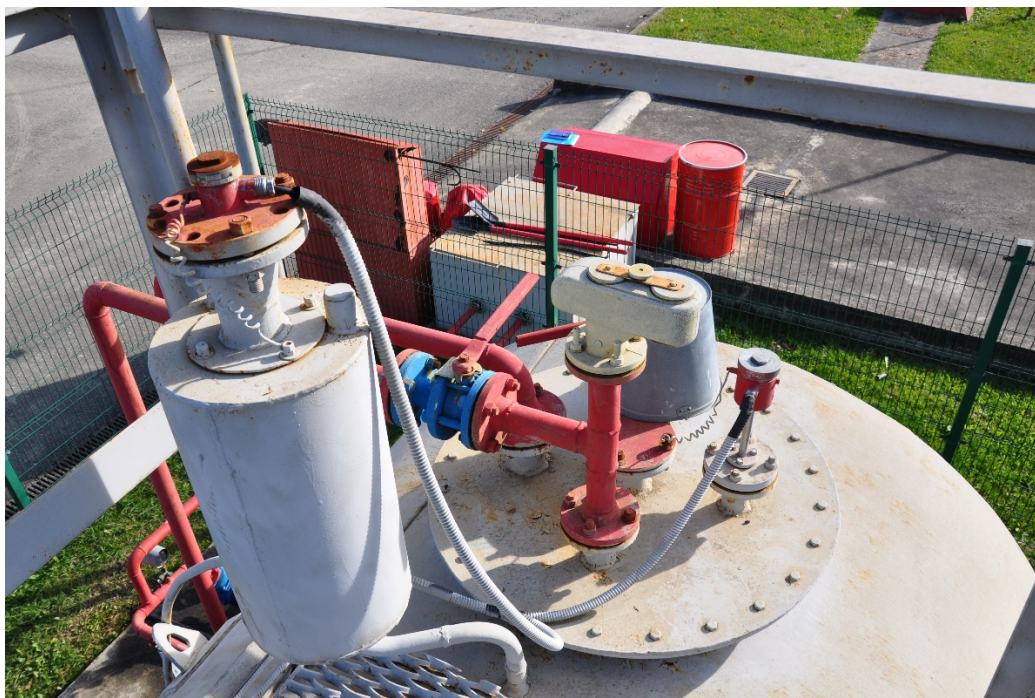
Рисунок 2 - Фотография замерного люка резервуара РГС-20Г заводской номер 32
