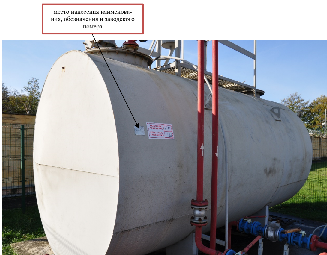
Рисунок 3 – Фотография резервуара РГС-20Г заводской номер 32 с указанием места нанесения наименования, обозначения и заводского номера
