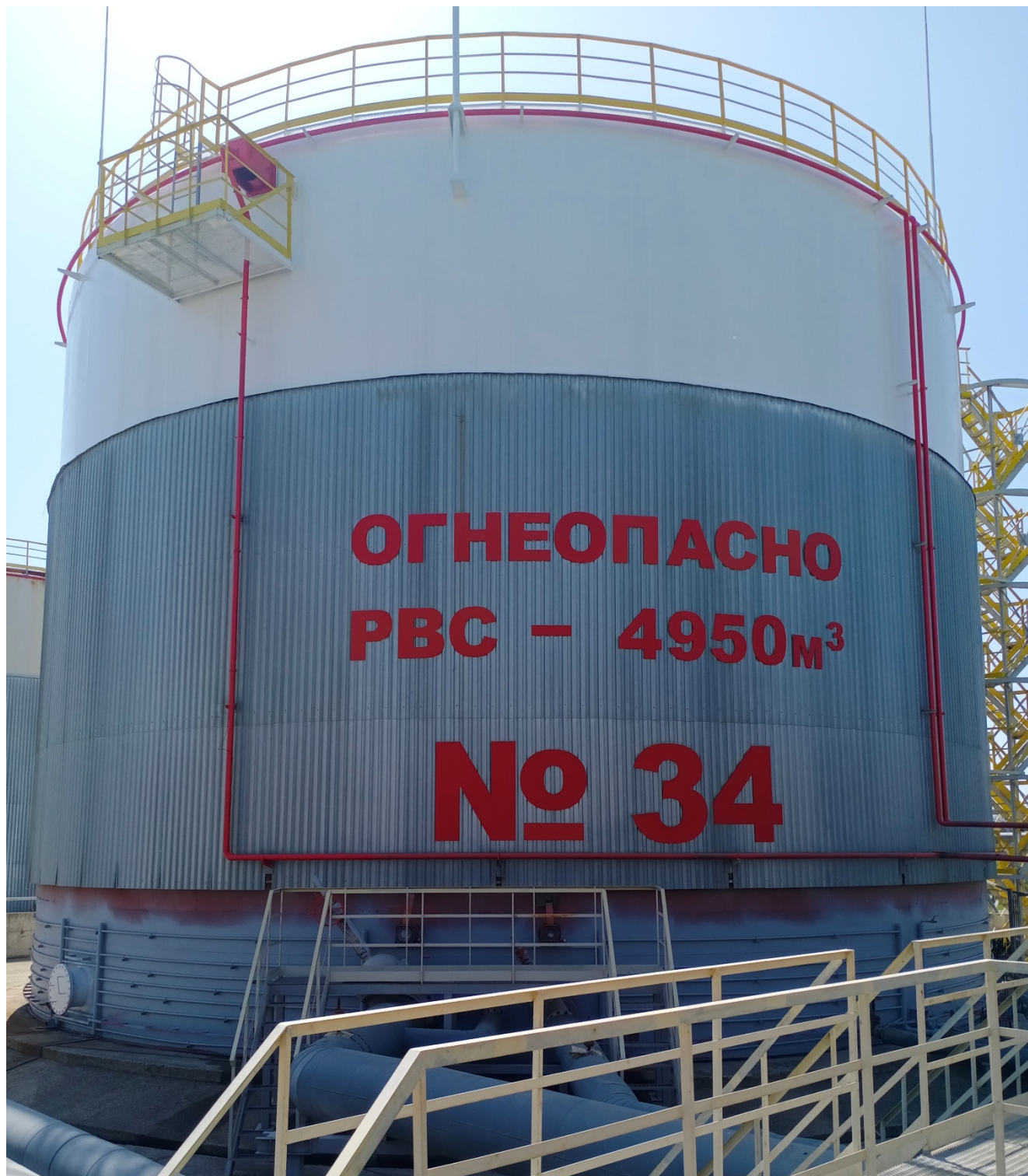
Рисунок 1 - Фотография общего вида резервуара РВС-4950 заводской номер 34
