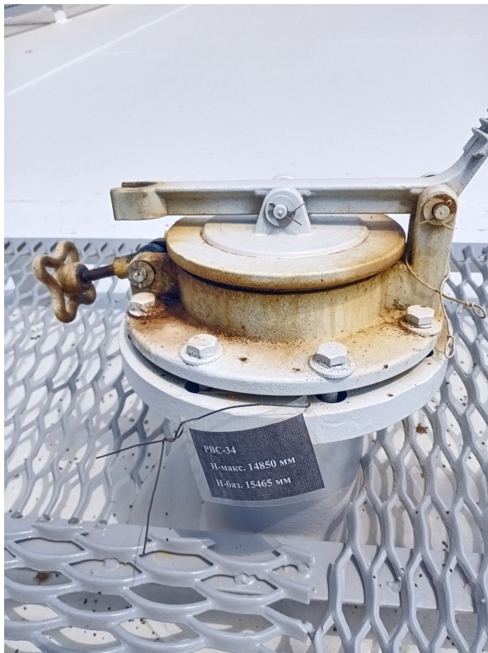
Рисунок 2 - Фотография крышки замерного люка резервуара РВС-4950 заводской номер 34
