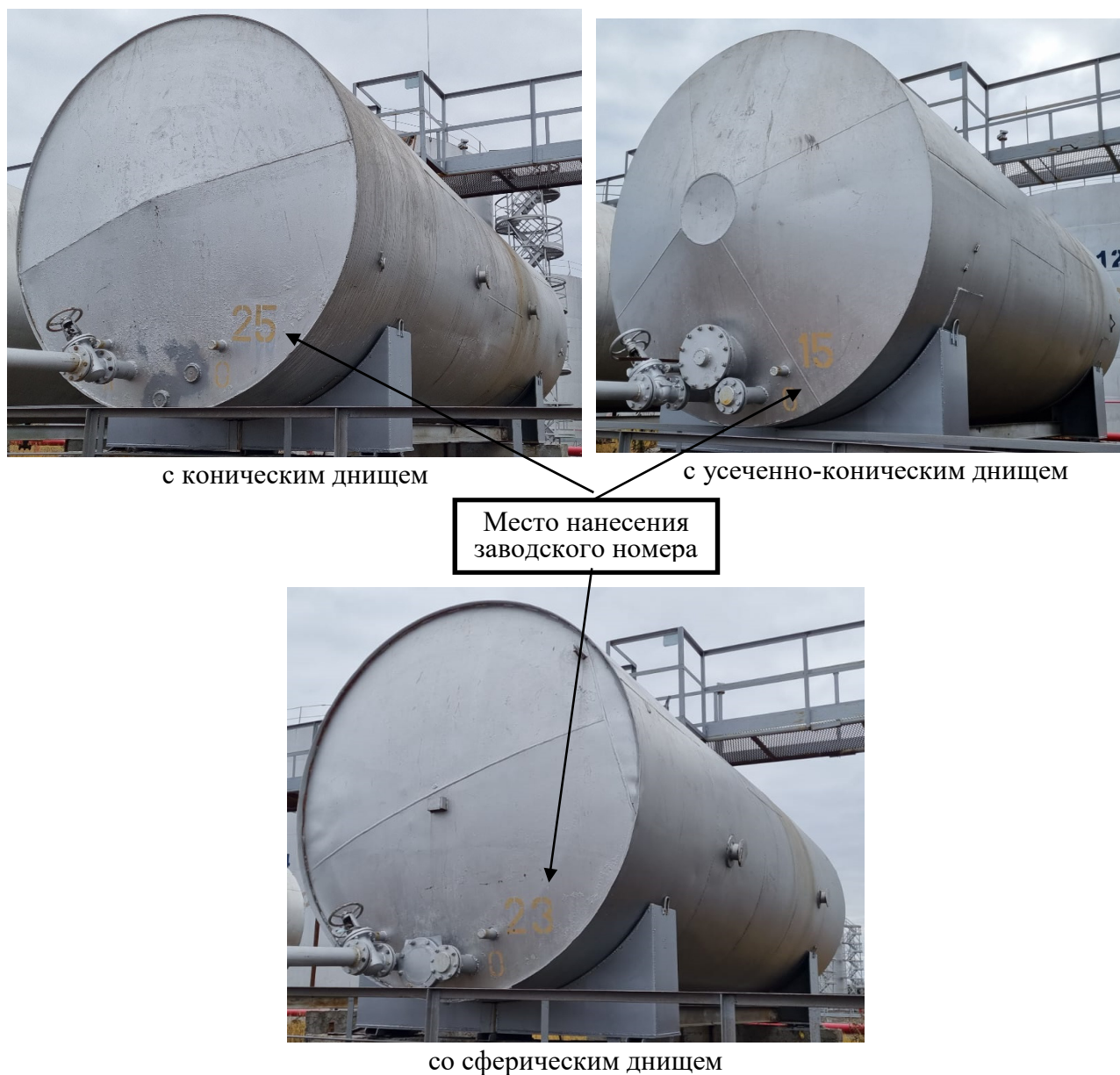
Рисунок 1 – Общий вид резервуаров
