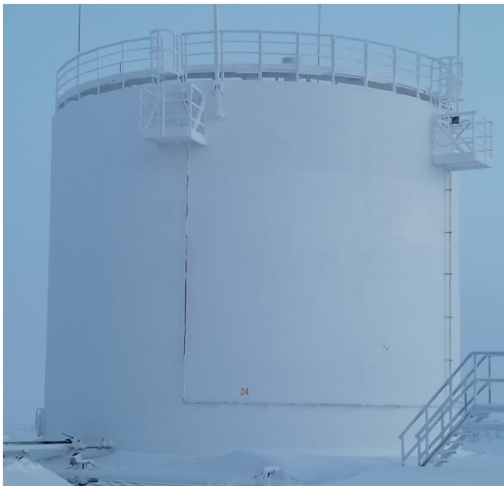
Рисунок 1 – Общий вид резервуара РВС-2000
