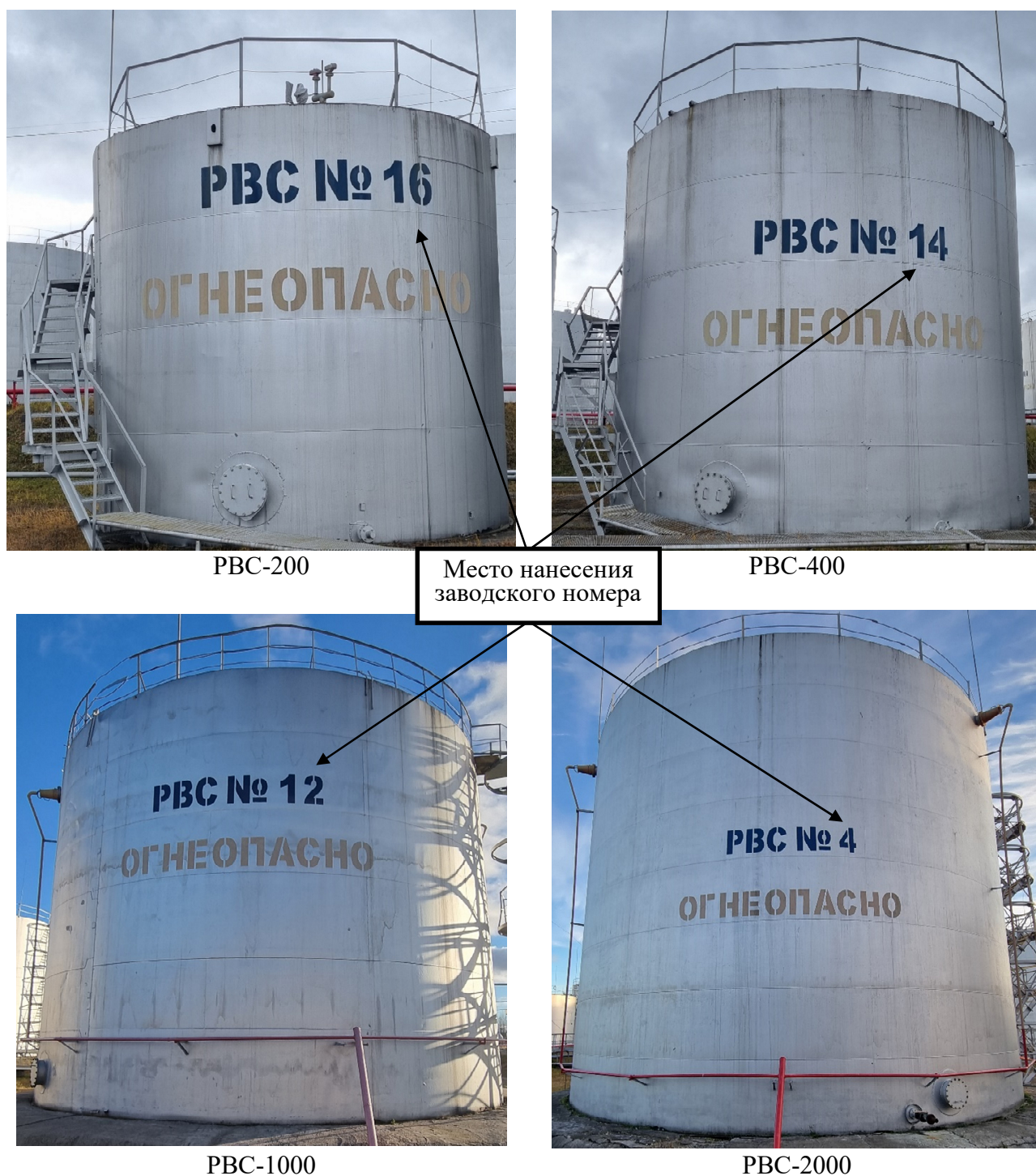
Рисунок 1 – Общий вид резервуаров
