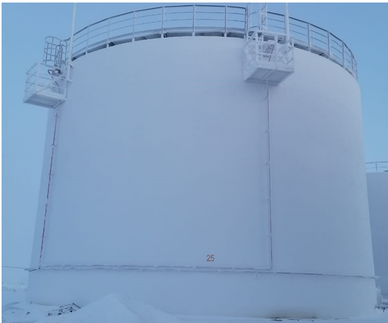
Рисунок 1 – Общий вид резервуара РВС-3000
