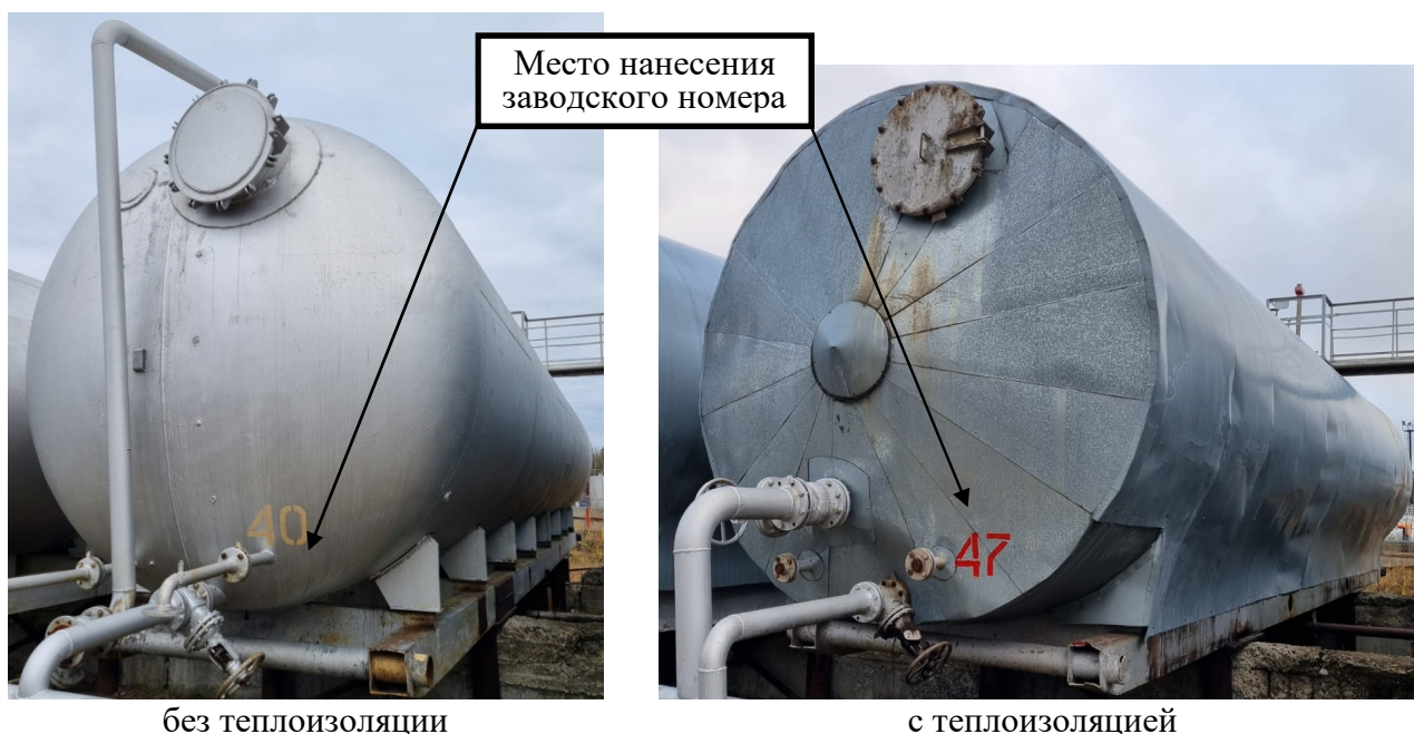
Рисунок 1 – Общий вид резервуаров
