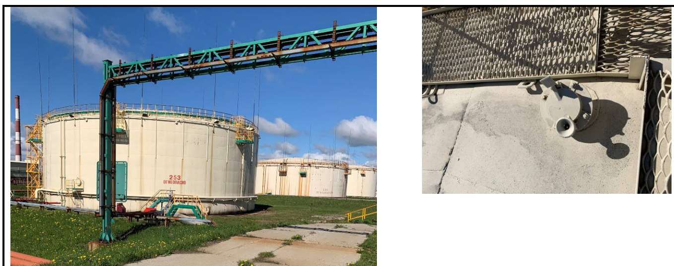
Рисунок 17 – Общий вид резервуара РВСП-10000 (№253) с замерным люком
