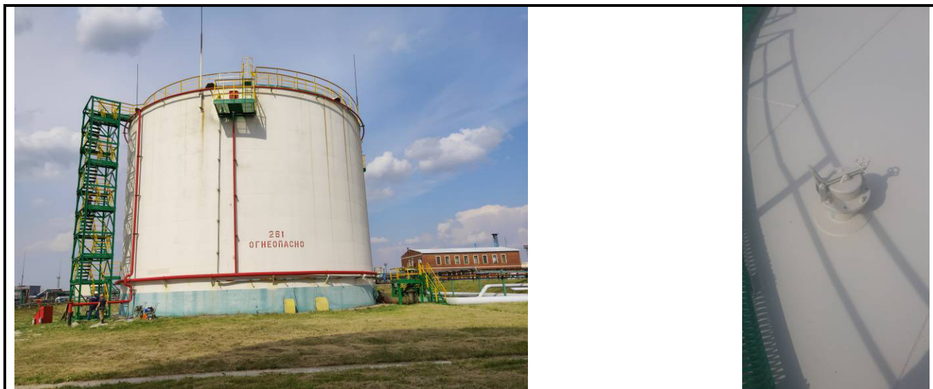
Рисунок 13 – Общий вид резервуара РВСП-5000 (№261) с замерным люком
