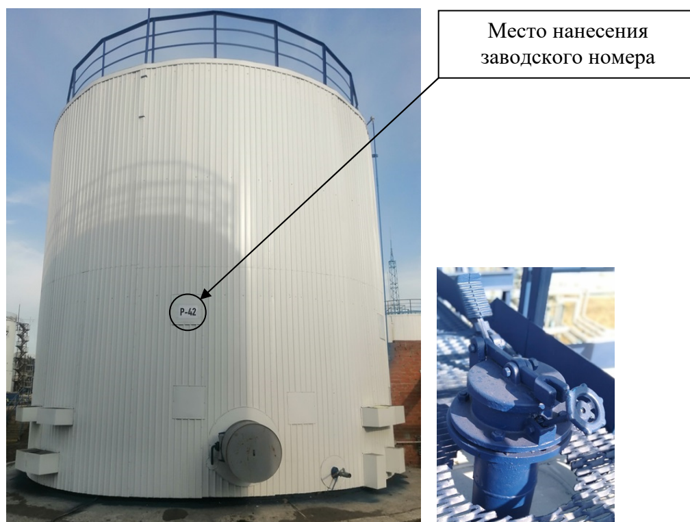
Р и с у н о к 6 – Общий вид резервуара с заводским номером Р-42 и его замерного люка
