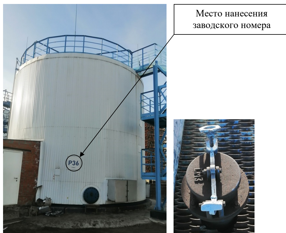
Р и с у н о к 2 – Общий вид резервуара с заводским номером P36 и его замерного люка
