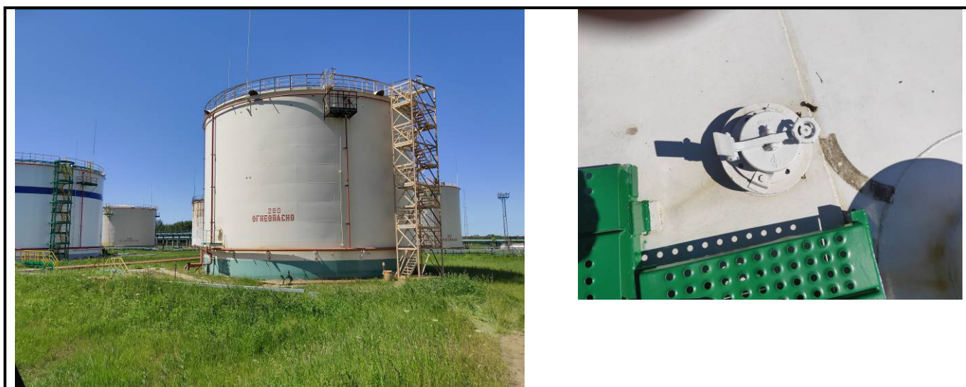
Рисунок 12 – Общий вид резервуара РВСП-5000 (№260) с замерным люком
