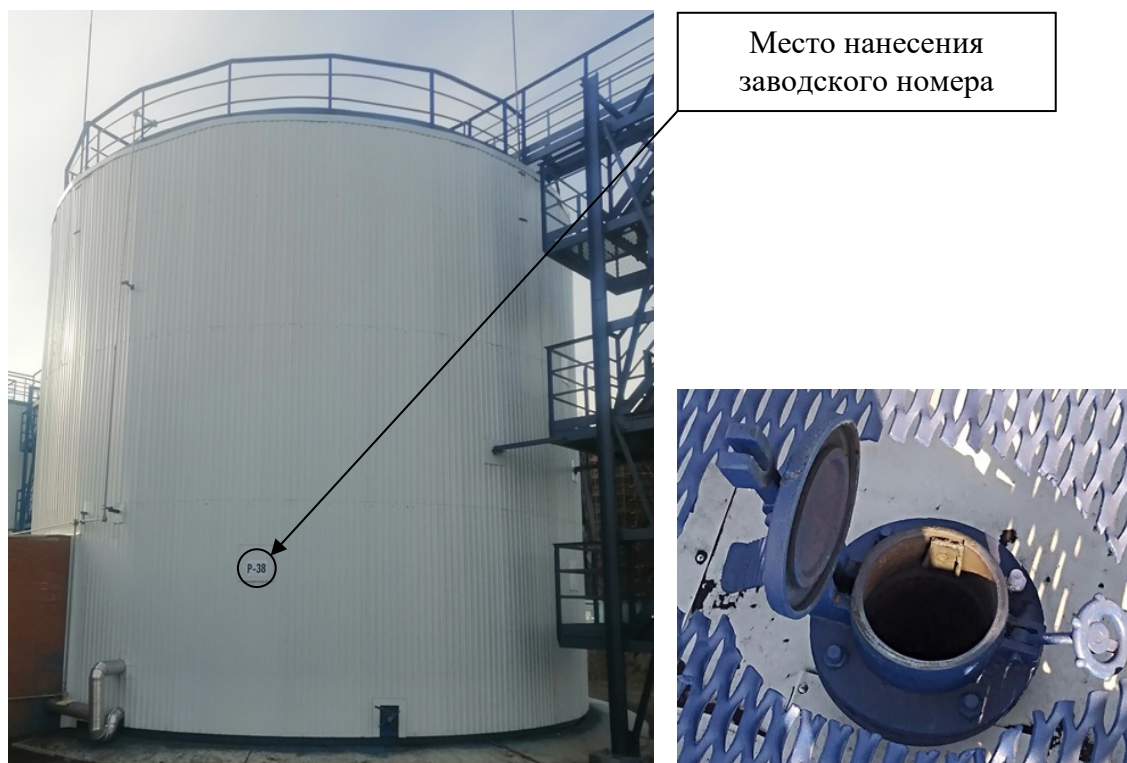
Р и с у н о к 1 – Общий вид резервуара с заводским номером Р-38 и его замерного люка
