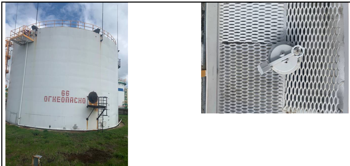
Рисунок 10 – Общий вид резервуара РВСП-3000 (№66) с замерным люком
