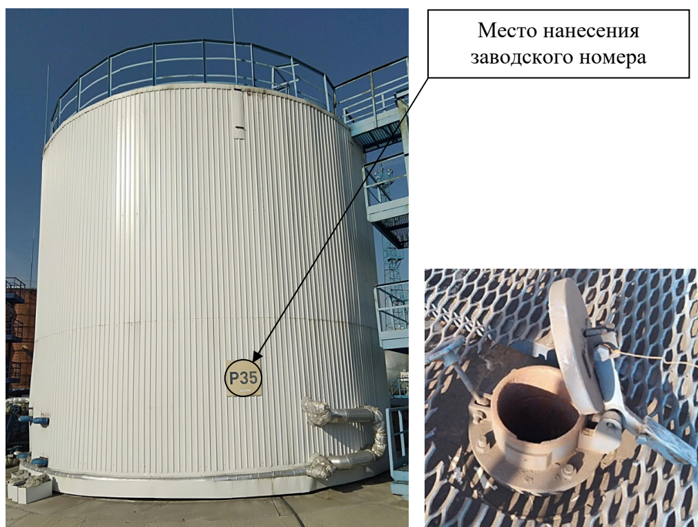
Р и с у н о к 1 – Общий вид резервуара с заводским номером P35 и его замерного люка
