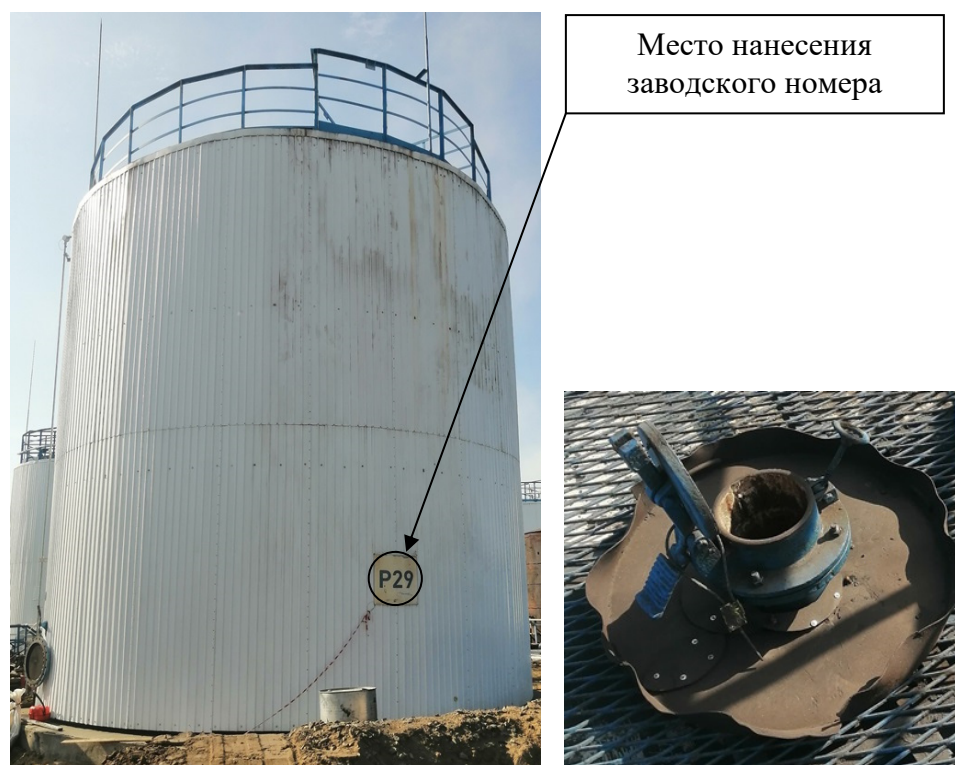
Р и с у н о к 5 – Общий вид резервуара с заводским номером Р29 и его замерного люка
