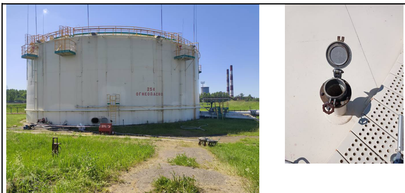
Рисунок 18 – Общий вид резервуара РВСП-10000 (№254) с замерным люком
