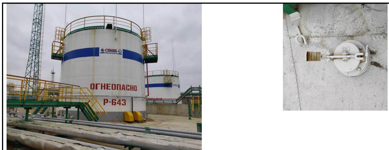
Рисунок 6 – Общий вид резервуара РВСП-700 (№Р-643) с замерным люком
