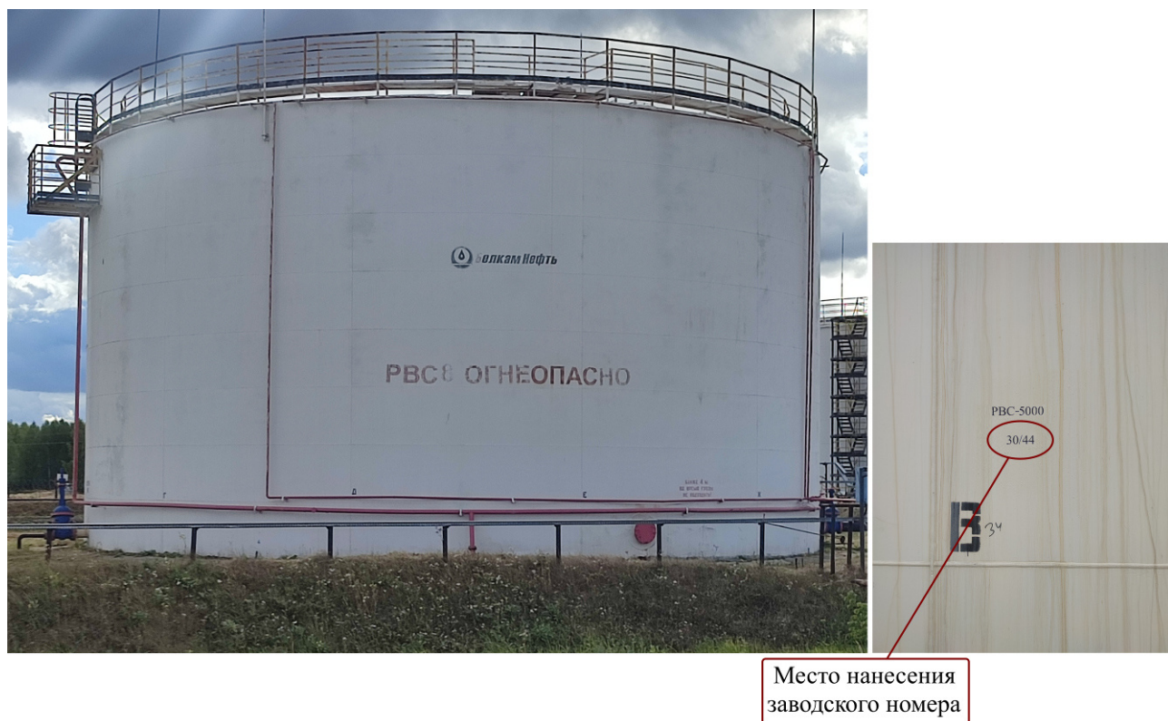
Рисунок 5 – Общий вид резервуара PVC-5000 №30/44 с указанием места нанесения заводского номера
