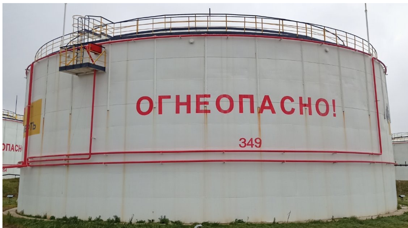
Рисунок 1 – Общий вид резервуара РВС-10000 №349
