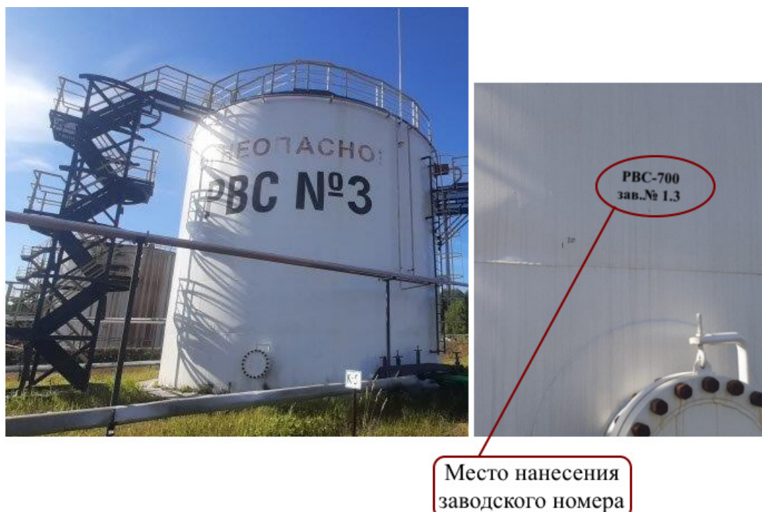
Рисунок 1 – Общий вид резервуара PBC-700 с указанием места нанесения заводского номера
