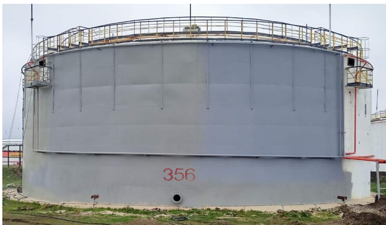
Рисунок 4 – Общий вид резервуара РВС-10000 №356
