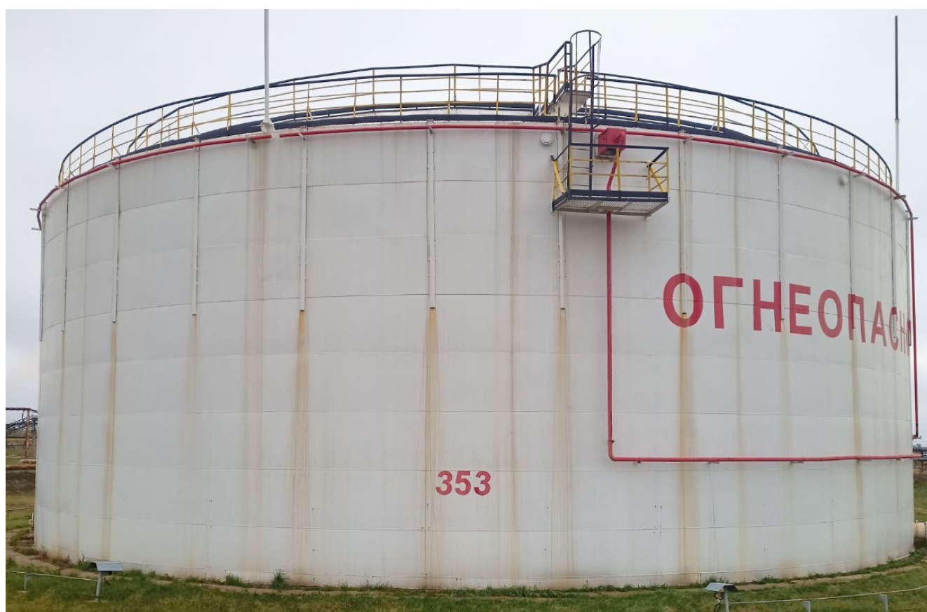
Рисунок 2 – Общий вид резервуара РВС-10000 №353
