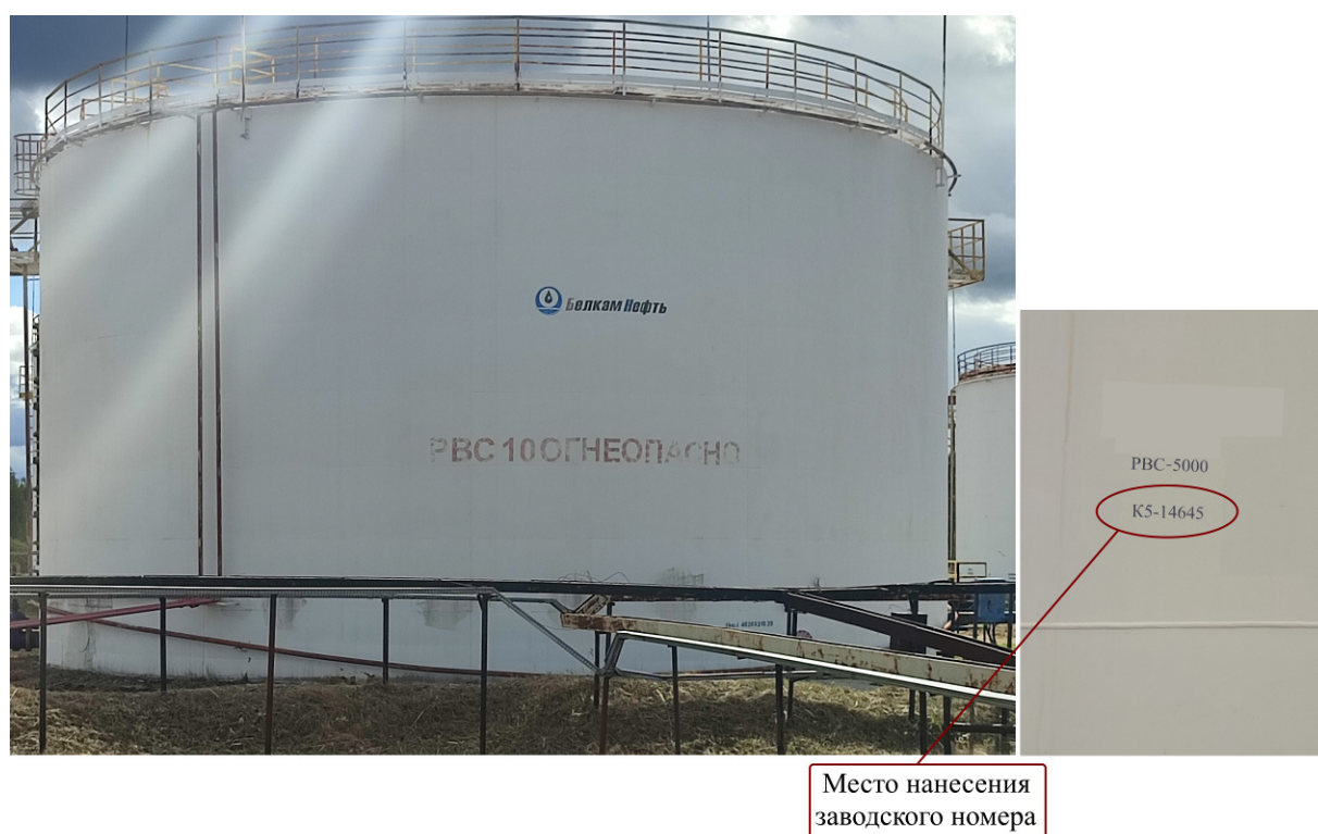
Рисунок 6 – Общий вид резервуара PVC-5000 № K5-14645 с указанием места нанесения заводского номера
