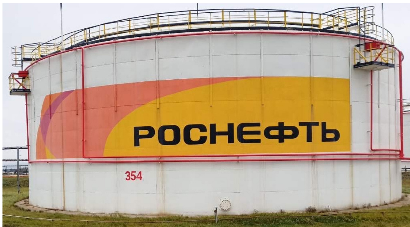
Рисунок 3 – Общий вид резервуара РВС-10000 №354
