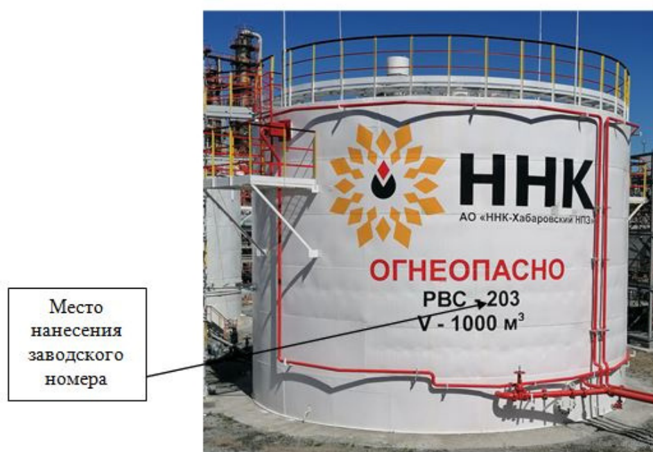
Рисунок 1 - Общий вид резервуаров модификаций PBC-1000 (с 6 поясами) с указанием места нанесения заводского номера
