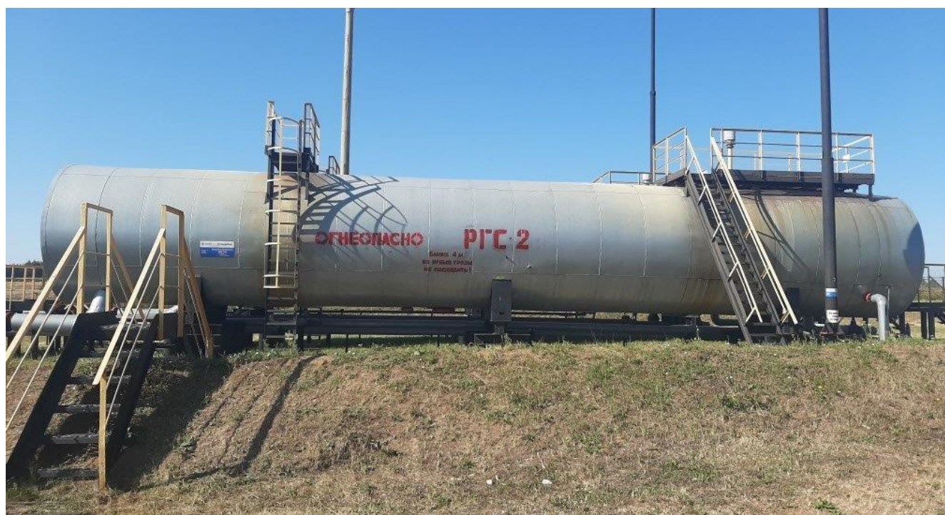
Рисунок 2 – Общий вид резервуара РГС-200 №37687
