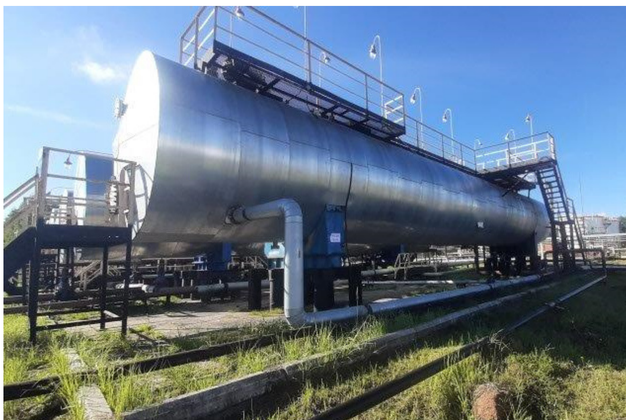
Рисунок 2 – Общий вид резервуара РГС-200
