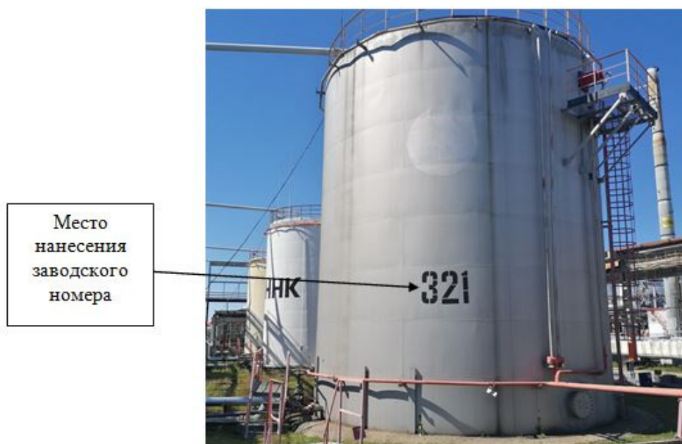
Рисунок 2 - Общий вид резервуаров модификаций PBC-1000 (с 8 поясами) с указанием места нанесения заводского номера
