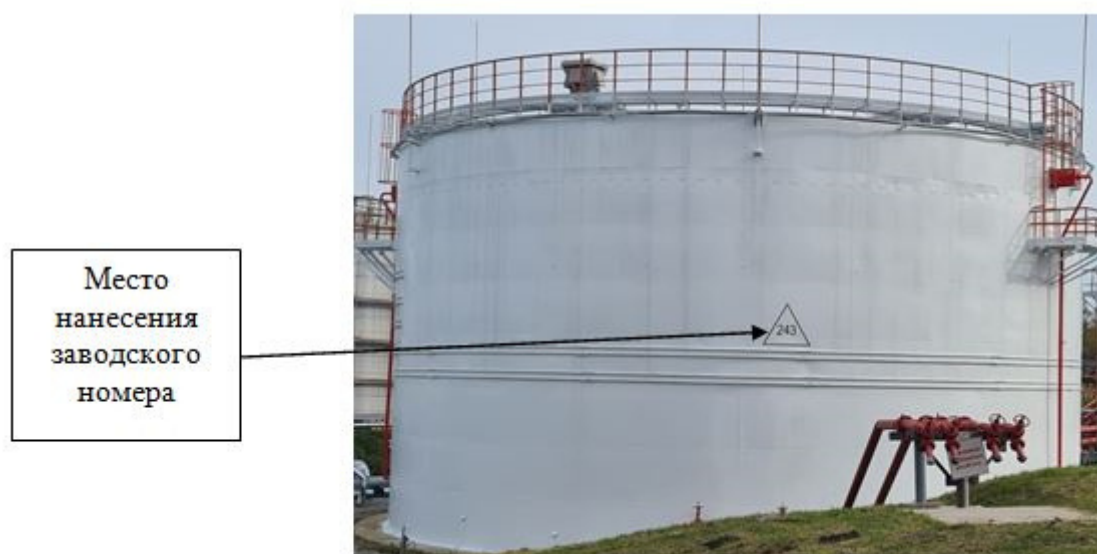
Рисунок 3 – Общий вид резервуаров модификаций РВС-5000 с указанием места нанесения заводского номера
