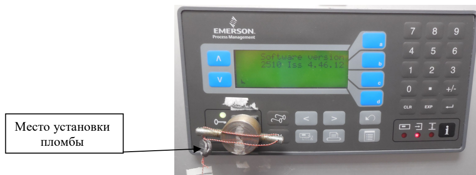
Рисунок 2 – Схема пломбировки от несанкционированного доступа, обозначение места нанесения знака поверки ИВК СИКН
