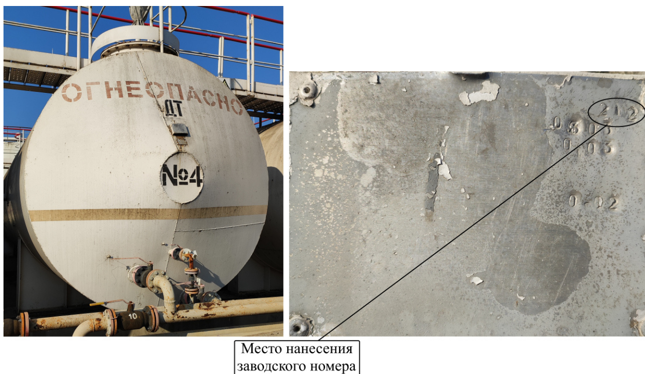
Рисунок 2 – Общий вид резервуара РГС-75 №212 с указанием места нанесения заводского номера
