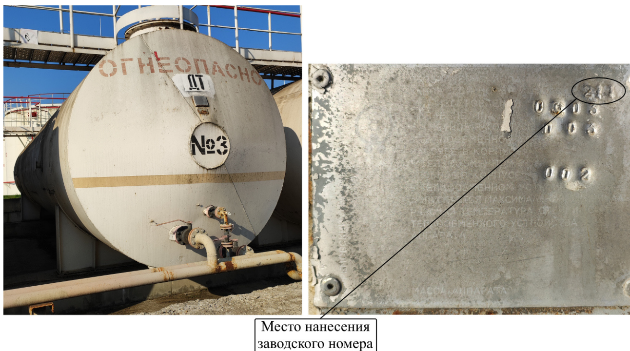
Рисунок 1 – Общий вид резервуара РГС-75 №211 с указанием места нанесения заводского номера
