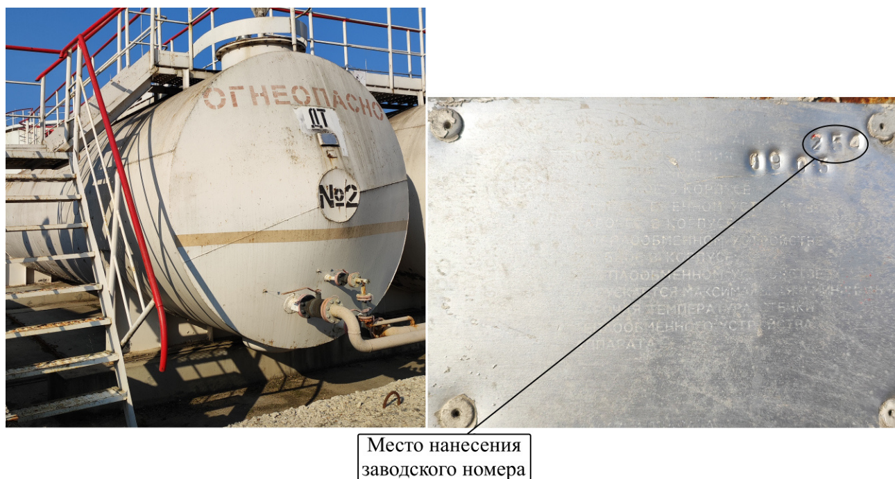
Рисунок 5 – Общий вид резервуара РГС-75 №254 с указанием места нанесения заводского номера
