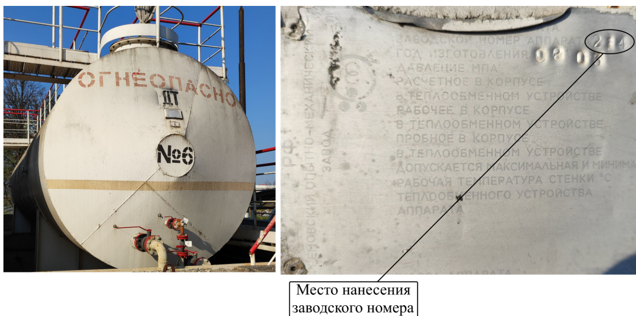
Рисунок 4 – Общий вид резервуара РГС-75 №214 с указанием места нанесения заводского номера
