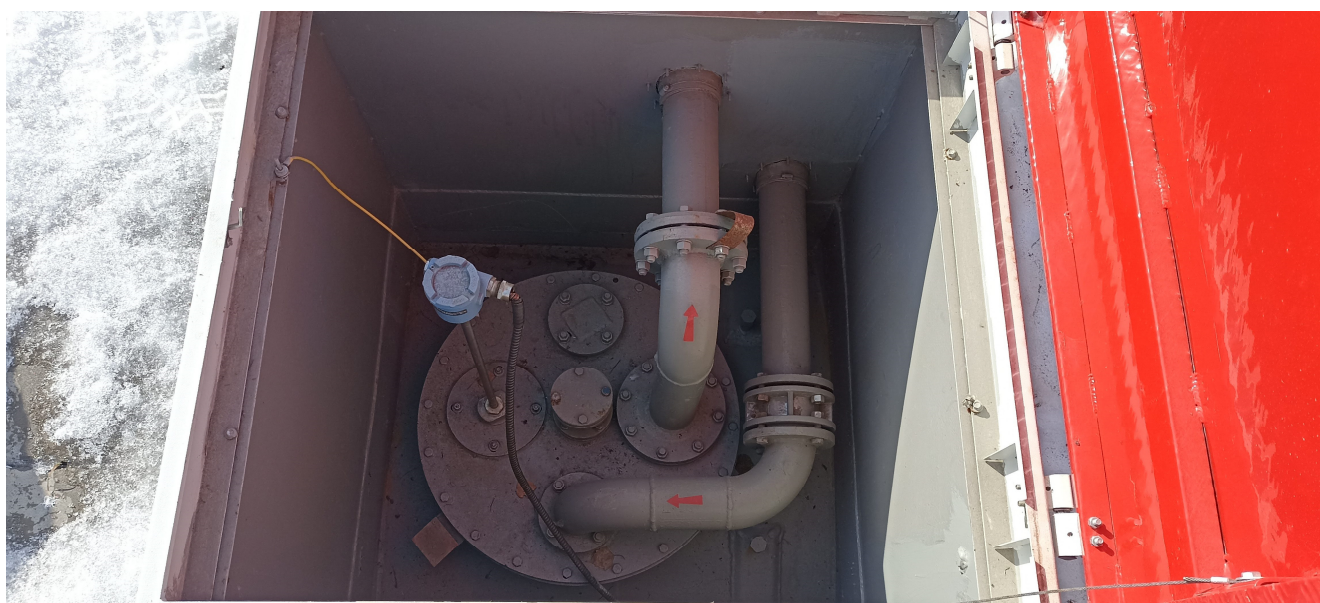
Рисунок 2 – Общий вид резервуара РГ-50
