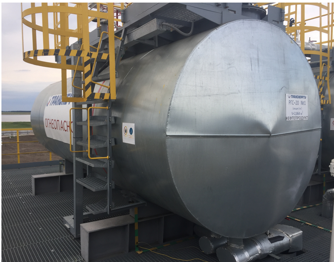
Рисунок 2 – Общий вид резервуара РГС-20 зав.№ 378
