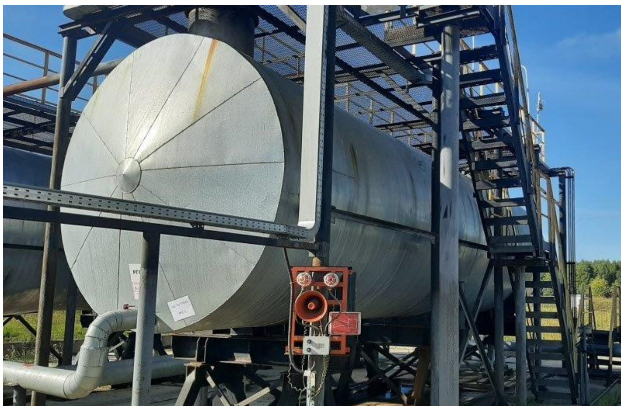
Рисунок 2 – Общий вид резервуара РГС-100 зав.№19843
