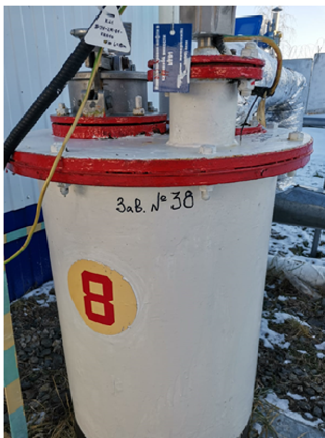
Рисунок 1 – Горловина и измерительный люк
