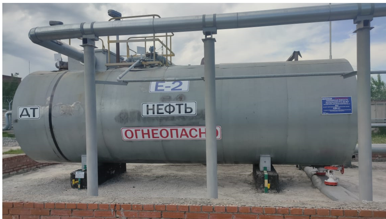
Рисунок 2 – Общий вид резервуара РГС-20 зав.№ 54
