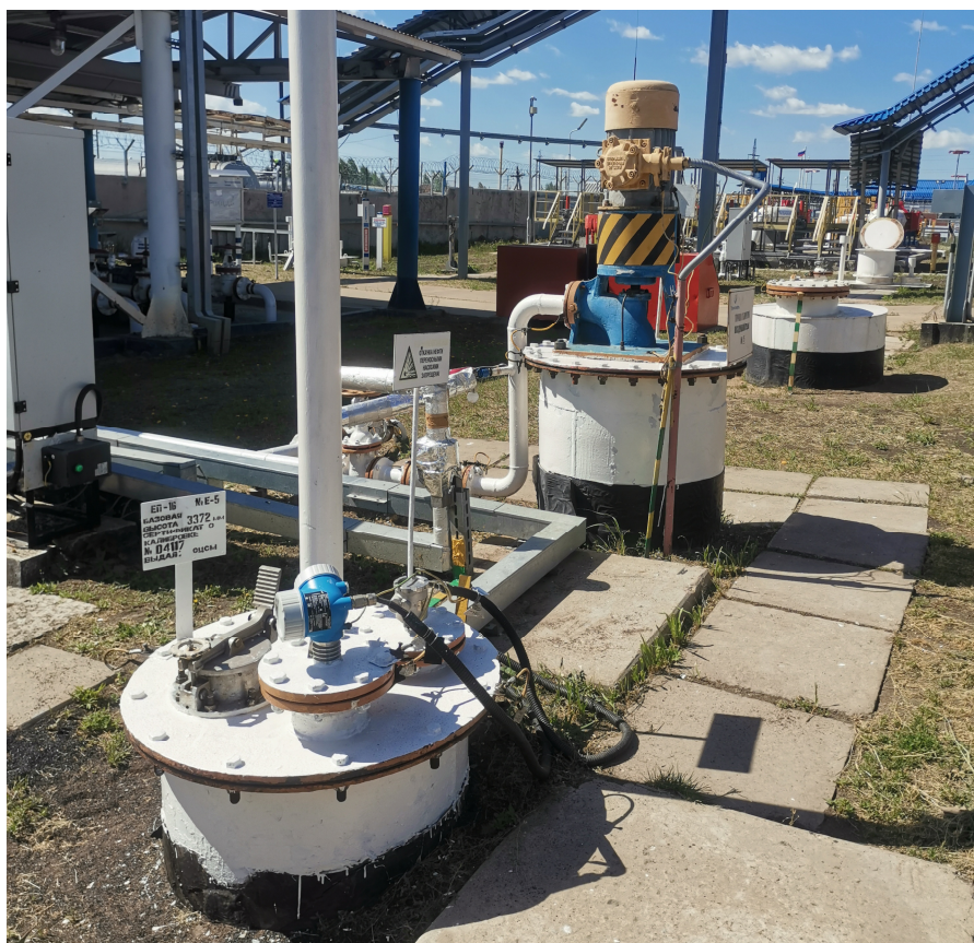
Рисунок 2 – Общий вид резервуара ЕП 16-2000-1300-2
