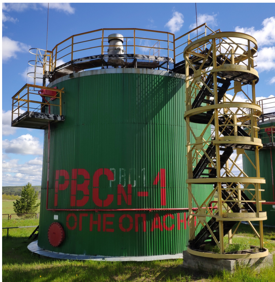
Рисунок 2 – Общий вид резервуара РВС-400
