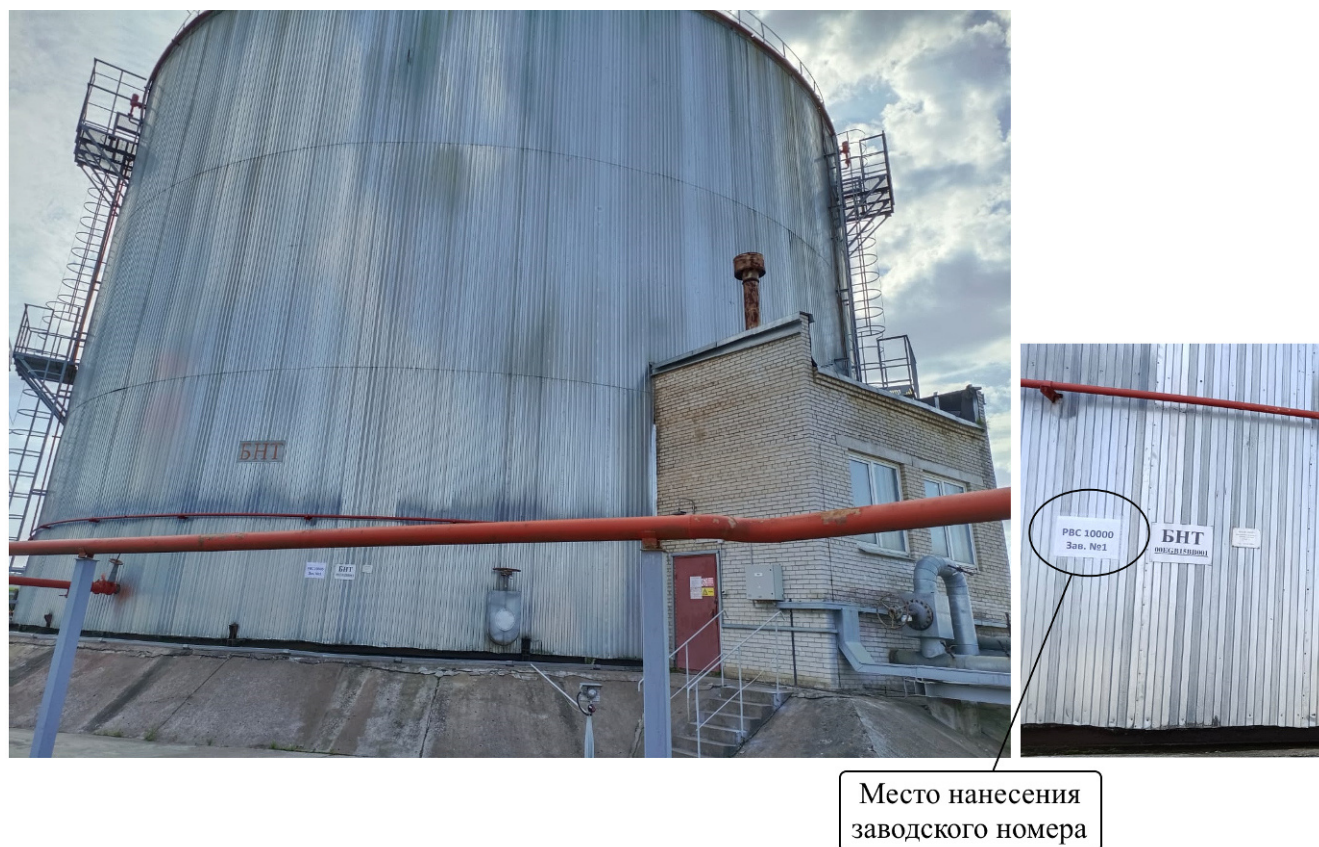
Рисунок 1 – Общий вид резервуара РВС-10000 №1 с указанием места нанесения заводского номера
