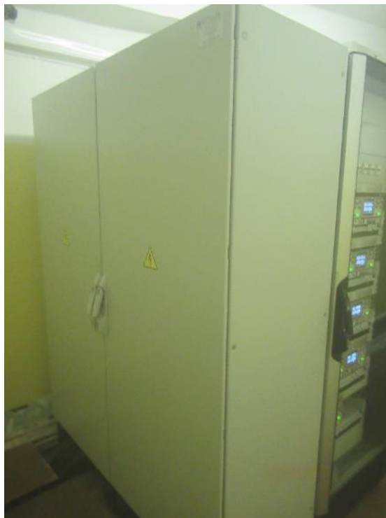
Рисунок 5 – Общий вид шкафа кроссового стендового комплекса СК 12 ИВК Персей
