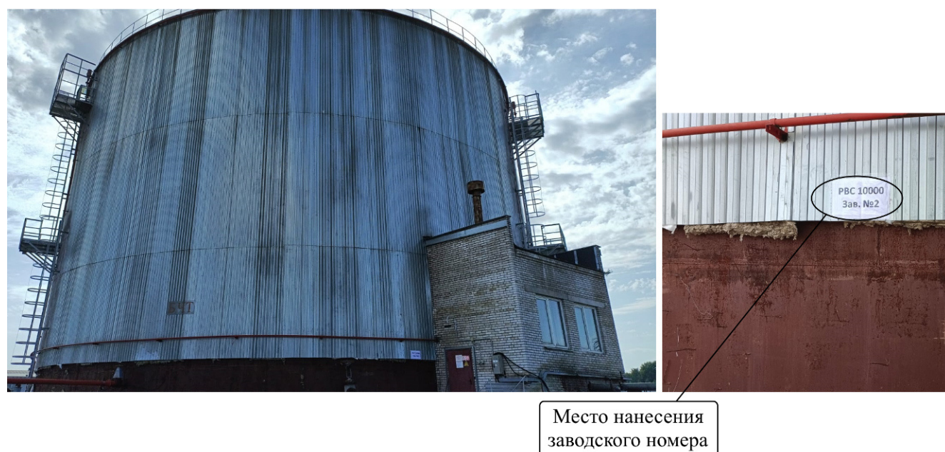
Рисунок 2 – Общий вид резервуара РВС-10000 №2 с указанием места нанесения заводского номера
