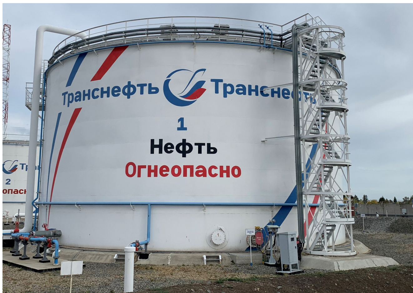
Рисунок 1 – Общий вид резервуара РВС-5000 №1
