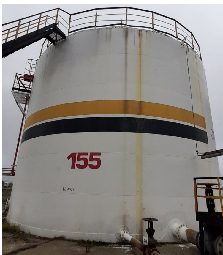
Рисунок 2 – Общий вид резервуара РВС-1000 №155
