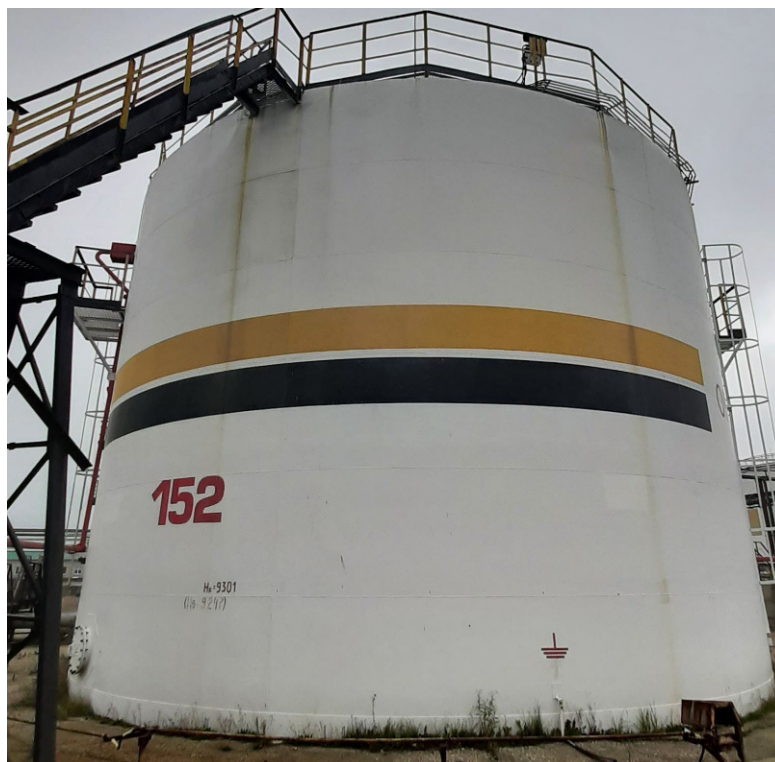
Рисунок 1 – Общий вид резервуара РВС-1000 №152
