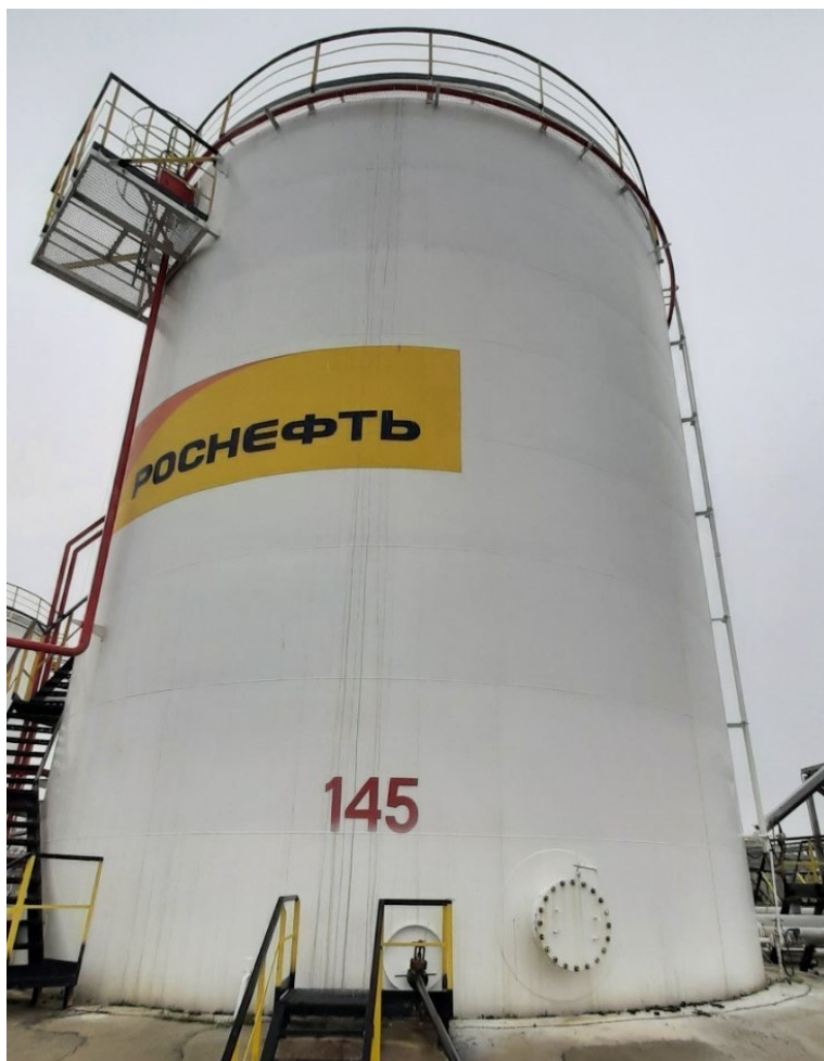
Рисунок 3 – Общий вид резервуара РВСП-1000 №145
