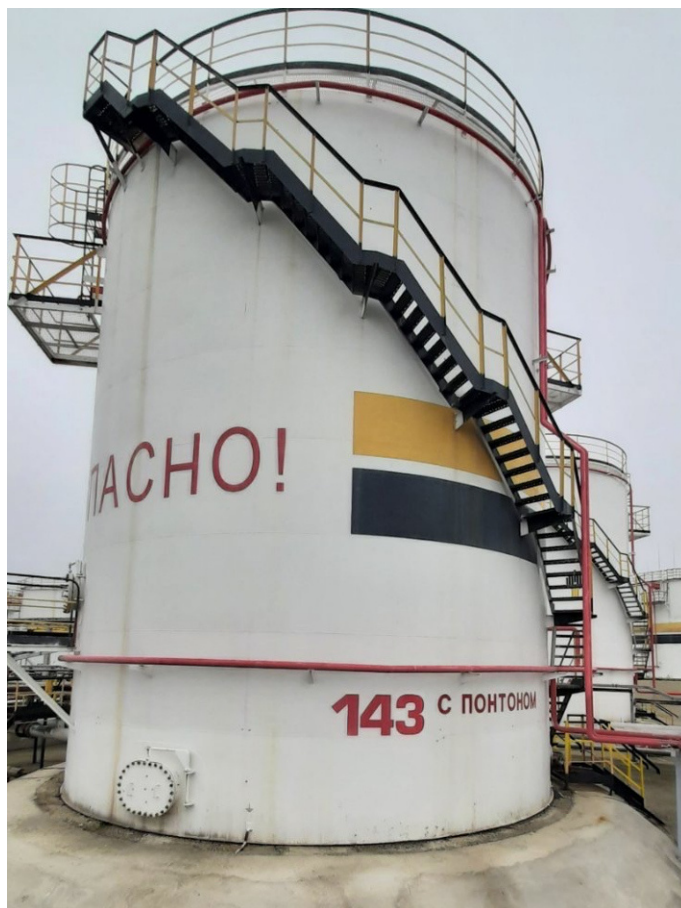
Рисунок 1 – Общий вид резервуара РВСП-1000 №143
