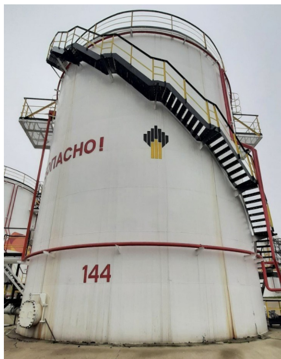
Рисунок 2 – Общий вид резервуара РВСП-1000 №144
