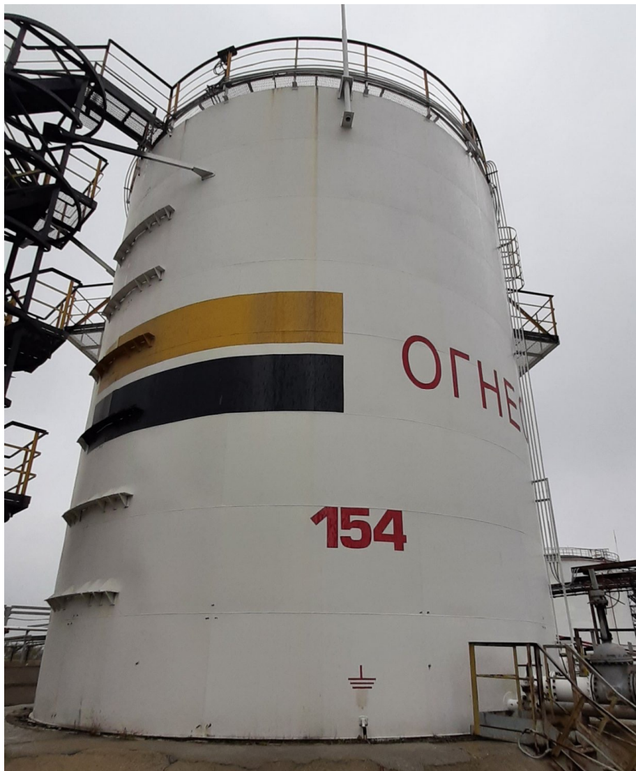
Рисунок 1 – Общий вид резервуара РВСП-1000 №154
