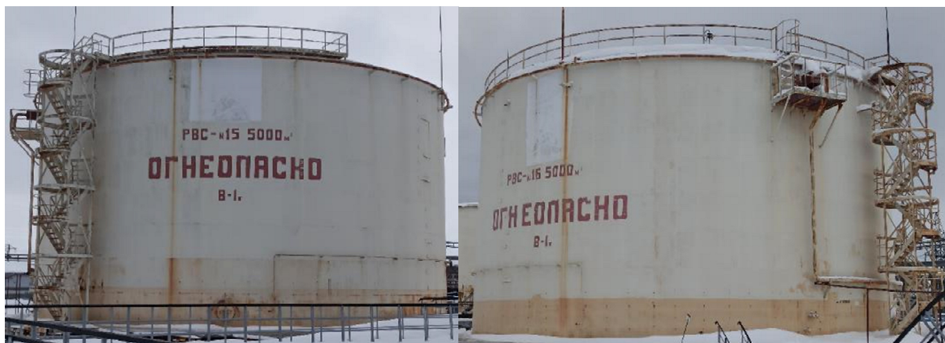
Рисунок 4 – Общий вид резервуаров с заводским номером 15 и 16
