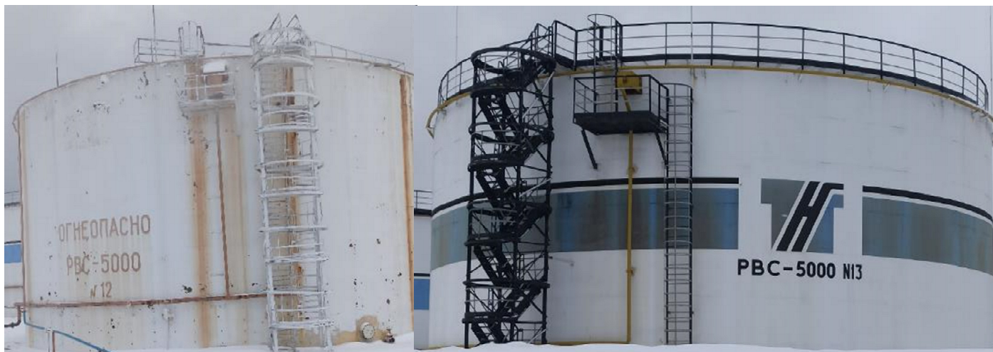
Рисунок 3 – Общий вид резервуаров с заводским номером 12 и 13
