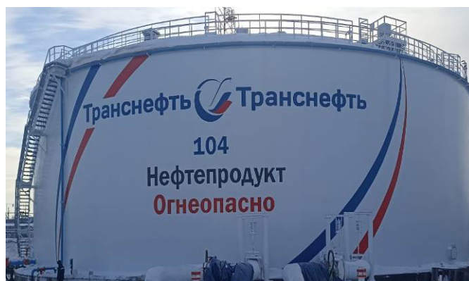
Рис. 4 – Общий вид РВС-20000 зав.№104
