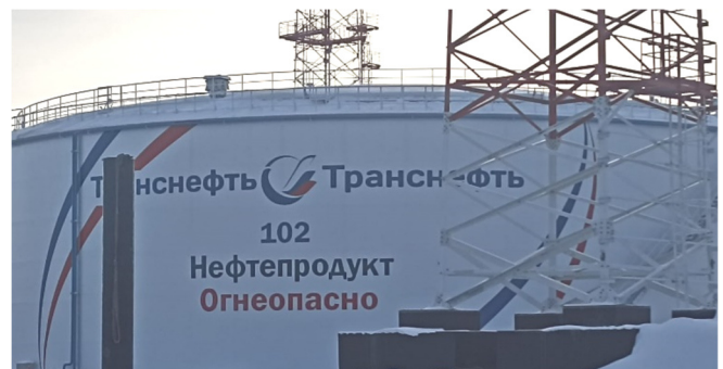
Рис. 2 – Общий вид РВС-20000 зав.№101
