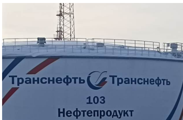
Рис. 3 – Общий вид РВС-20000 зав.№103
