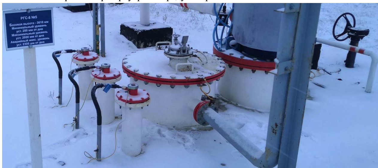
Рисунок 1 - Место нанесения заводского номера резервуара РГС-8
