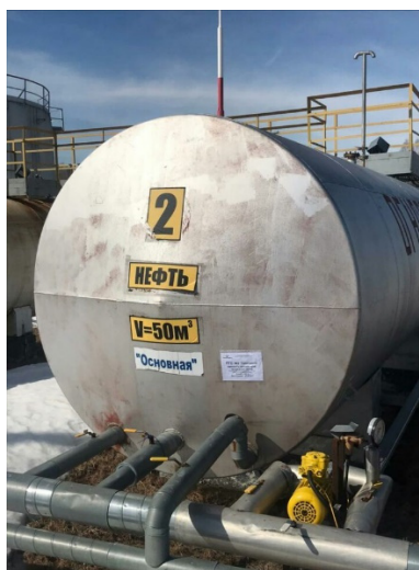
Рисунок 1 – Общий вид резервуаров РГС-50
