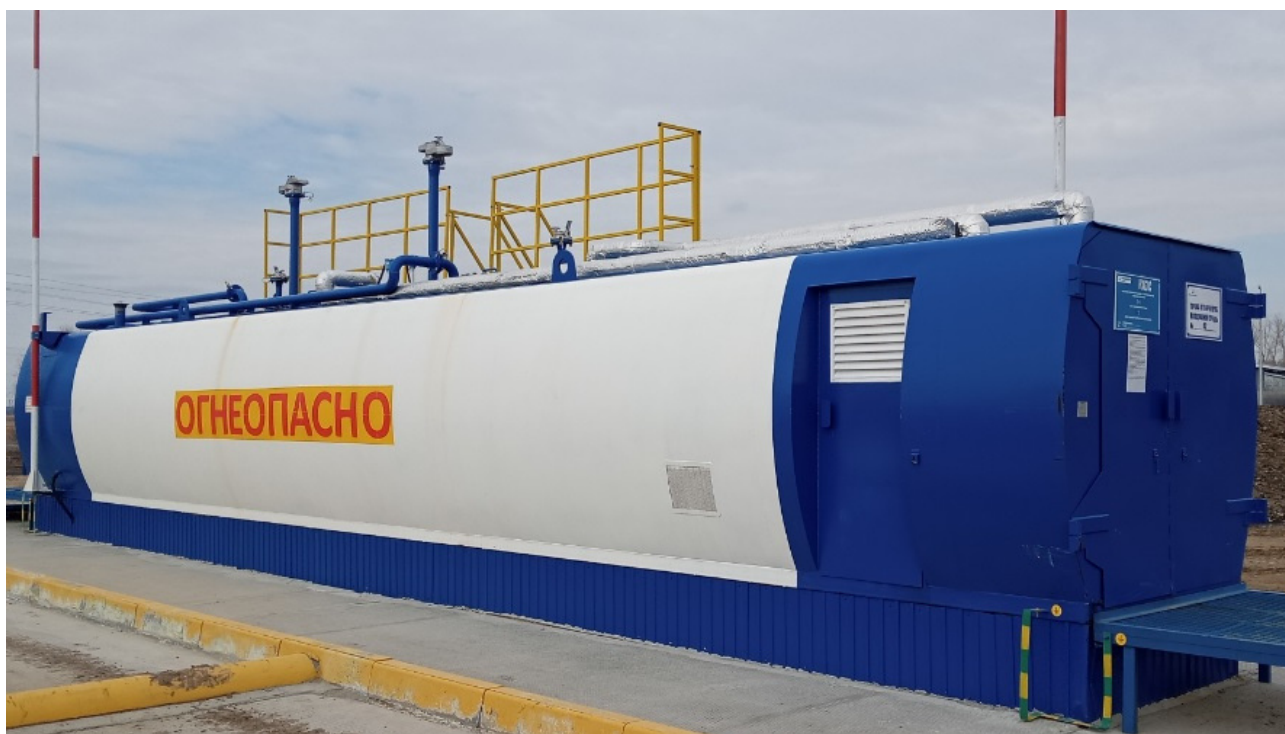
Рисунок 2 – Общий вид резервуара РГС-30
