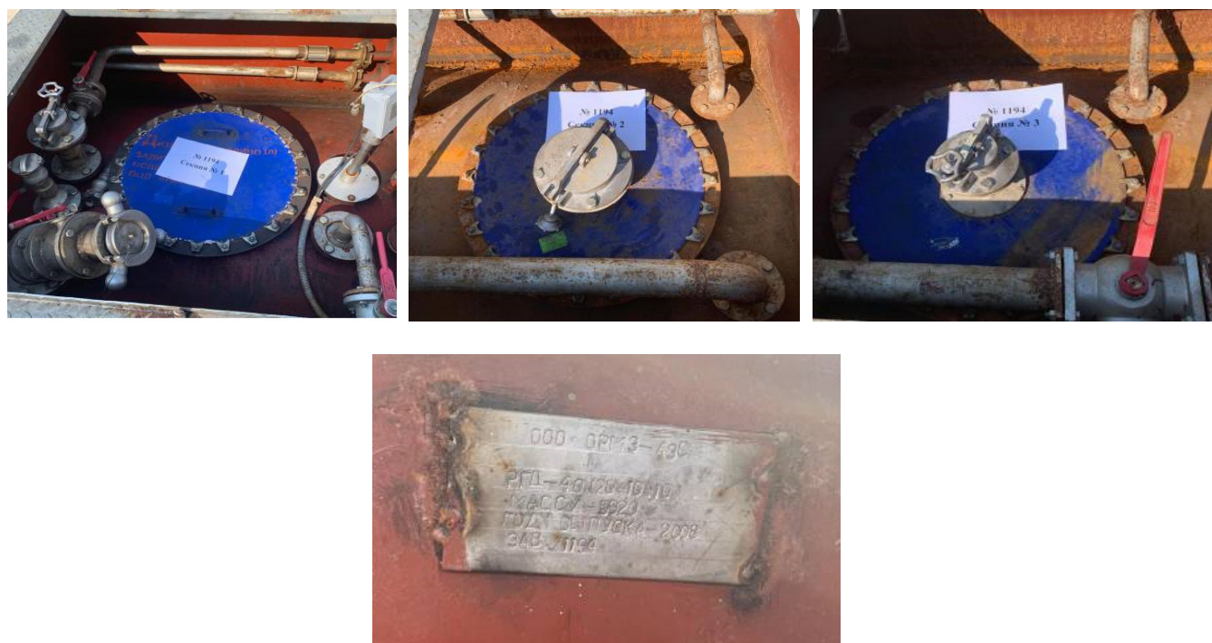
Рисунок 3 – Фото горловин, замерных люков и заводской номер резервуара РГД-40 № 1194
