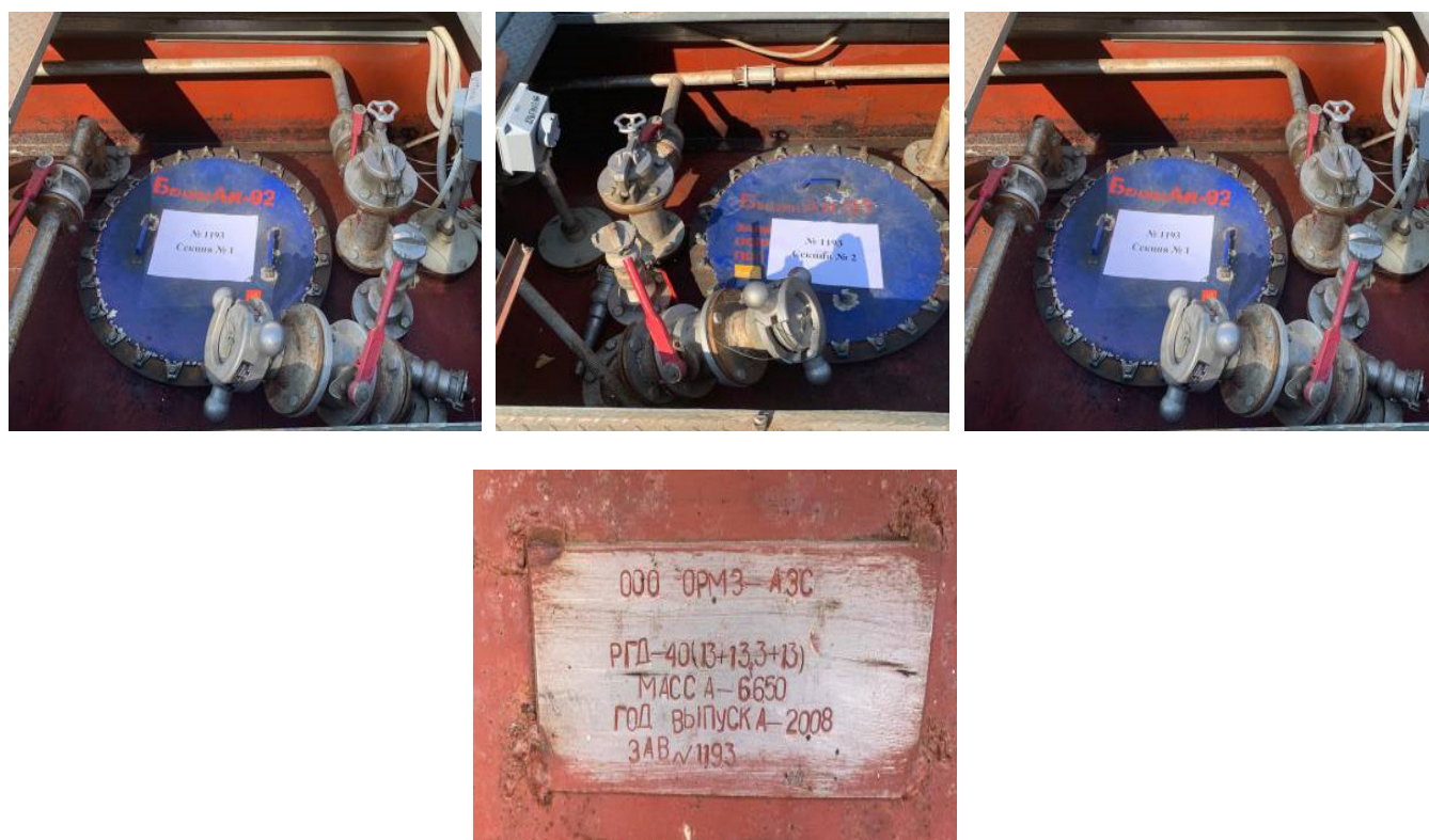
Рисунок 2 – Фото горловин, замерных люков и заводской номер резервуара РГД-40 № 1193
