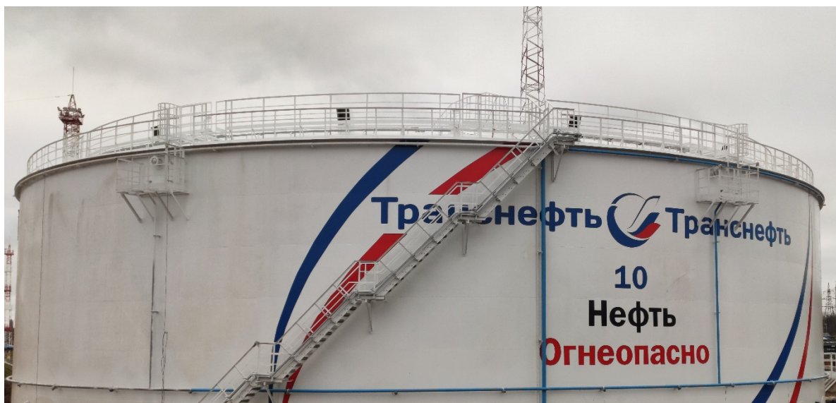
Рисунок 1 – Общий вид резервуара
