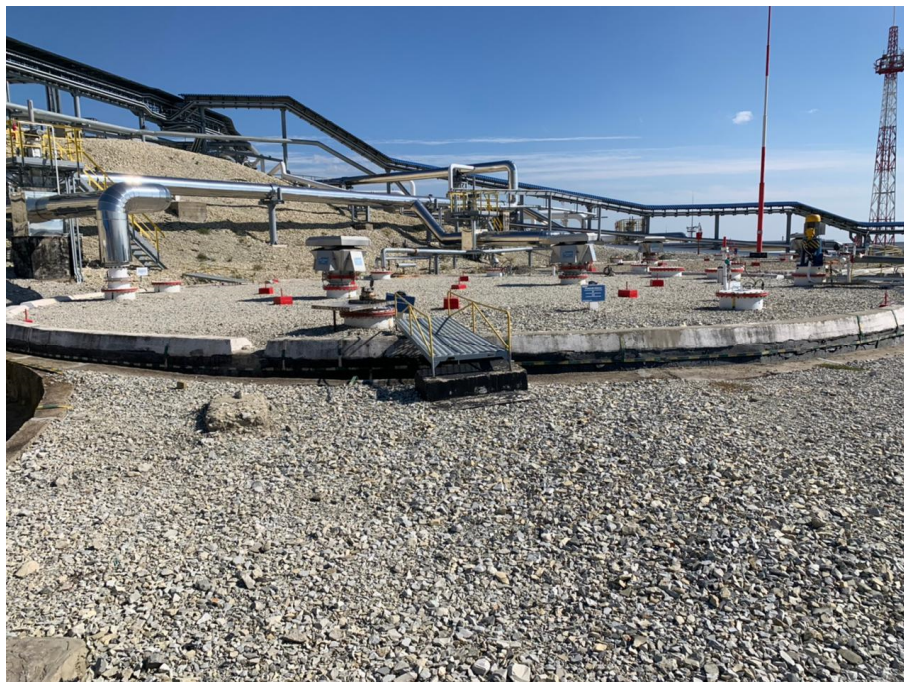
Рисунок 1 – Общий вид резервуаров
