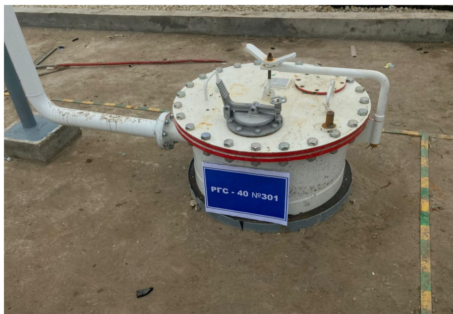
Рисунок 3 – Общий вид надземной части резервуара РГС-40 № 301
