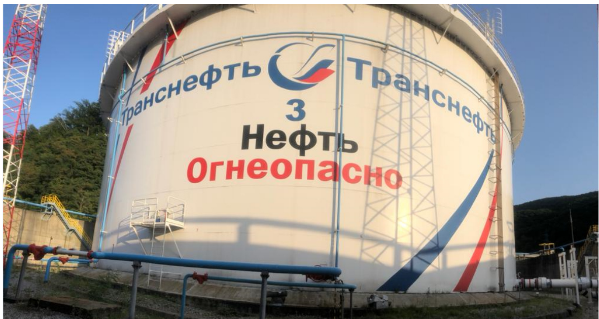
Рисунок 1 – Общий вид резервуара
