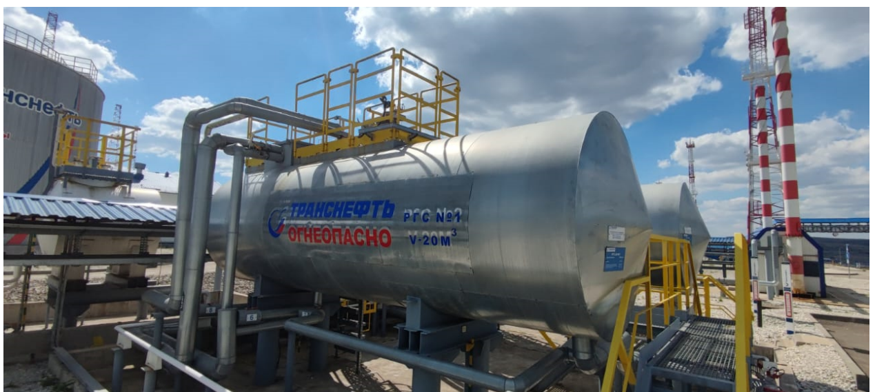
Рисунок 1 – Общий вид резервуаров РГС-20
