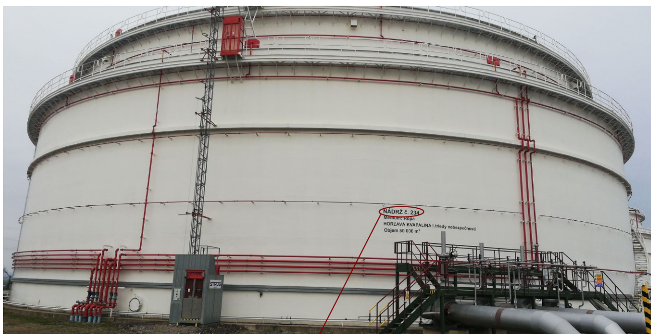
Рисунок 1 – Общий вид резервуара РВСПК-50000 зав.№ 233 с указанием места нанесения заводского номера
