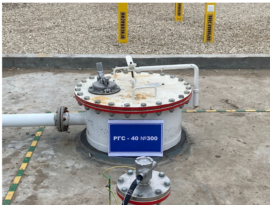
Рисунок 2 – Общий вид надземной части резервуара РГС-40 № 300
