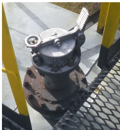
Рисунок 2 – Фотография замерного люка резервуара вертикального стального цилиндрического РВСП-3000
