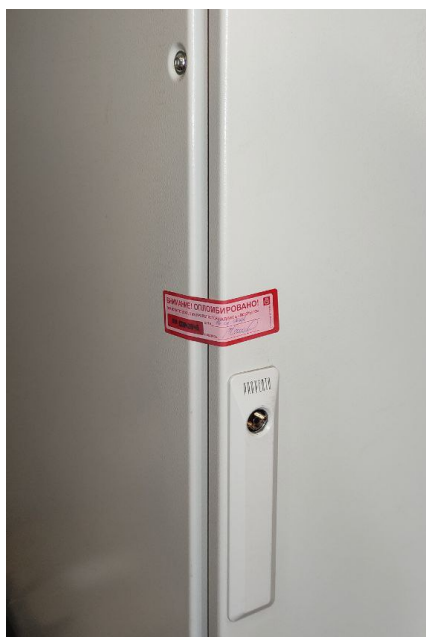
Рисунок 4 – Схема пломбировки шкафа СОИ
