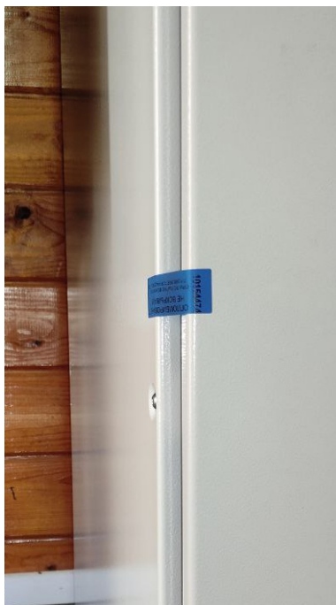
Рисунок 4 – Схема пломбировки шкафа СОИ
