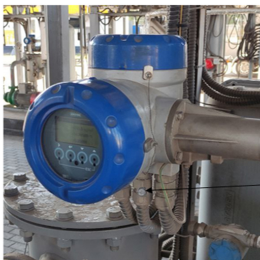
Рисунок 5 – Схема пломбировки преобразователем сигналов MFC 400C OPTIMASS
