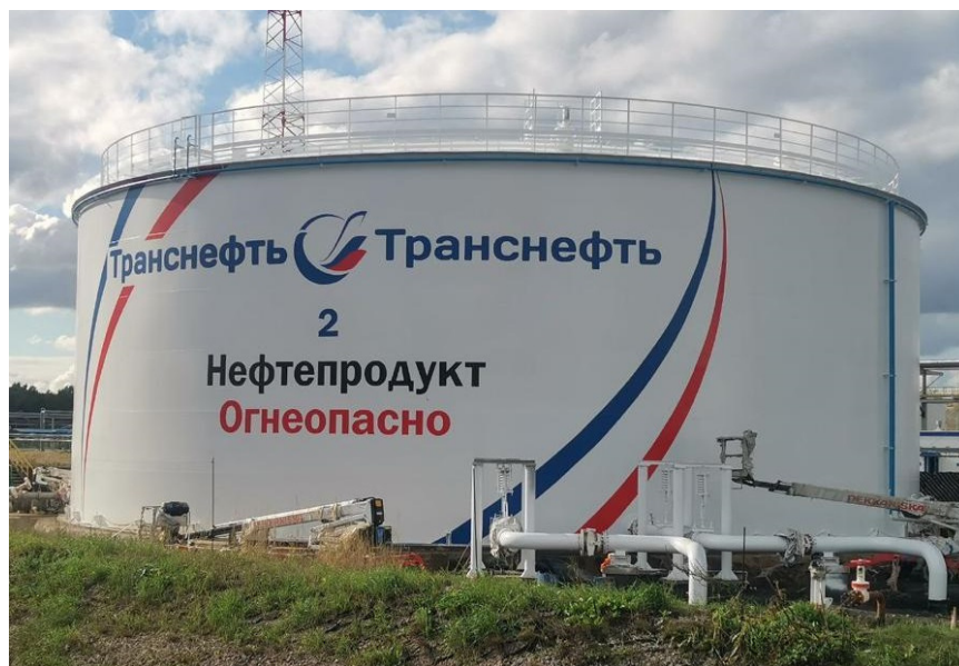
Рисунок 1 – Общий вид резервуара
