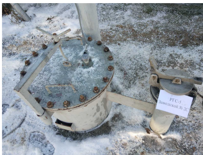
Рисунок 6 – Общий вид резервуара РГС-5 № 2С
