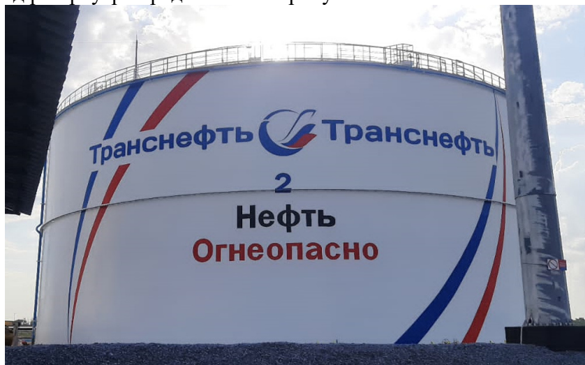
Рисунок 1 – Общий вида резервуара РВС-20000
