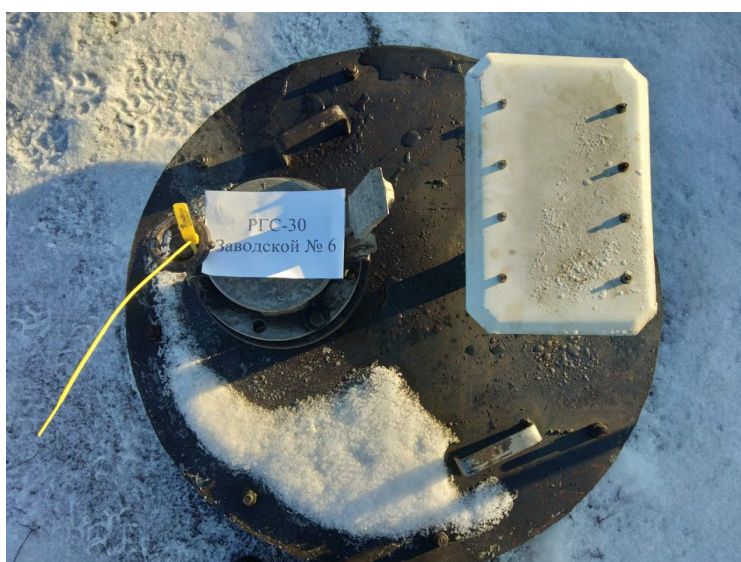
Рисунок 3 – Общий вид резервуара РГС-30 № 6
