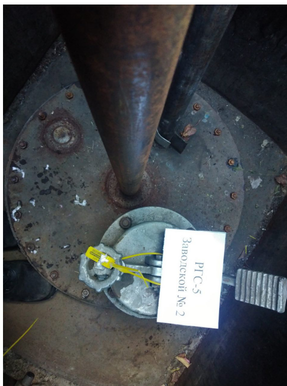
Рисунок 3 – Общий вид резервуара РГС-5 № 2
