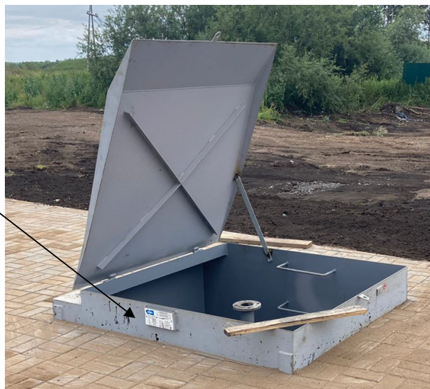
Рисунок 4 – Место нанесения заводских номеров на резервуары горизонтальные стальные РГСП-50
