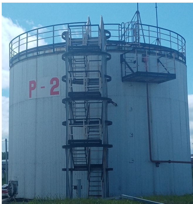
Рисунок 1 – Общий вид резервуара РВС-1000
