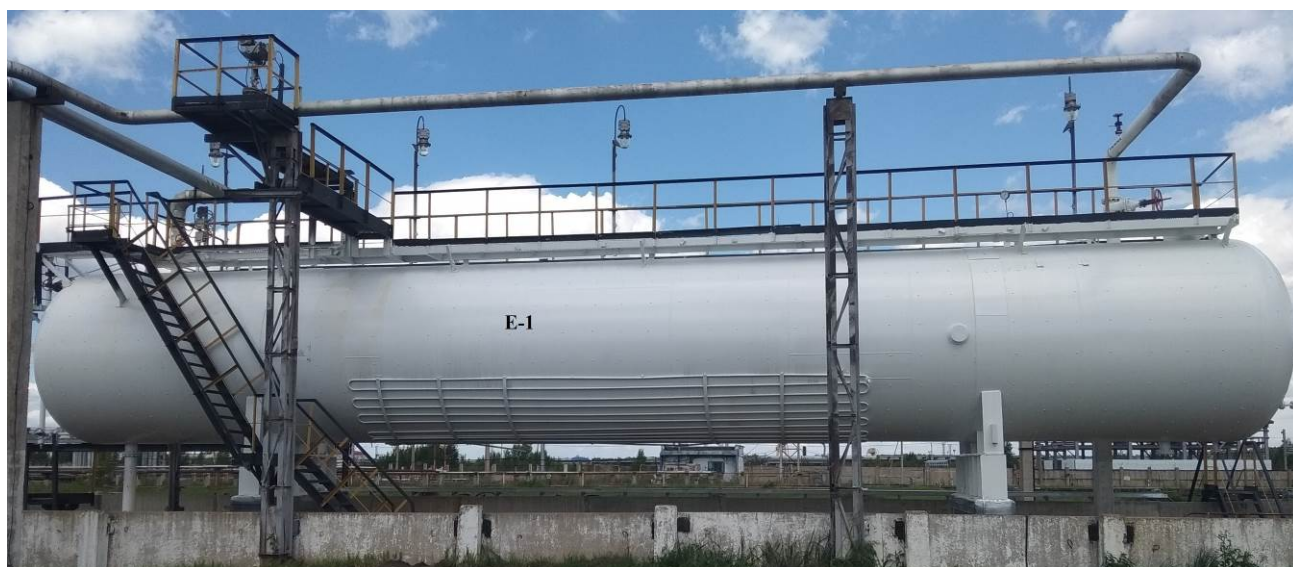
Рисунок 1 – Общий вид резервуара РГС-200
