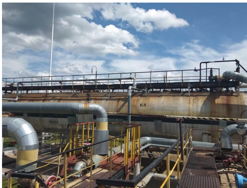
Рисунок 1 – Общий вид резервуаров РГС-200
