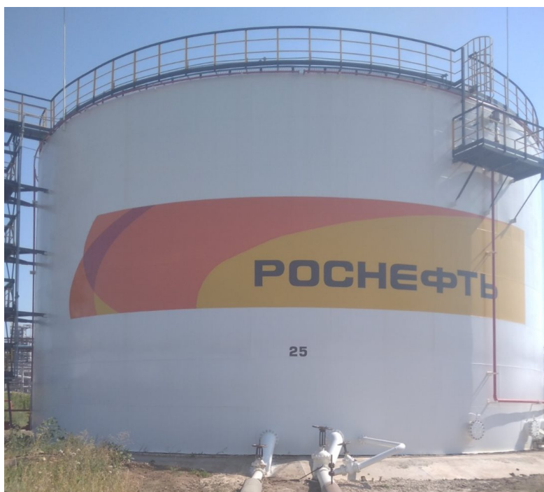
Рисунок 1 – Общий вид резервуаров РВС-5000
