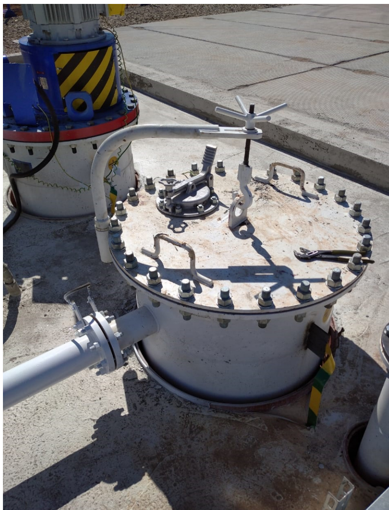
Рисунок 3 – Горловины и измерительный люк резервуара
