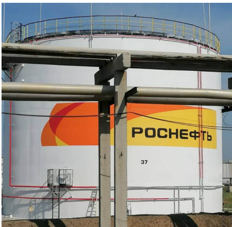
Рисунок 1 – Общий вид резервуара РВСП-5000
