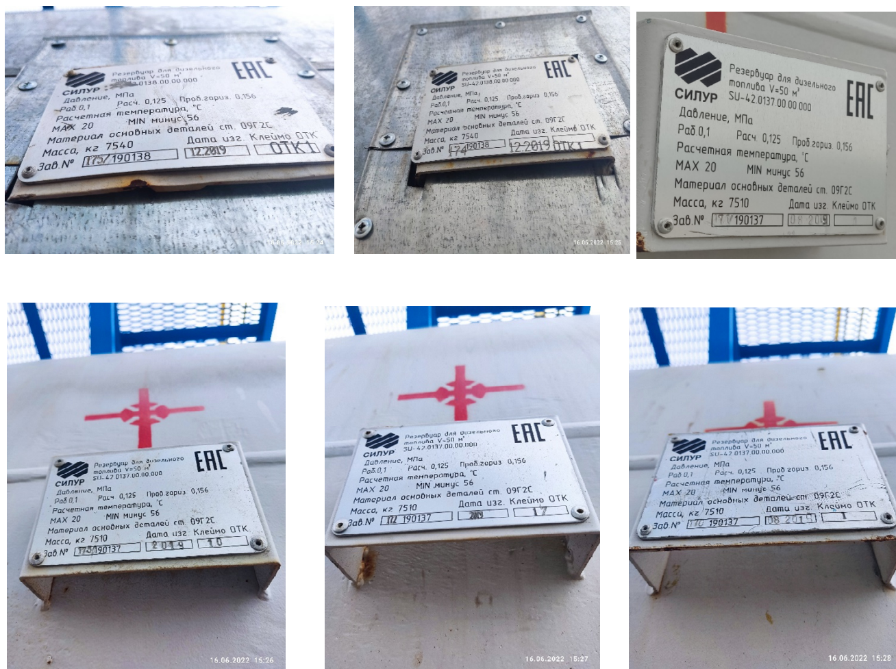
Рисунок 2 - Место крепления и внешний вид металлических табличек с нанесенными на них заводскими номерами
