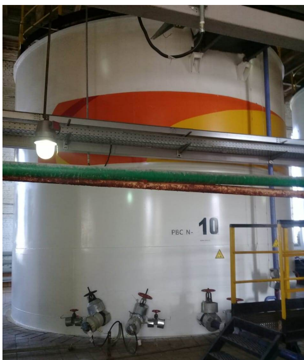
Рисунок 1 – Общий вид резервуаров РВС-200
