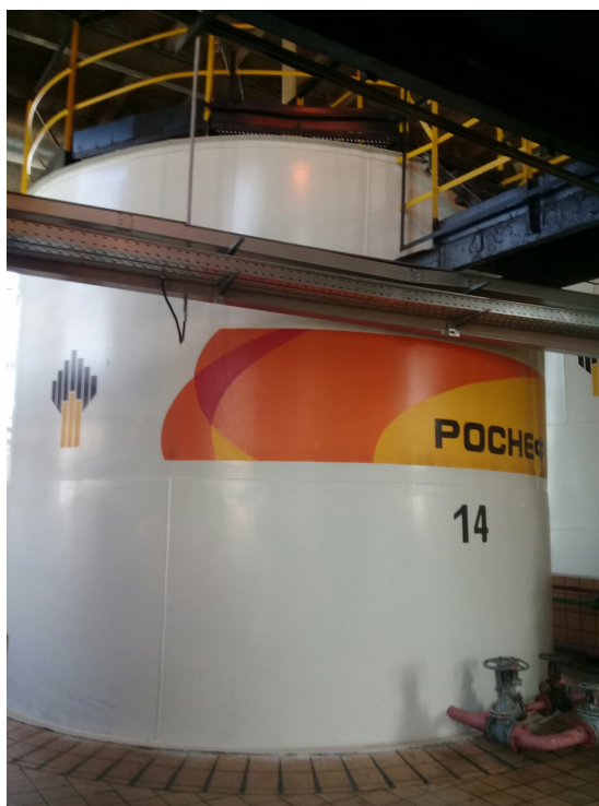
Рисунок 1 – Общий вид резервуара РВС-100
