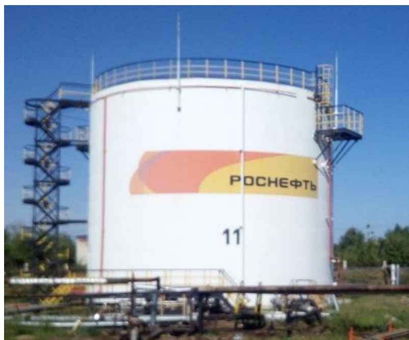
Рисунок 1 – Общий вид резервуара РВС-2000
