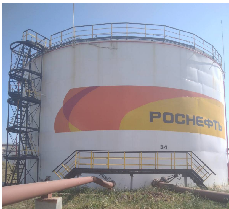
Рисунок 1 – Общий вид резервуара РВС-5000
